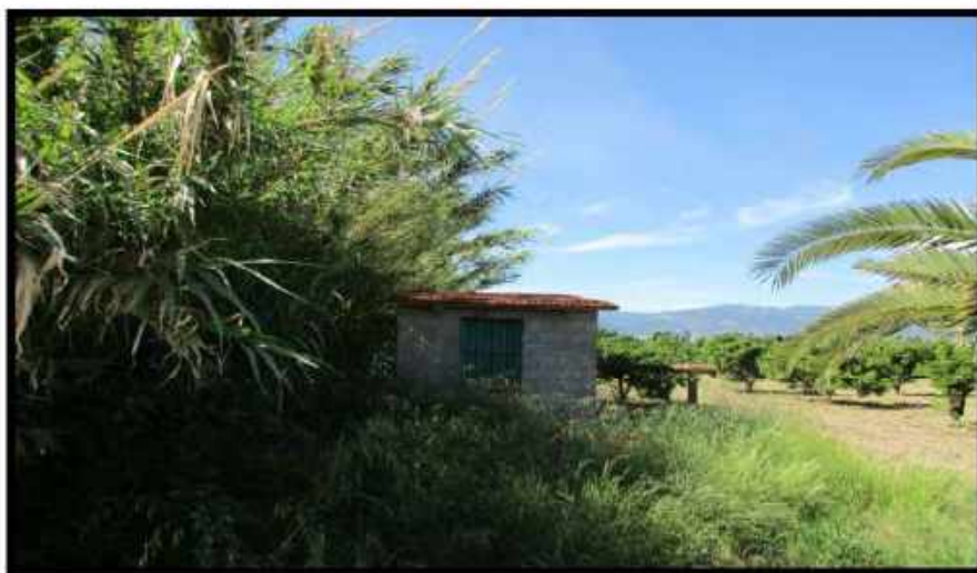
Foto. n. 1 – Stazione di sollevamento
