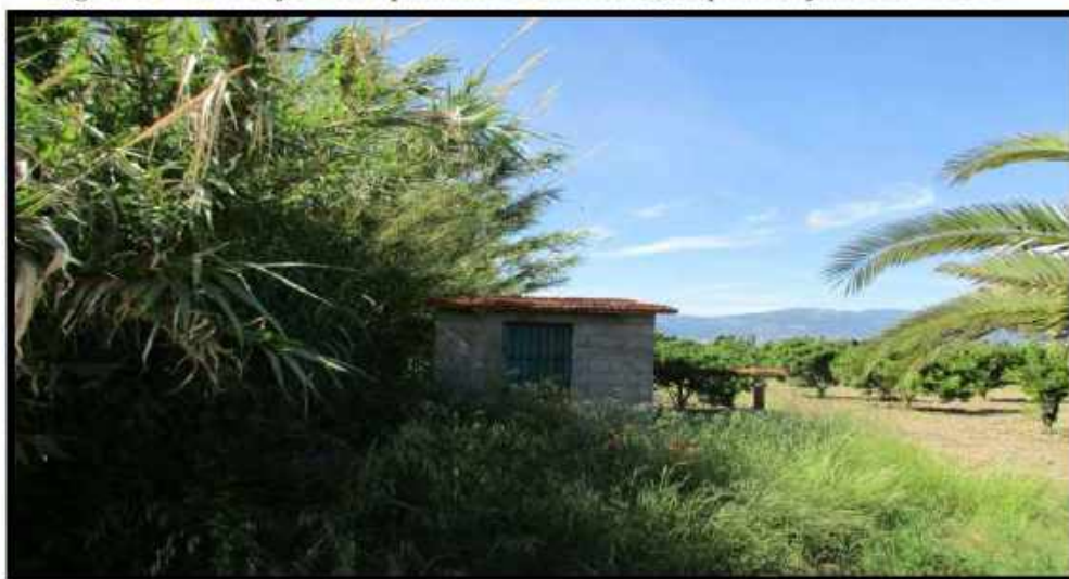
Foto. n. 12 – Fabbricato abusivo ospitante la stazione di sollevamento
