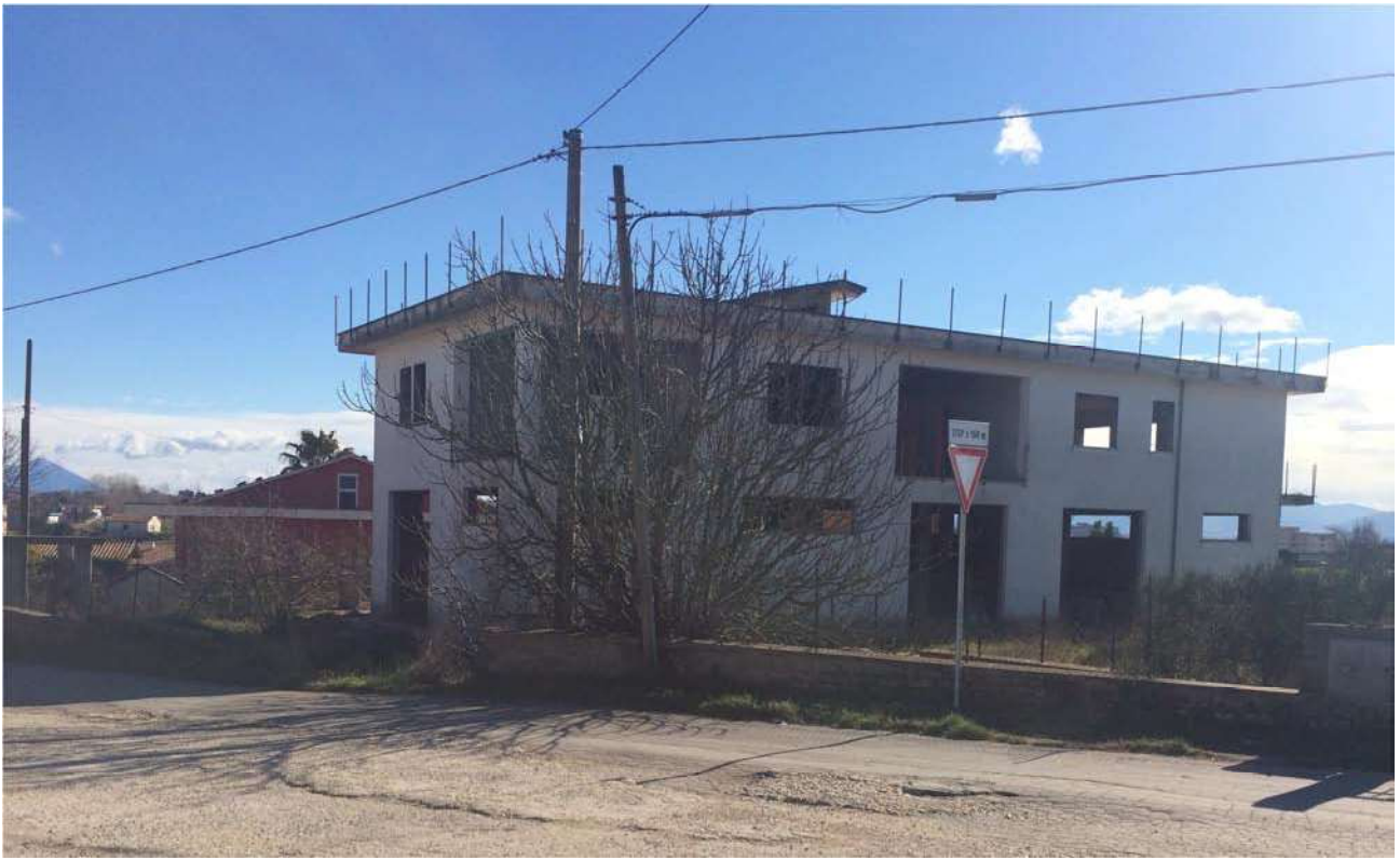
LOTTO N° 2 – EDIFICIO IN CORSO COSTRUZIONE
