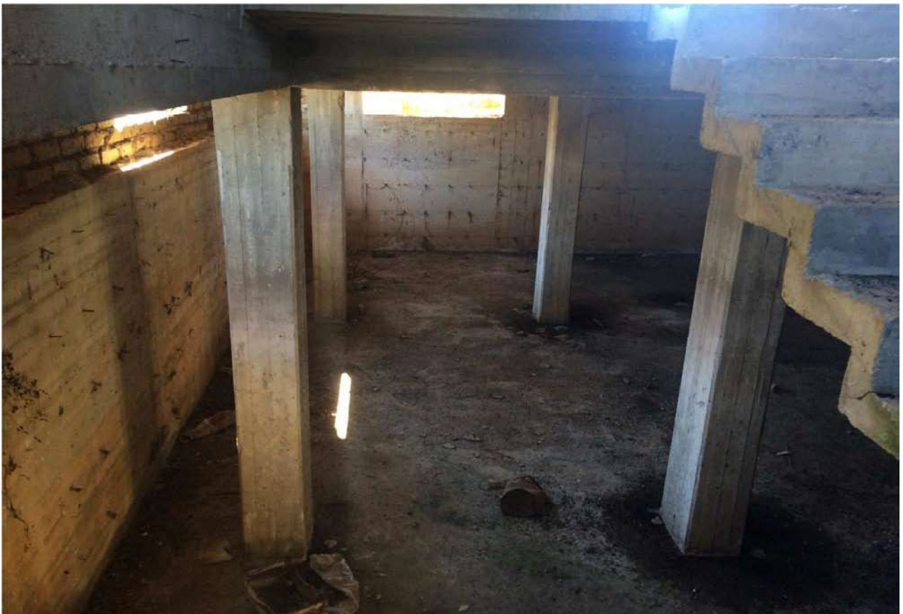
LOTTO N° 2 – EDIFICIO PIANO INTERRATO
