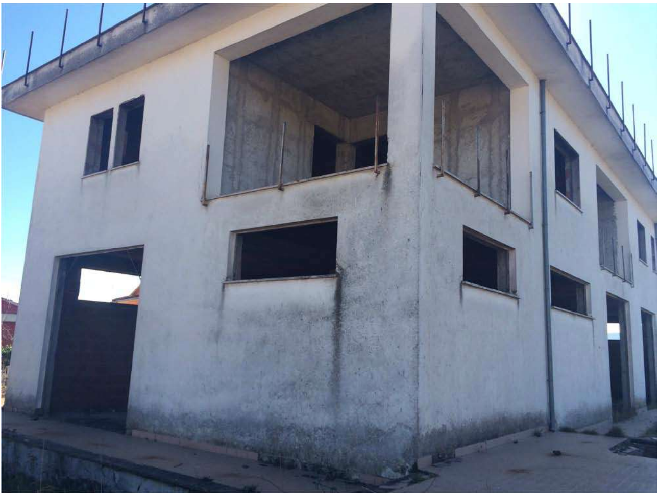
LOTTO N° 2 – EDIFICIO IN CORSO COSTRUZIONE
