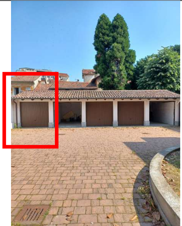
Immagine 14 - Blocco autorimesse da corte interna
