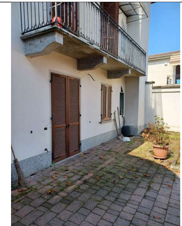
Immagine 16 - Area esterna pertinenziale
