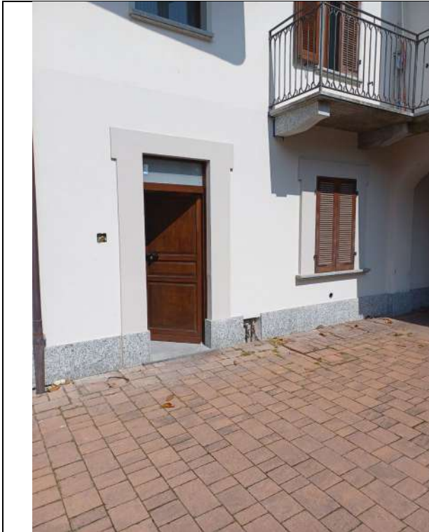
Immagine 5 - Ingresso da corte interna, non esclusivo, comune con appartamento al piano primo
