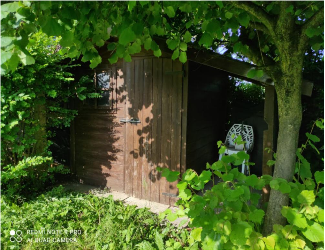
Fig.14-CASETTA PER GLI ATTREZZI DA GIARDINO IN LEGNO DA RIMUOVERE/DEMOLIRE
