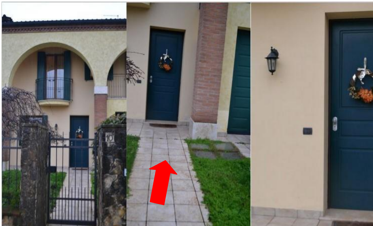
Fig.20-21-22- INGRESSO CHIUSO DALL'INTERNO DELL'ABITAZIONE CON PANNELLO IN CARTONGESSO;
