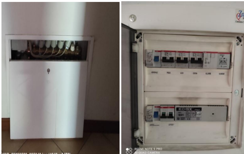
Figure 87-88- PIANO TERRA- STATO IMPIANTI: COLLETTORI- QUADRO ELETTRICO
