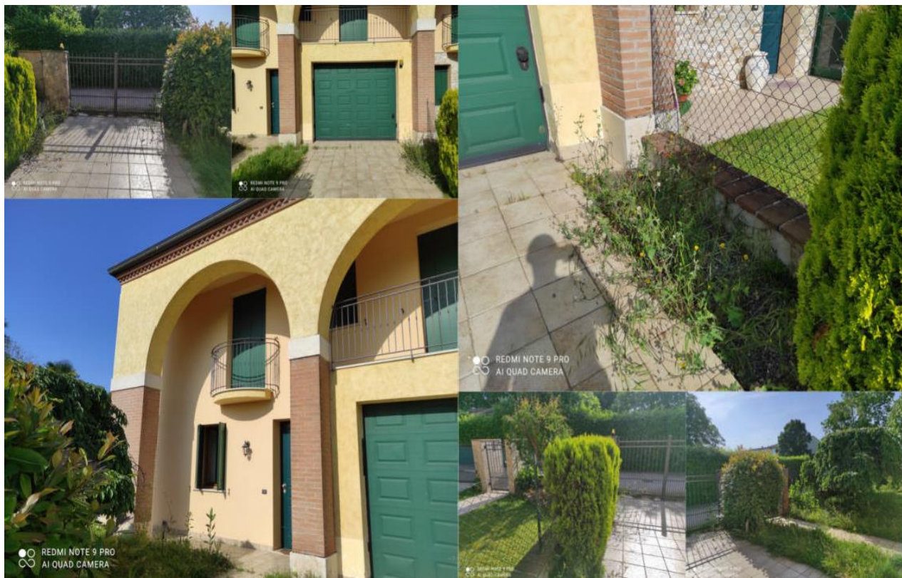
Fig.94-95-96-97-98- PIANO TERRA-ACCESSO CARRAIO AL GARAGE-BASCULANTE;
