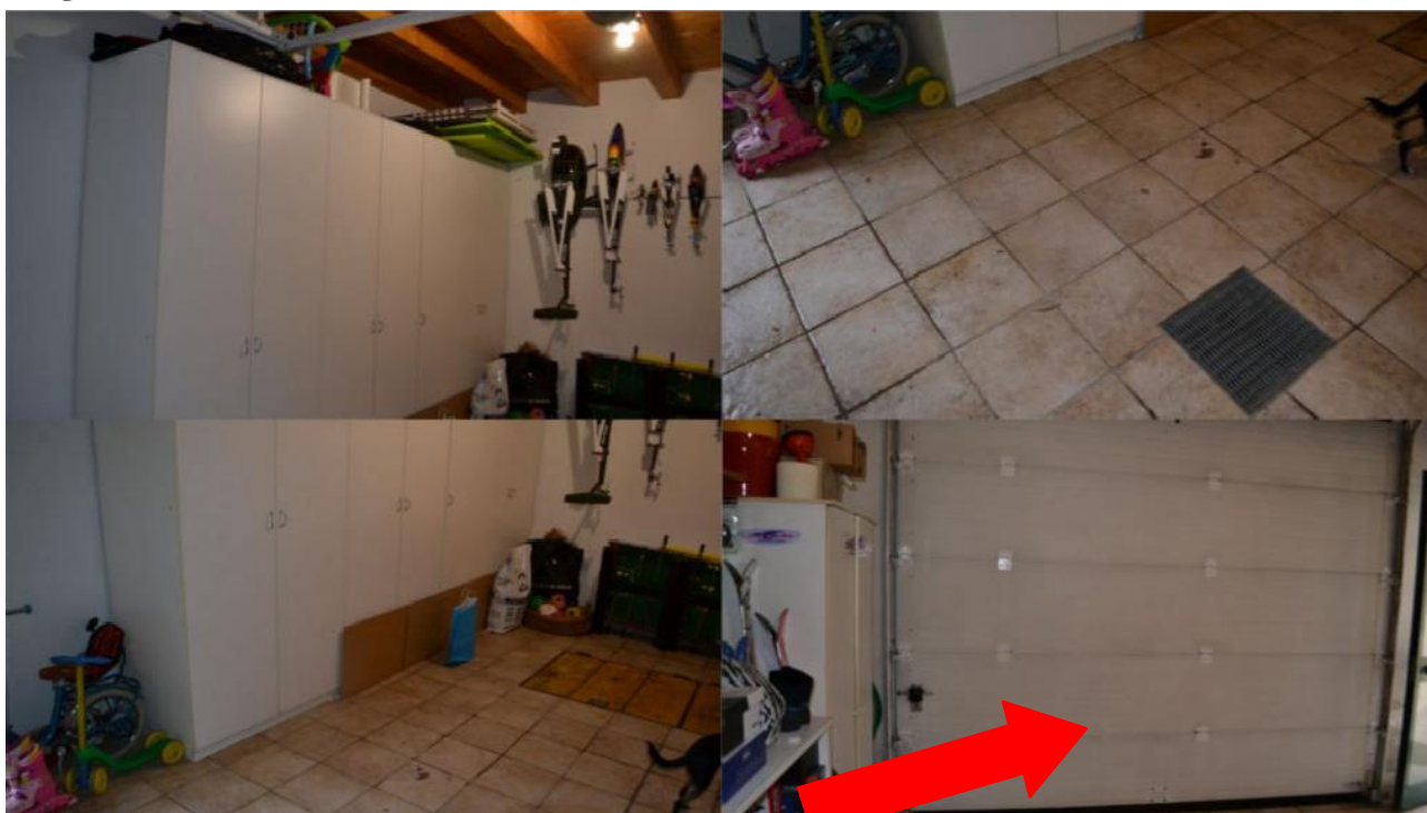
Fig.99-100-101-102- PIANO TERRA-INGRESSO AL GARAGE;
