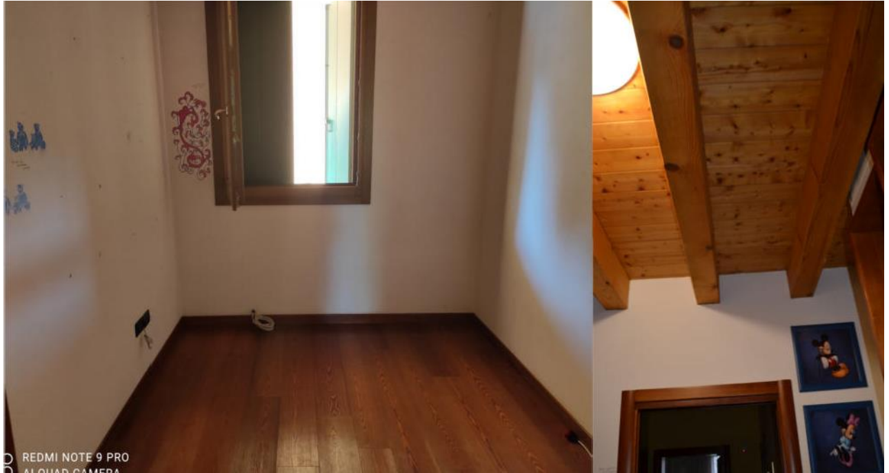
Figure 57-58- 1° PIANO- RIPOSTIGLIO- DETTAGLIO SOLAIO IN LEGNO CON TRAVI A VISTA;
