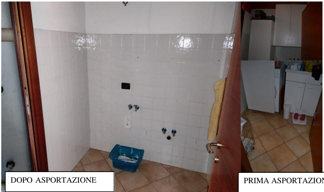
Figure 43-44-45- PIANO TERRA-LAVANDERIA DOPO ASPORTAZIONE MOBILIO-LAVANDERIA ATTREZZATA DURANTE SOPRALLIOGO DEL 13 DICEMBRE 2022;
