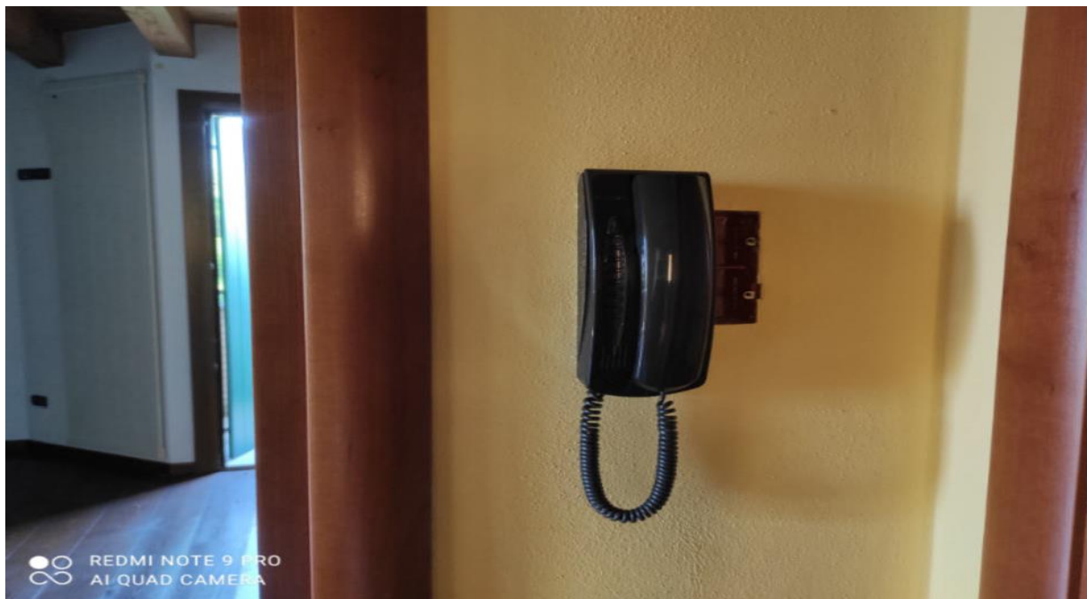
Figure 86-86°- PIANO TERRA- STATO IMPIANTI IN CUCINA DURANTE SOPRALLIOGO DEL 13 DICEMBRE 2022- STATO IMPIANTI IN CUCINA DOPO ASPORTAZIONE MOBILIO-MAGGIO 2023;
