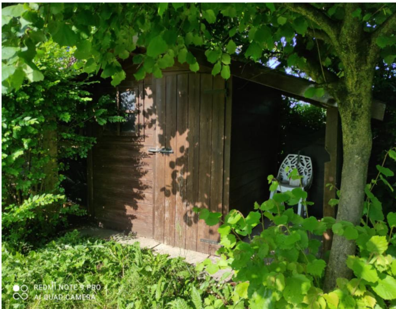
Fig.17-CASETTA PER GLI ATTREZZI DA GIARDINO IN LEGNO DA RIMUOVERE/DEMOLIRE
