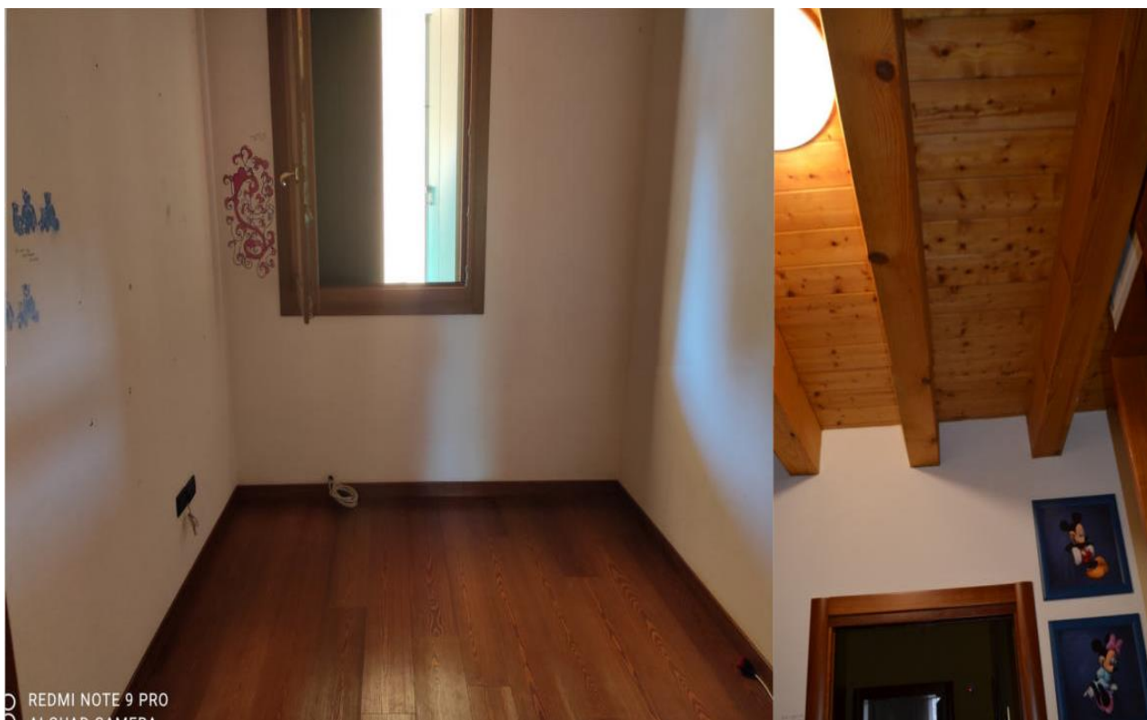
Figure 59-60- 1° PIANO- RIPOSTIGLIO- DETTAGLIO SOLAIO IN LEGNO CON TRAVI A VISTA;
