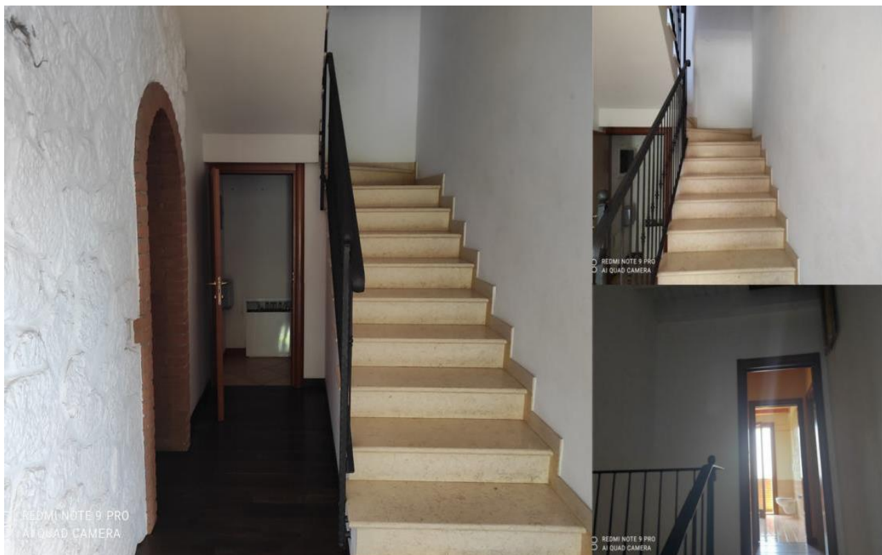
Fig. 48-49-50- PIANO TERRA-SCALA DI COLLEGAMENTO AL PIANO PRIMO;
