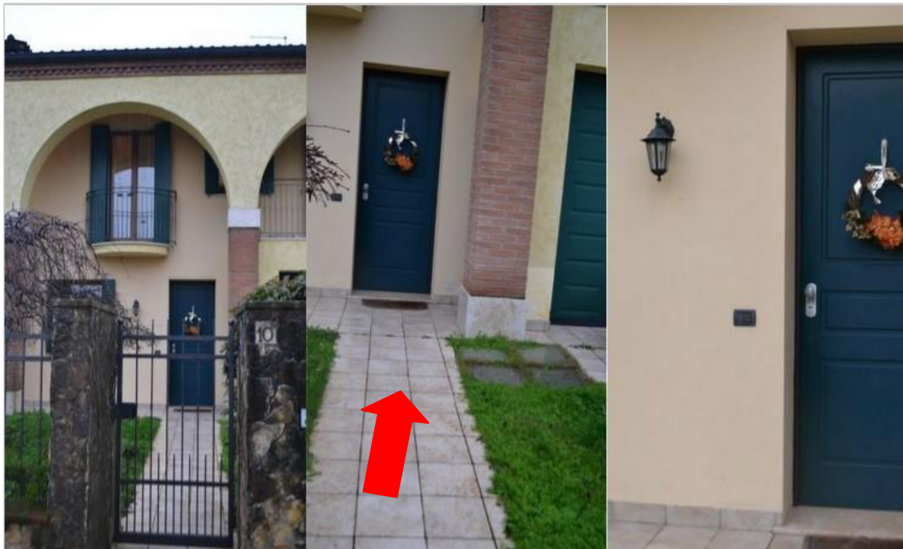
Fig.24-25-26- INGRESSO CHIUSO DALL'INTERNO DELL'ABITAZIONE CON PANNELLO IN CARTONGESSO;
