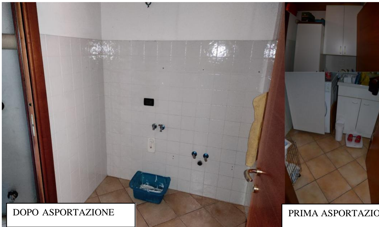
Figure 45-46-47- PIANO TERRA-LAVANDERIA DOPO ASPORTAZIONE MOBILIO-LAVANDERIA ATTREZZATA DURANTE SOPRALLIOGO DEL 13 DICEMBRE 2022;
