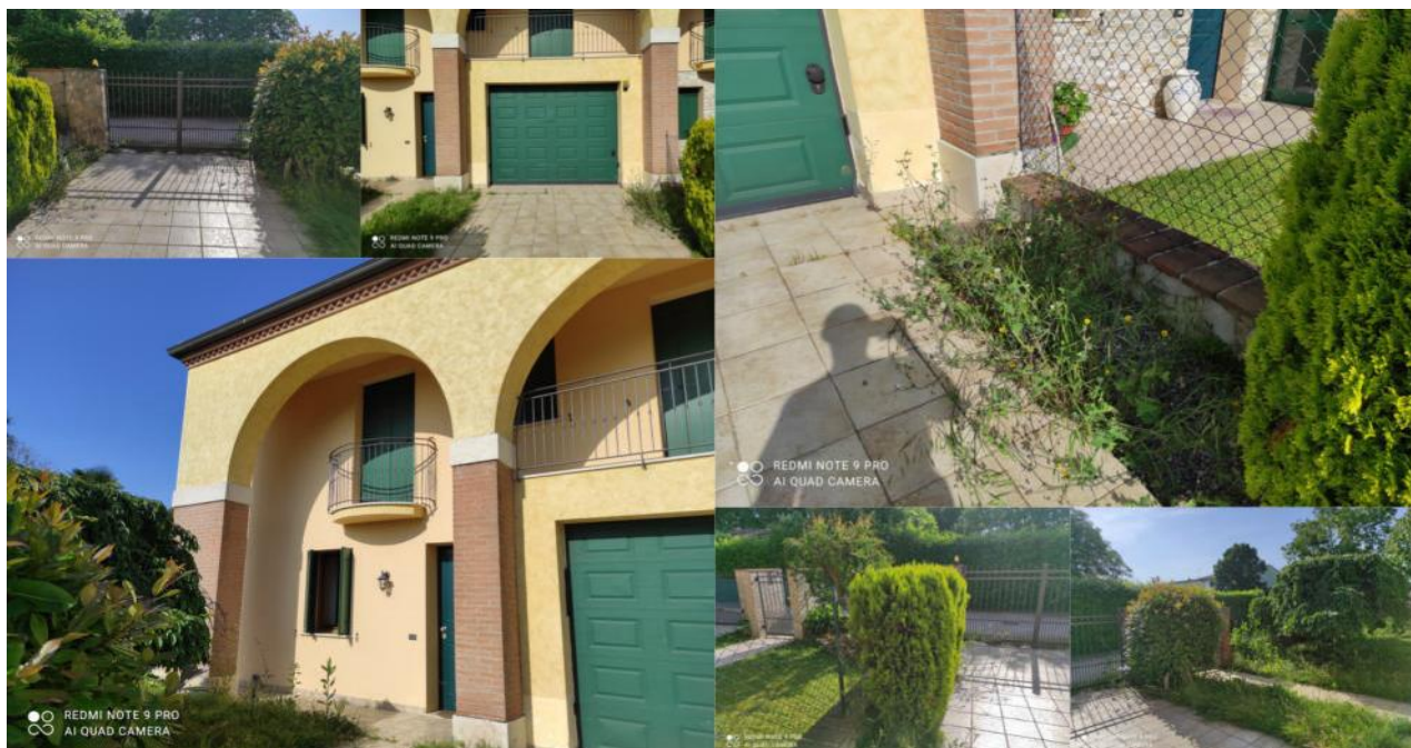
Fig.94-95-96-97-98- PIANO TERRA-ACCESSO CARRAIO AL GARAGE-BASCULANTE;
