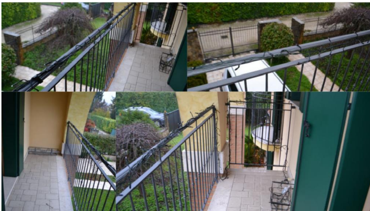
Figure 55-56-57-58- 1° PIANO -TERRAZZA CAMERA NORD -EST;
