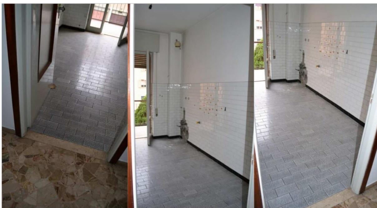
**Figure 27-28-29- CUCINA-Parete predisposta con attacchi idrici e gas**
