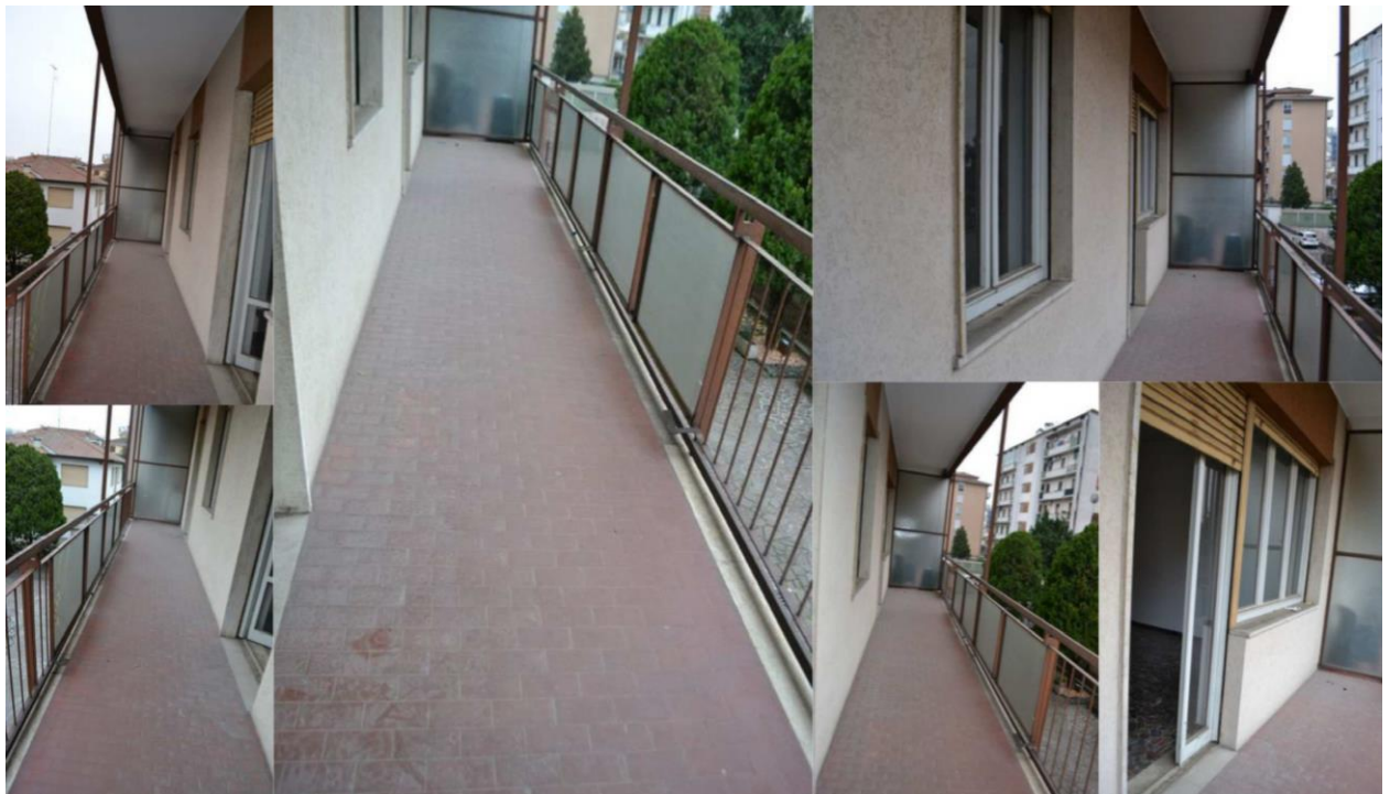
Figure 32-33-34-35-36-37- Terrazza con accesso esterno dalla cucina e dal soggiorno, pavimentata con listoncini in cotto
