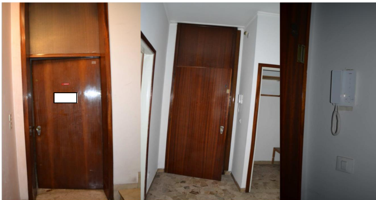
Figure 21-22-23- Porta d'ingresso blindata
