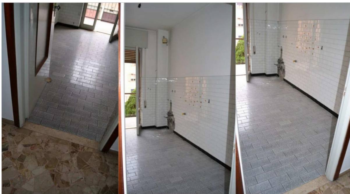
Figure 27-28-29- CUCINA-Parete predisposta con attacchi idrici e gas
