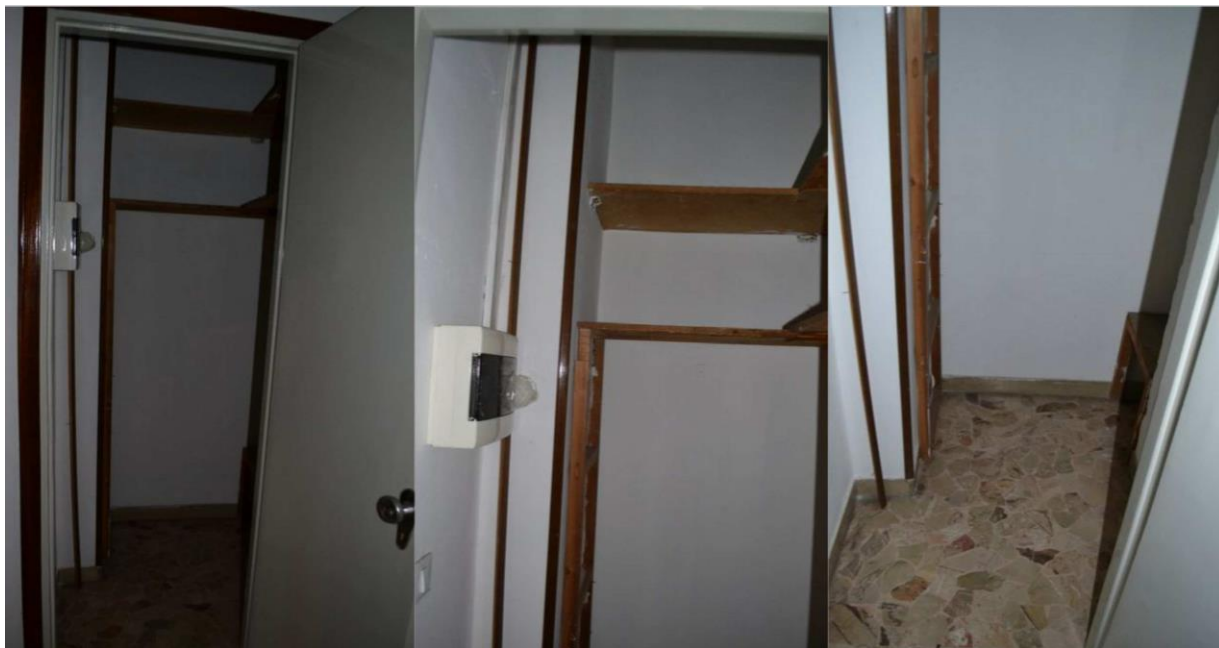
Figure 24-25-26- RIPOSTIGLIO INGRESSO-QUADRO ELETTRICO
