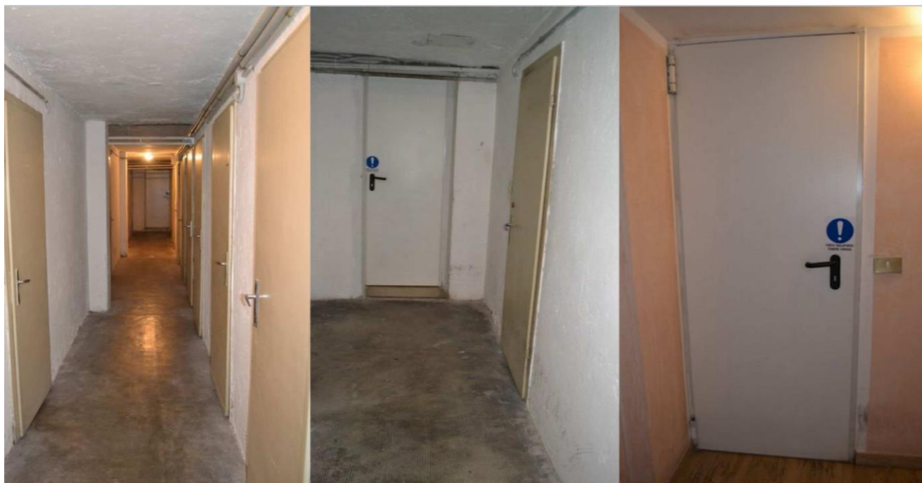
Figura 64-65-66-P.T.-Corridoio condominiale che conduce all'autorimessa
