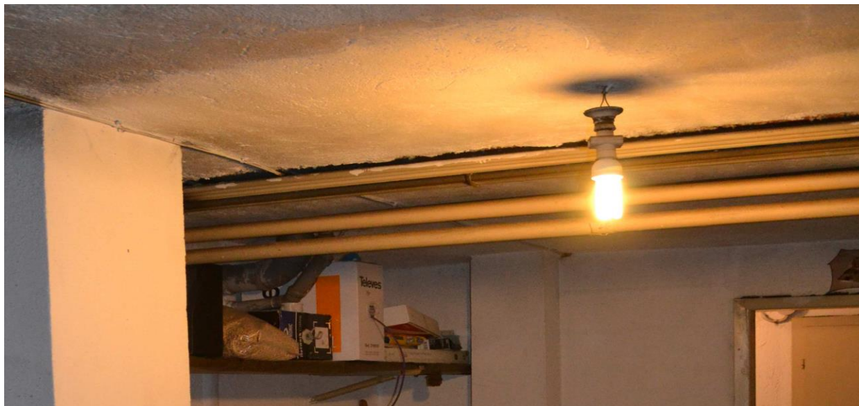
Figure 76 – Dettaglio interno garage;
