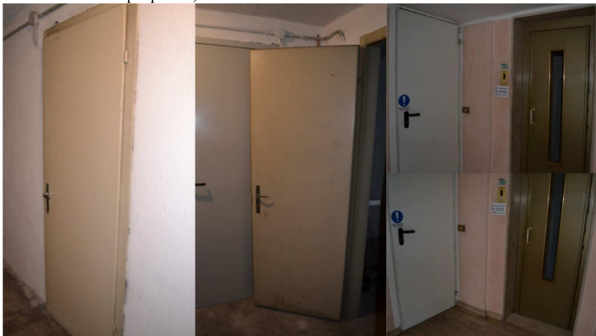
Figura 73-74-Corridoio condominiale che conduce al garage sub.9.
