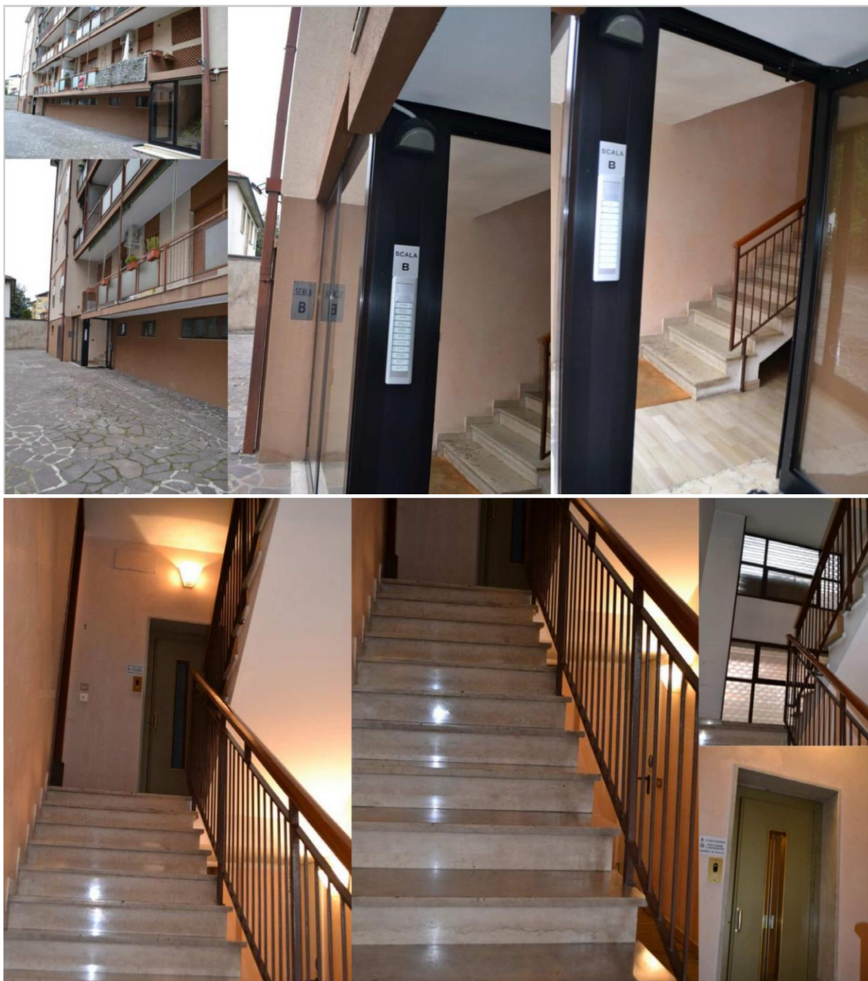
Figure 15-16-17- 18-Vano scale condominiale e ascensore
