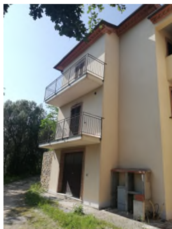
PARTICOLARE FRONTE PRINCIPALE
