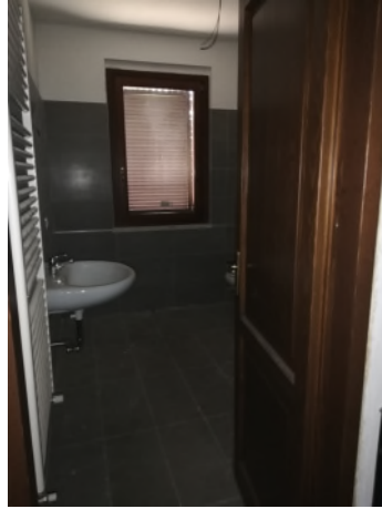
BAGNO PIANO PRIMO
