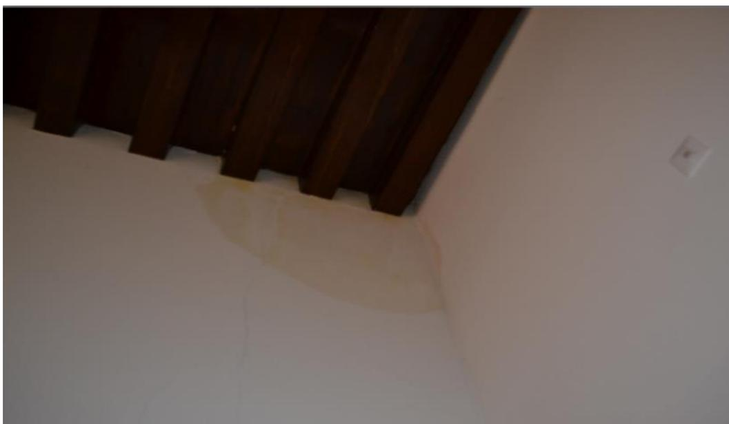
**Fig.57-Macchia dovuta ad infiltrazione dal piano superiore e crepa-UFFICIO 1;**
