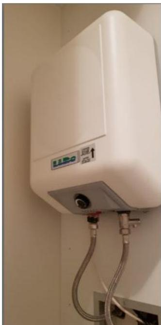
**Fig.54-Boiler per produzione acqua calda;**
