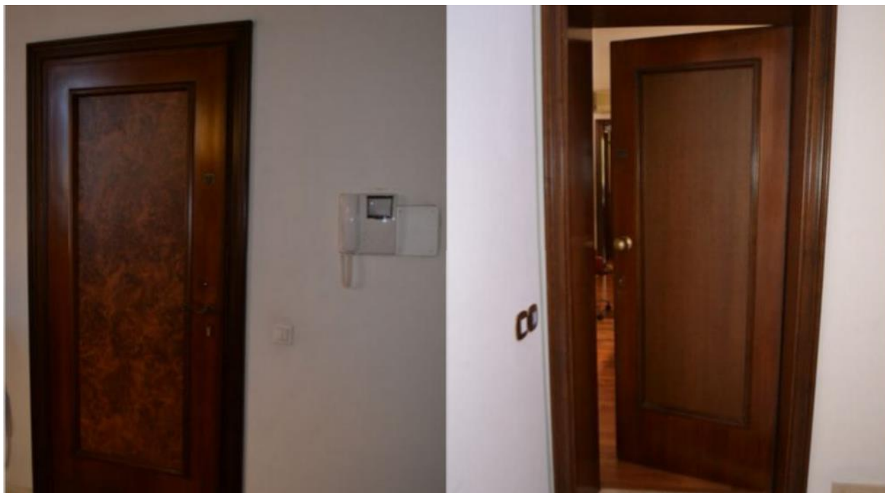
Fig.21-22-INGRESSO PORTONCINO IN LEGNO CON SERRATURA SEMPICE; FINITURA NOCE SCURO SPECCHIATURA CENTRALE, PANNELLO IN RADICA VERSO L'INTERNO DELL'UFFICIO;
