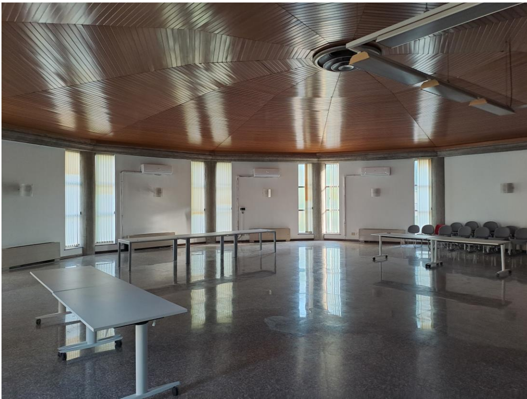
FOTO N°14. - visione interna - PIANO PRIMO
