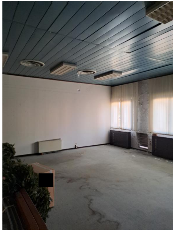
FOTO N°11. - visione interna - PIANO PRIMO
