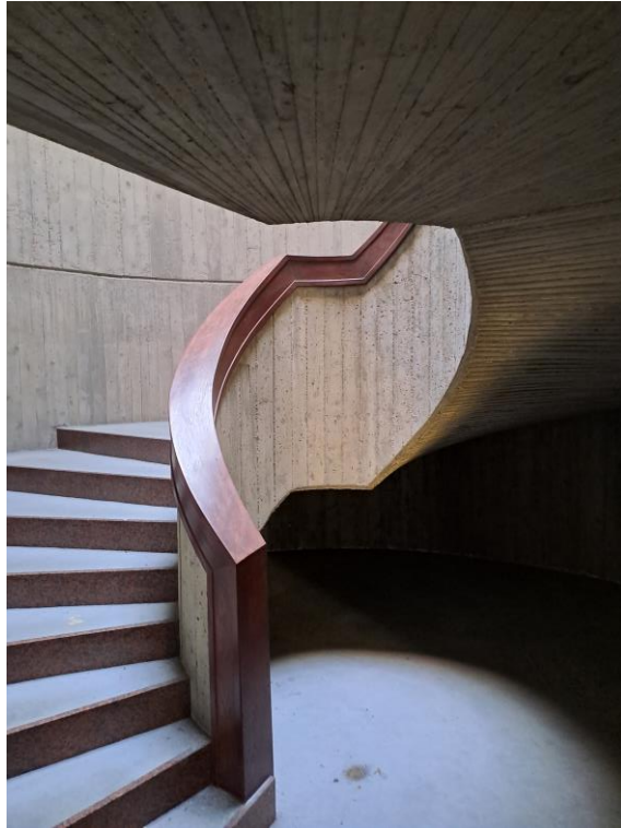
FOTO N°9. - visione interna – PIANO TERRA
