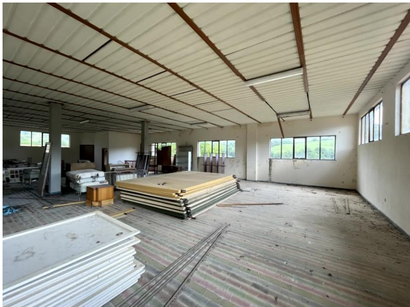
Foto n. 36 - Magazzino al piano primo
