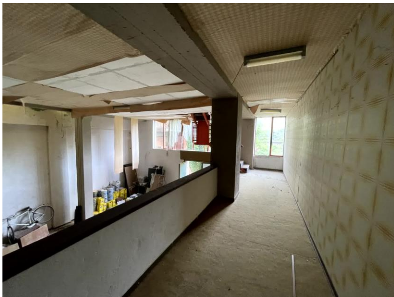
Foto n. 29 - Disimpegno piano ammezzato
