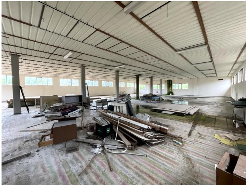
Foto n. 40 - Magazzino al piano primo
