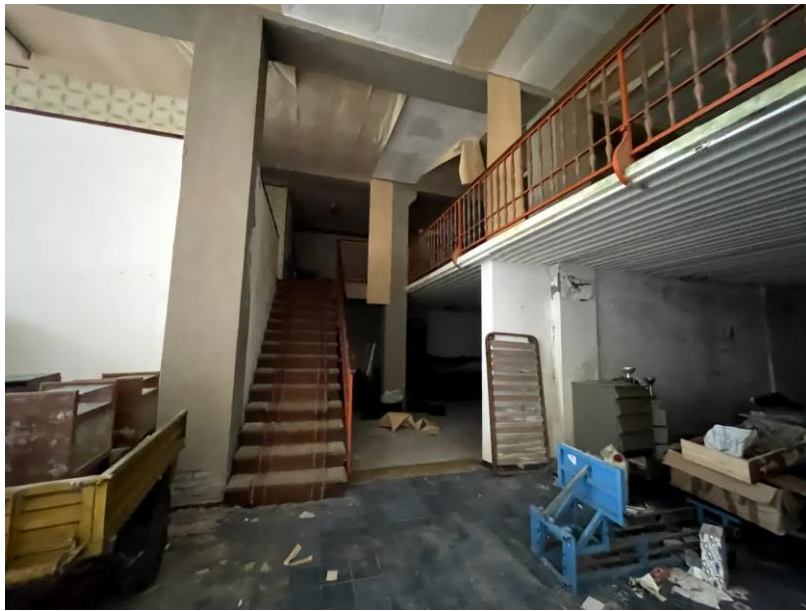
Foto n. 22 - Scala per accesso al piano ammezzato dal piano terra
