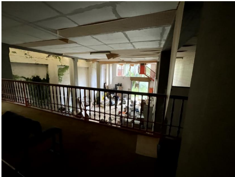
Foto n. 25 - Vista del piano terra dal piano ammezzato
