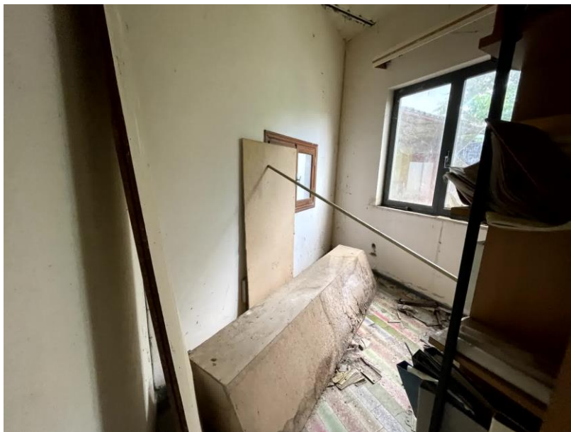
Foto n. 41 - Magazzino al piano primo
