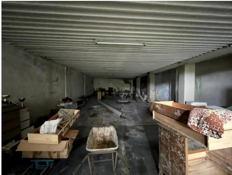
Foto n. 20 - Magazzino fabbricato piano terra
