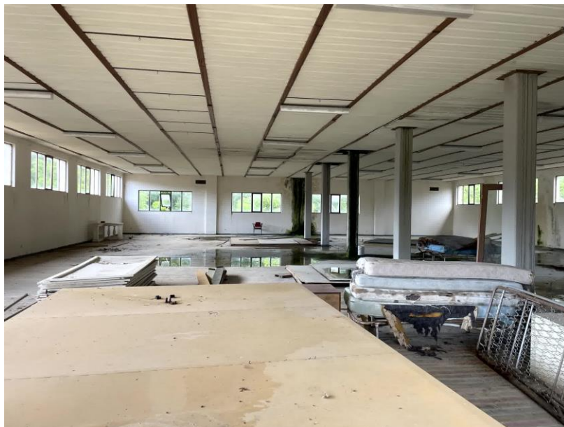
Foto n. 38 - Magazzino al piano primo
