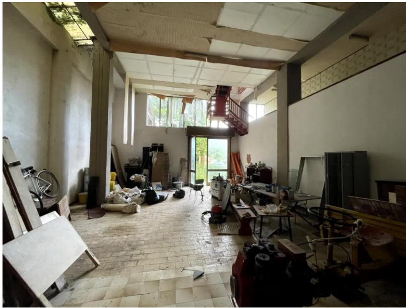
Foto n. 19 - Ingresso magazzino fabbricato piano terra
