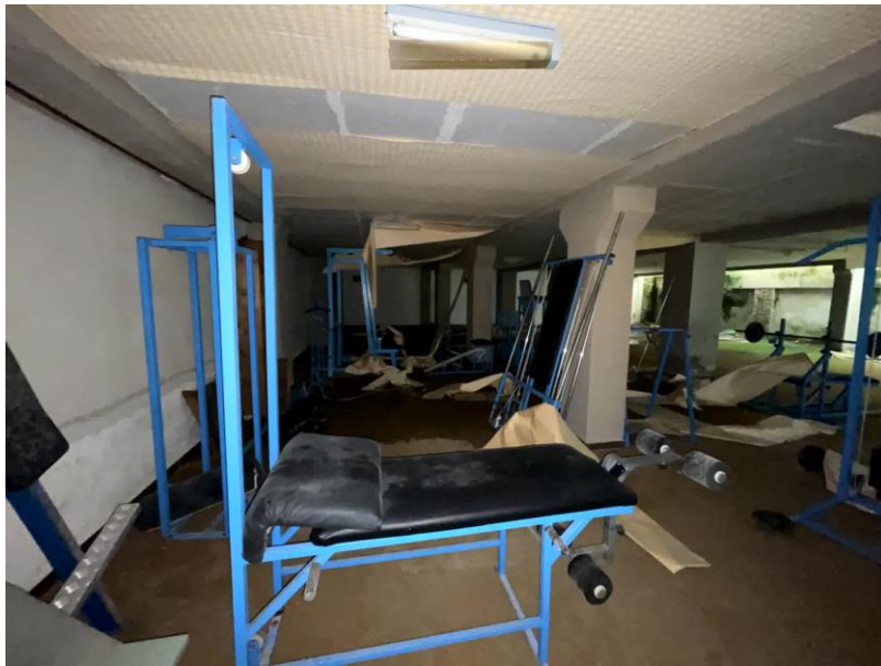
Foto n. 28 - Magazzino piano ammezzato
