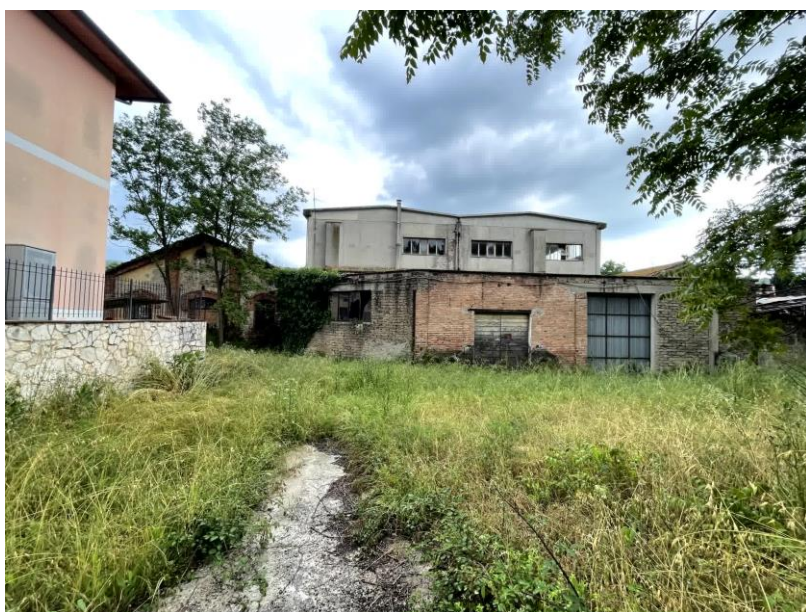
Foto n. 8 - Prospetto retro del fabbricato e corte esclusiva
