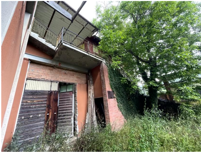
Foto n. 13 - Ingresso alla porzione di fabbricato diruta e corte esclusiva
