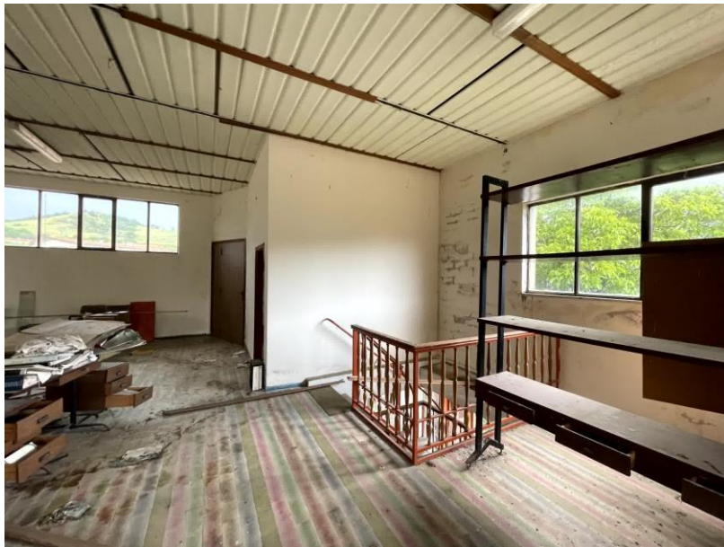
Foto n. 34 - Sbarco del vano scala al piano primo
