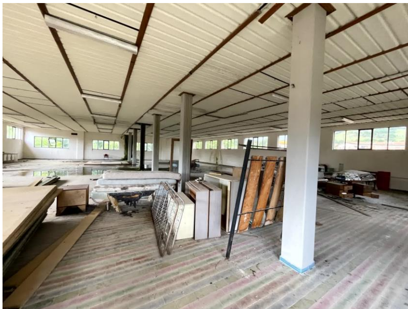
Foto n. 35 - Magazzino al piano primo
