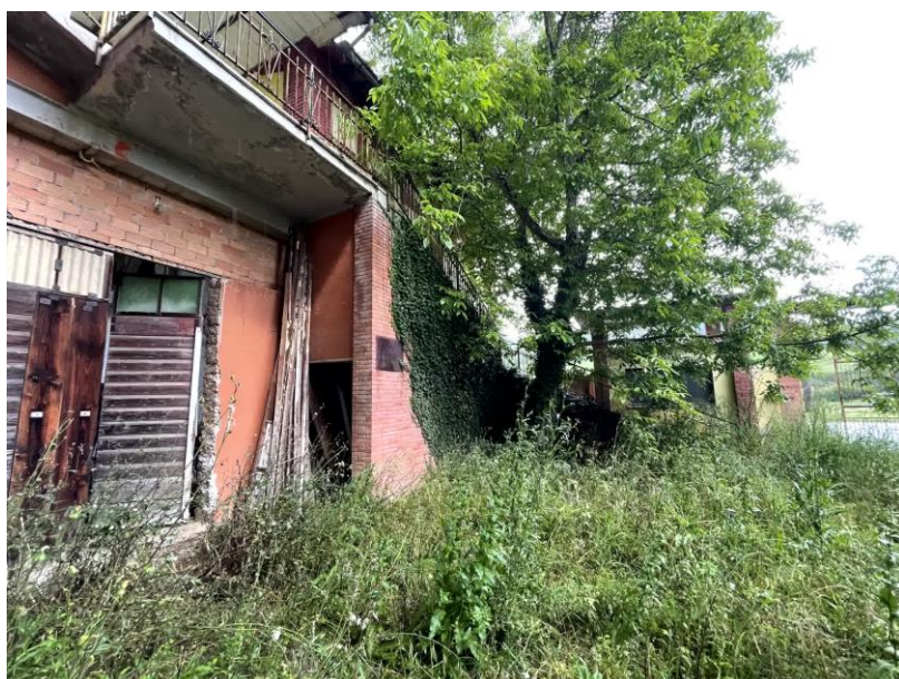
Foto n. 12 -Ingresso alla porzione di fabbricato diruta e corte esclusiva
