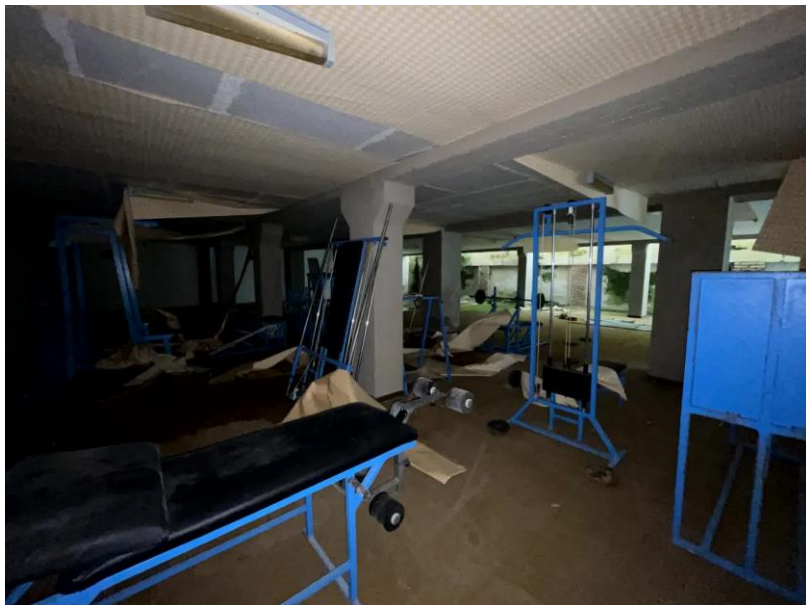
Foto n. 27 - Magazzino piano ammezzato
