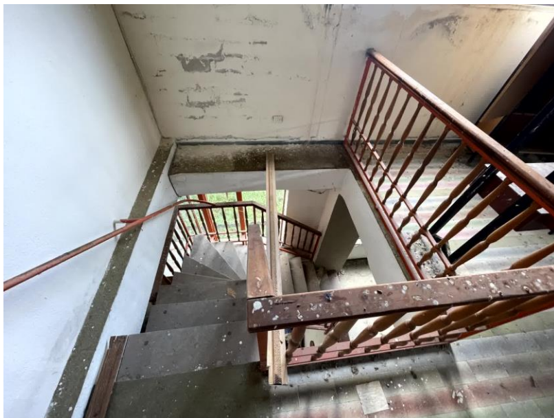
Foto n. 33 - Scala per accesso al piano primo
