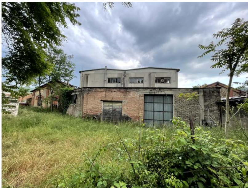
Foto n. 7 - Prospetto retro del fabbricato e corte esclusiva
