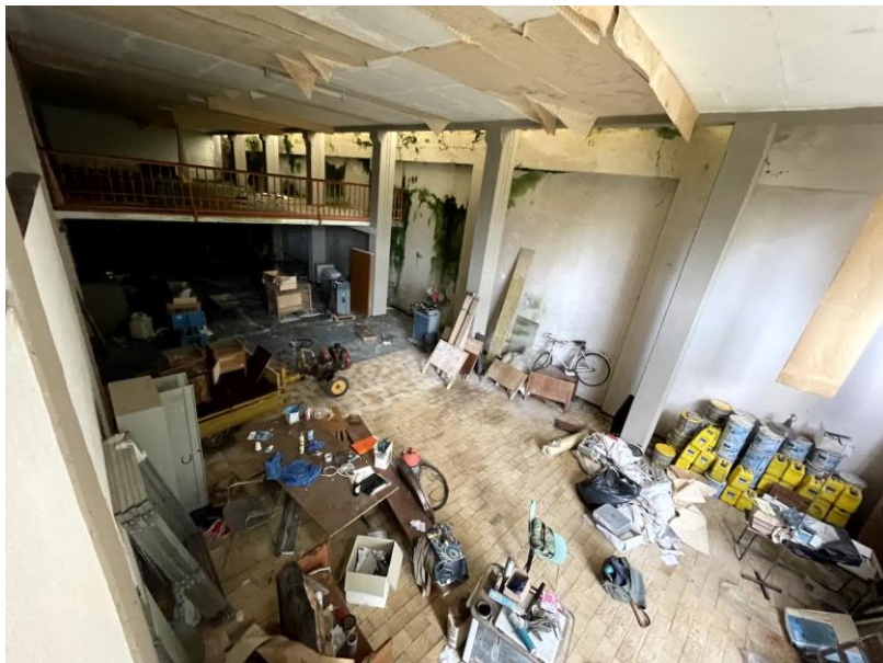
Foto n. 30 - Vista del piano terra dal piano ammezzato
