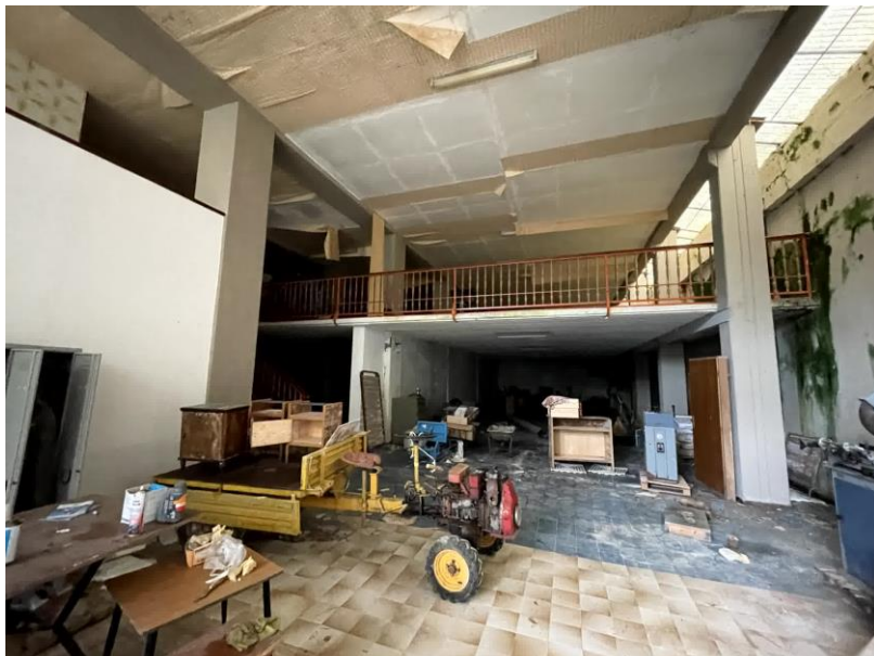
Foto n. 18 - Ingresso magazzino fabbricato piano terra
