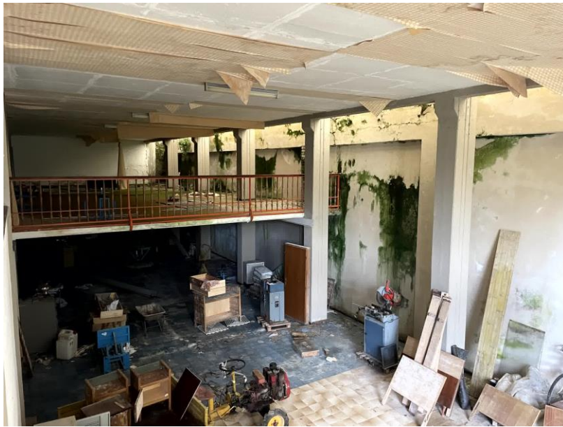
Foto n. 31 - Vista del piano terra dal piano ammezzato
