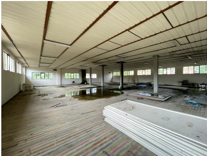
Foto n. 37 - Magazzino al piano primo
