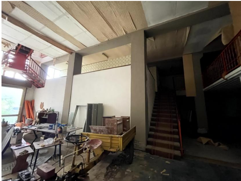
Foto n. 23 - Scala per accesso al piano ammezzato dal piano terra
