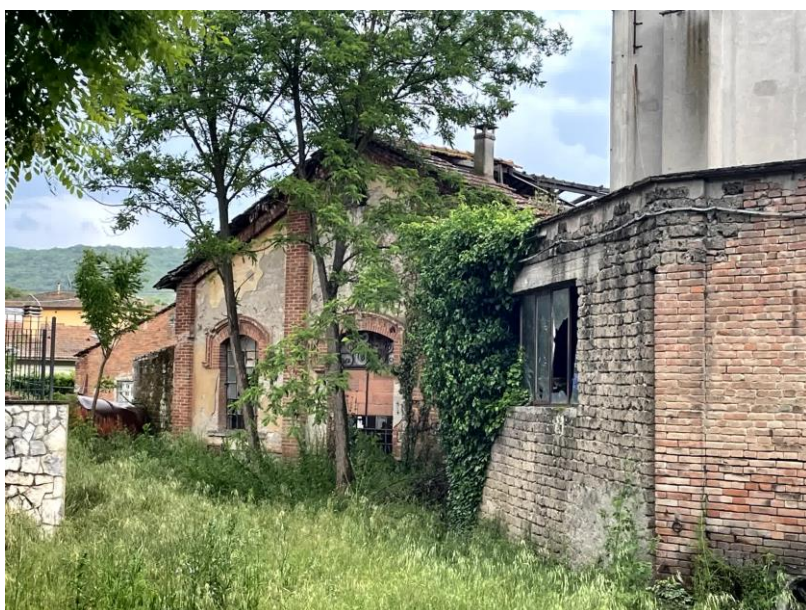
Foto n. 9 - Prospetto retro del fabbricato e corte esclusiva
