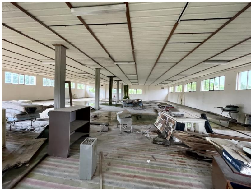
Foto n. 39 - Magazzino al piano primo
