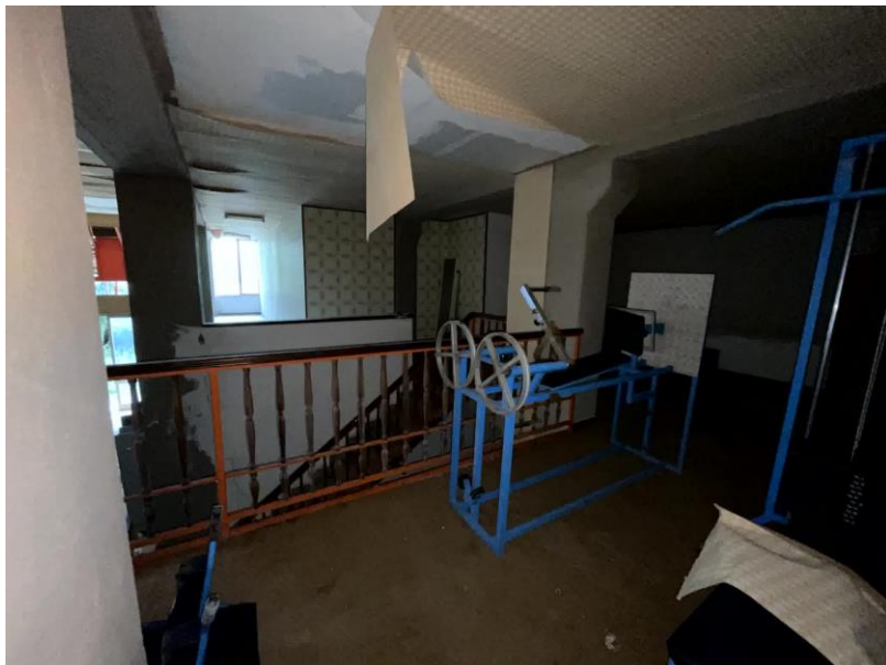
Foto n. 24 - Sbarco del vano scala al piano ammezzato
