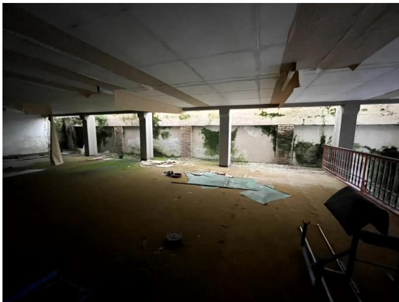
Foto n. 26 - Magazzino piano ammezzato
