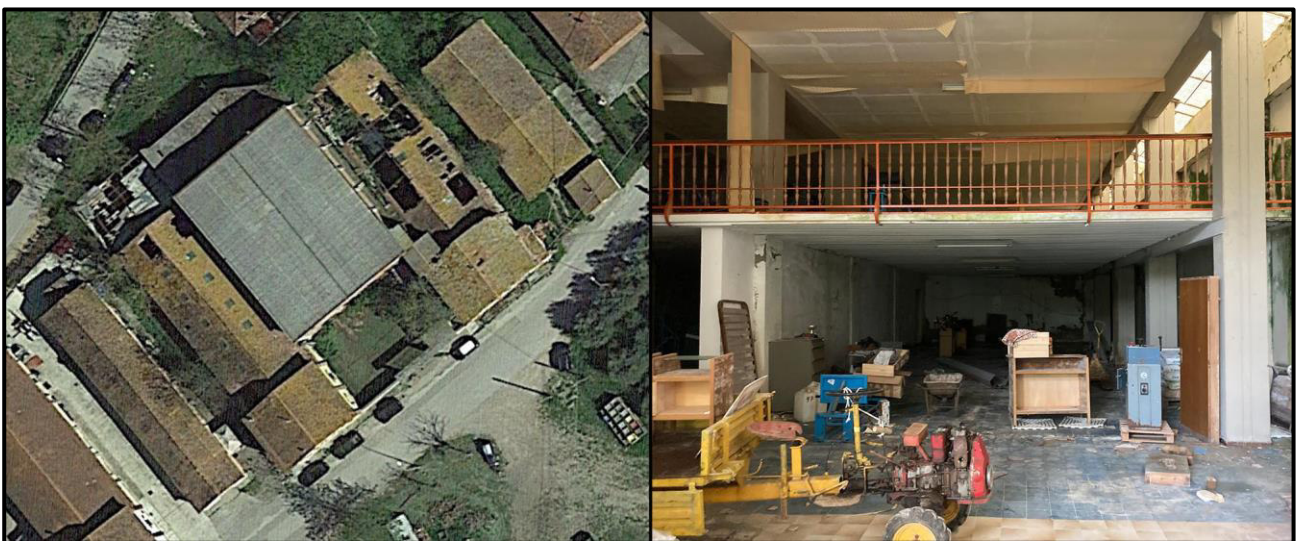
Accesso all'immobile: ortofoto e vista interna dell'immobile
