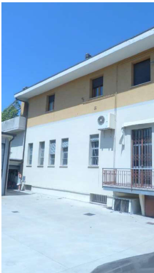
FOTO N. 8 (da cortile interno)
