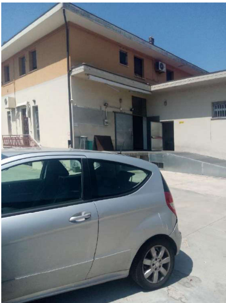
FOTO N. 6 (da cortile interno)
