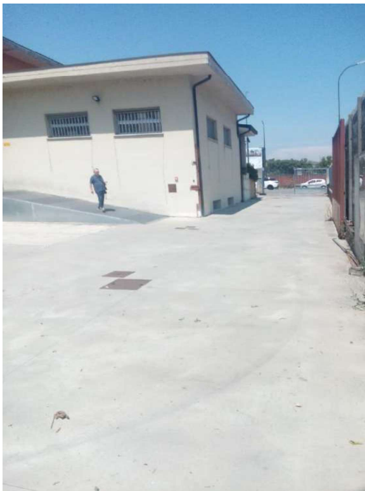
FOTO N. 5 (da cortile interno)
