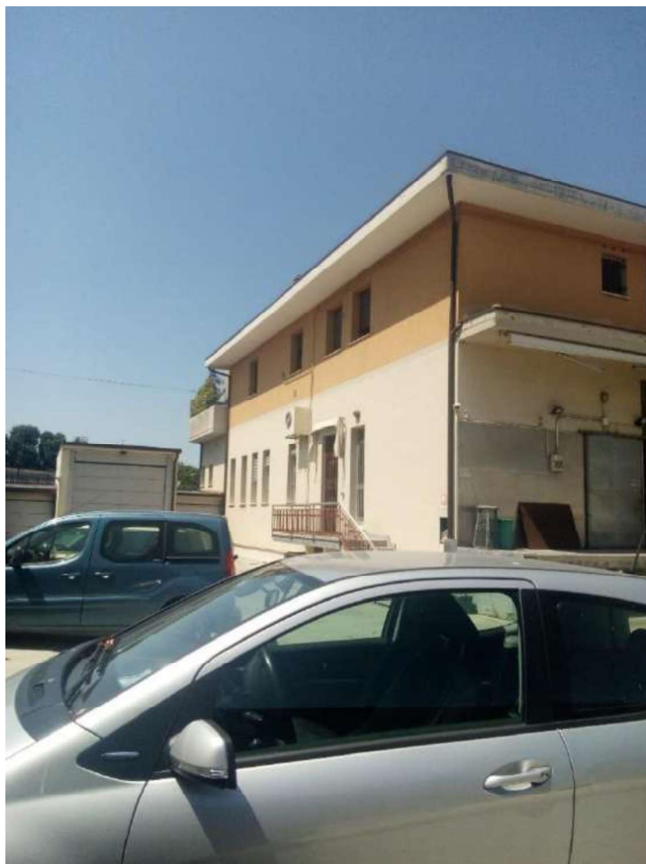
FOTO N. 7 (da cortile interno)
