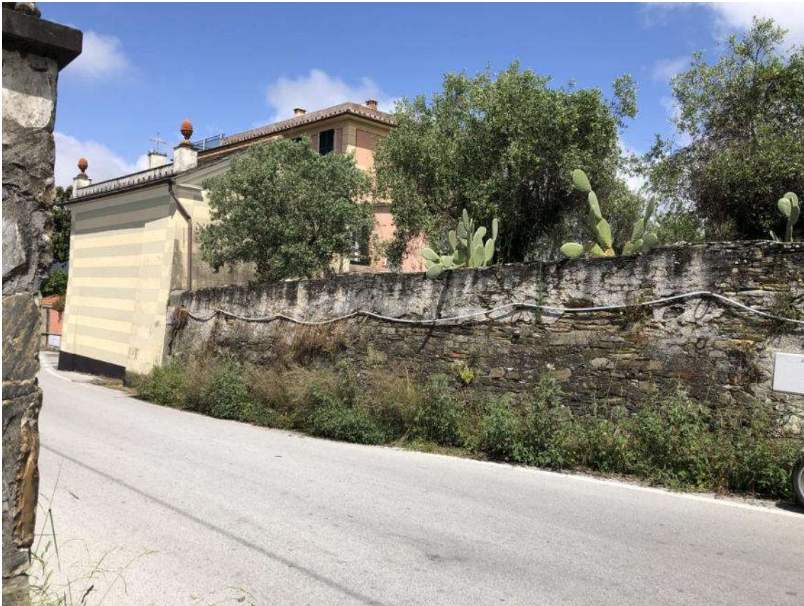
Foto 1 PORZIONE CONFINANTE CON STRADA
