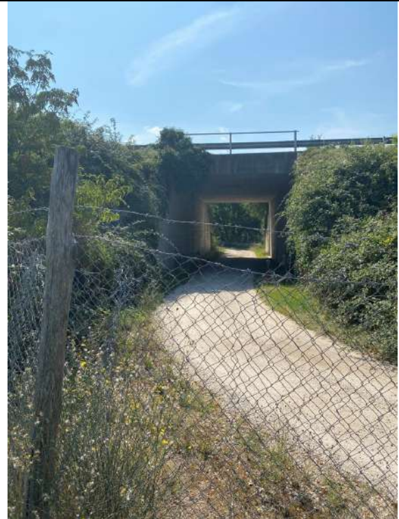
Strada interpoderale – Cavalcavia SS675
