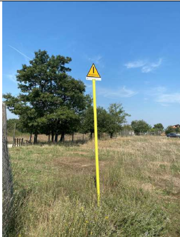
Metanodotto vista da Est verso Ovest lato strada interpoderale
