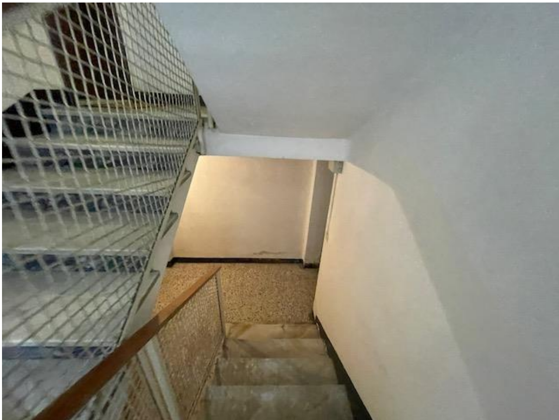
Scala di Accesso alle Cantine
