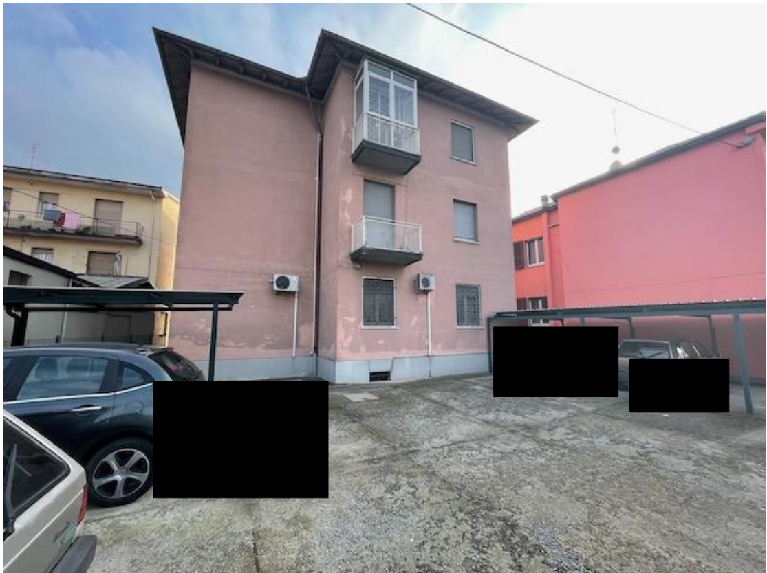
Vista Esterna Corpo di Fabbrica – vista dal retro
