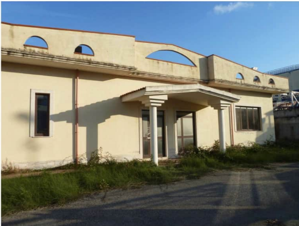
Prospetto principale del fabbricato industriale con cancello carraio
