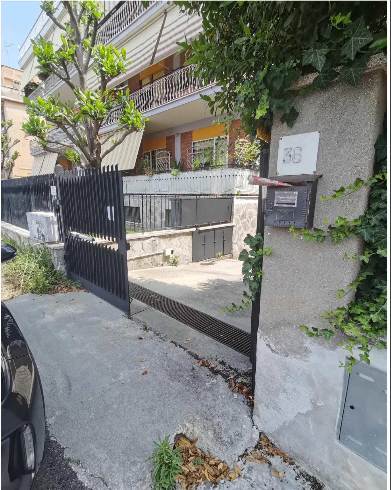
Ingresso locale dal passo carrabile di Via G. Bellucci, 36
