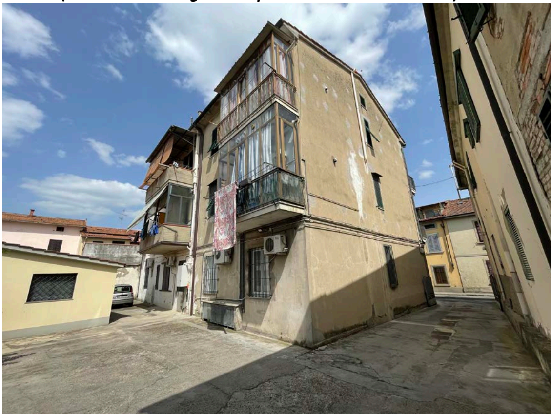
FOTO 2 (vista esterna tergale da spazio di manovra comune)
