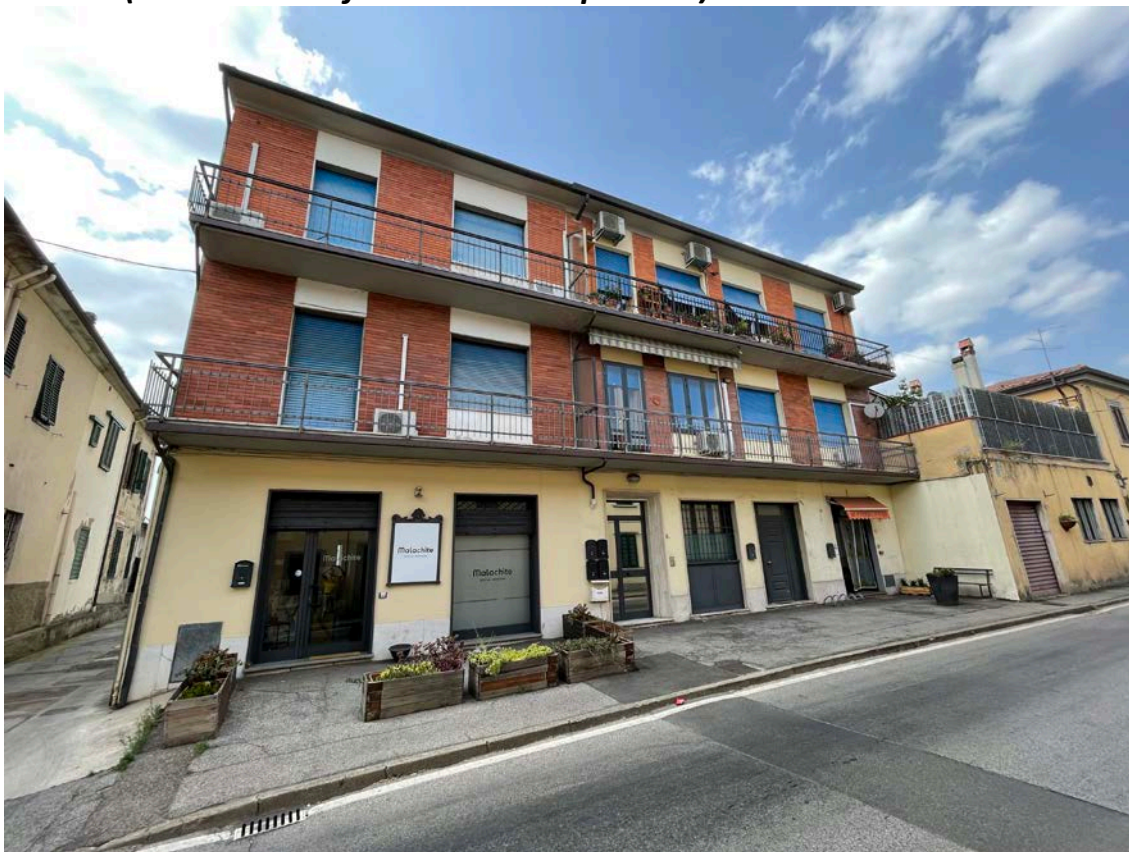
FOTO 1 (vista esterna frontale da via per Iolo)
