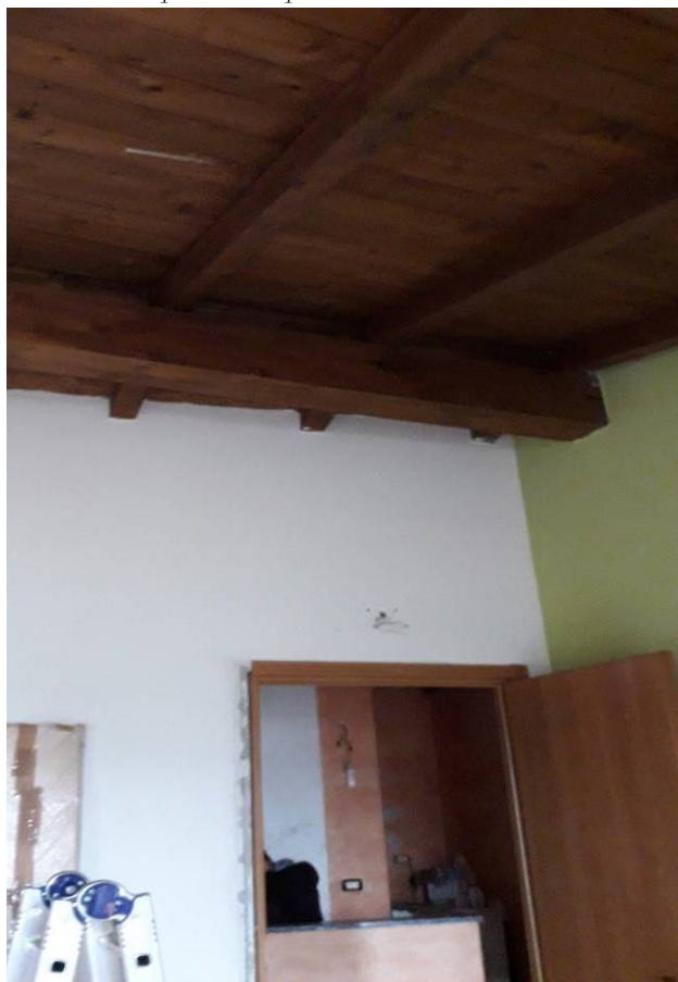
Particolare soffitto a vista
