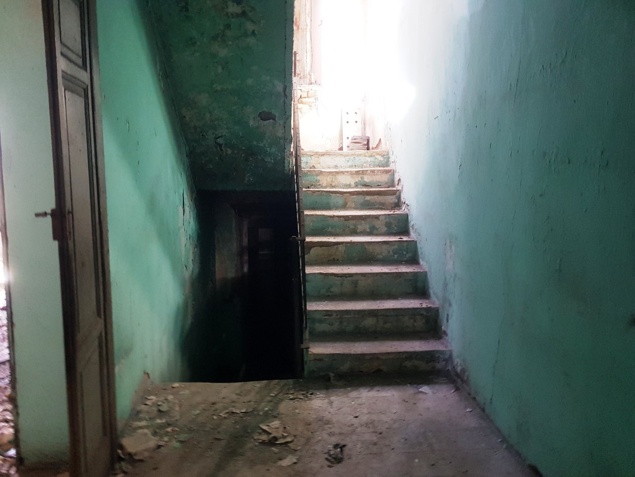
FOTO 59 interno Foglio 40 p.lla 49 Sub.5
