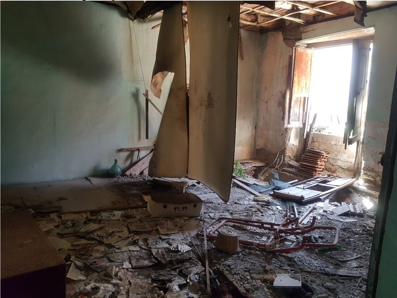
FOTO 61 interno Foglio 40 p.lla 49 Sub.5
