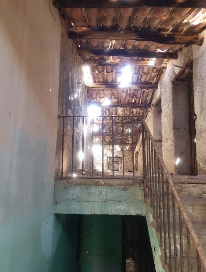
FOTO 64 interno Foglio 40 p.lla 49 Sub.5
