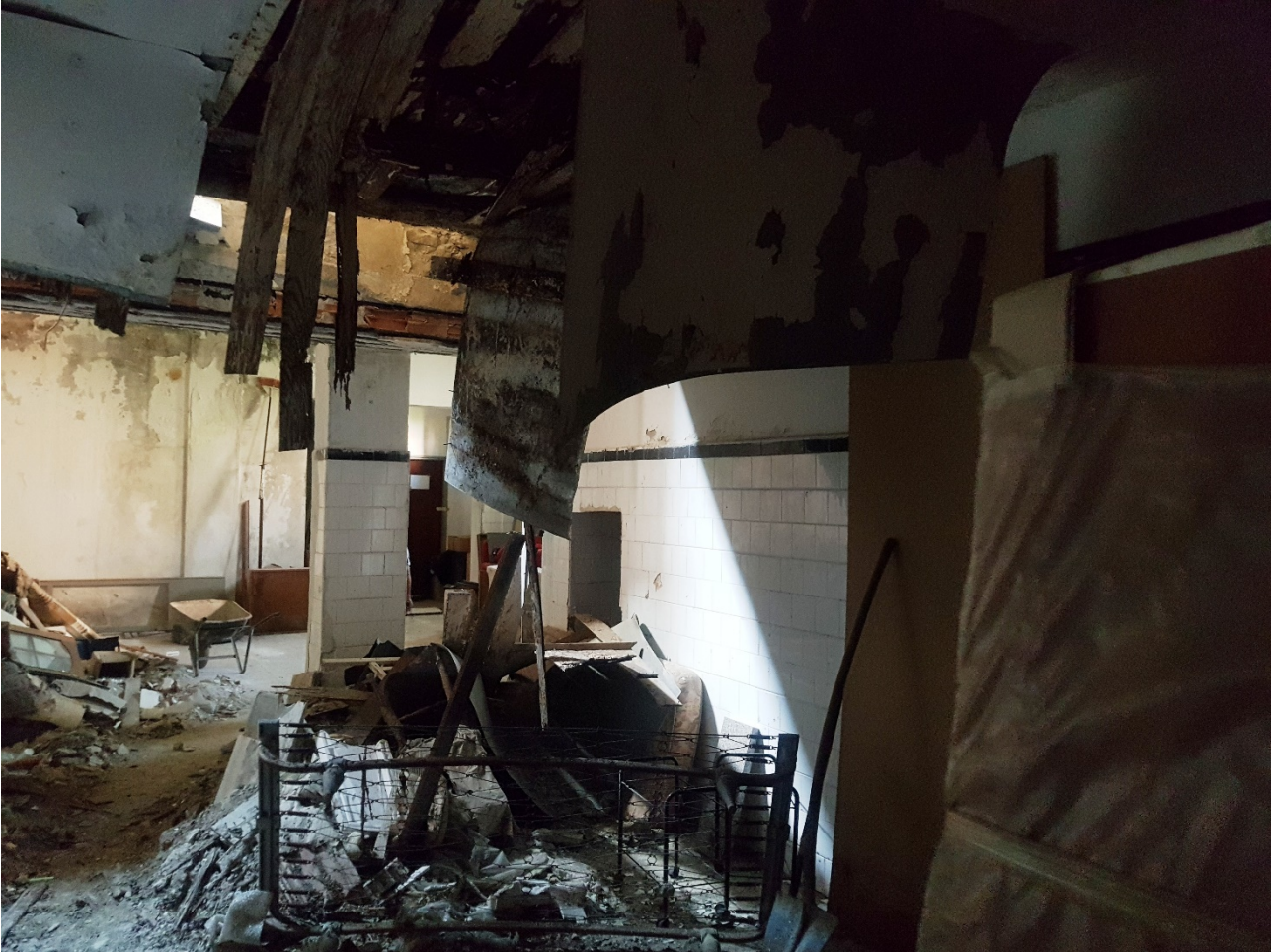
FOTO 38 interno Foglio 40 p.la 728 Sub.1 e sub.2 - Foglio 40 p.la 49 Sub.4
