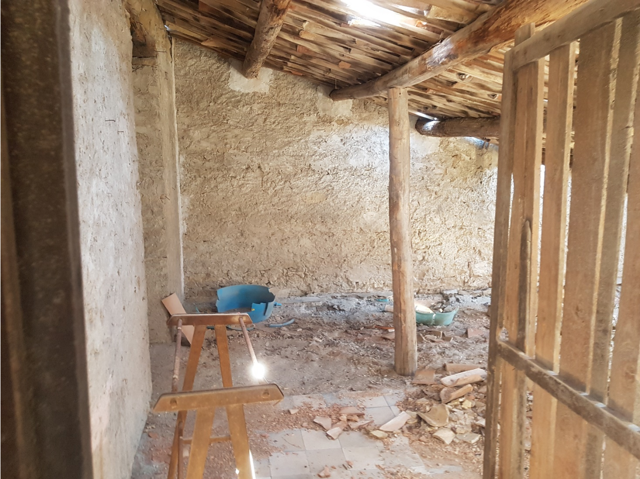
FOTO 68 interno Foglio 40 p.la 49 Sub.5
