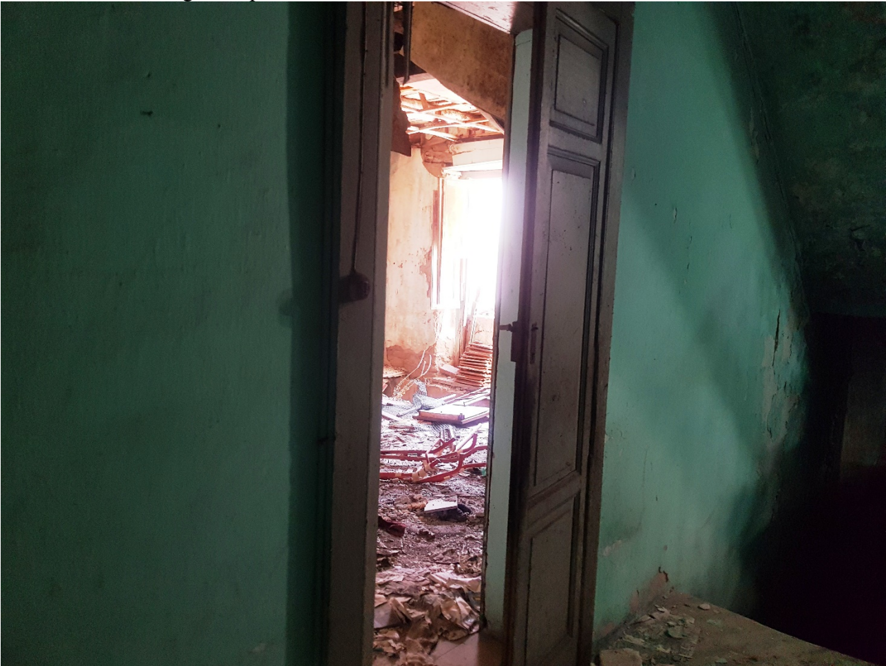
FOTO 60 interno Foglio 40 p.lla 49 Sub.5
