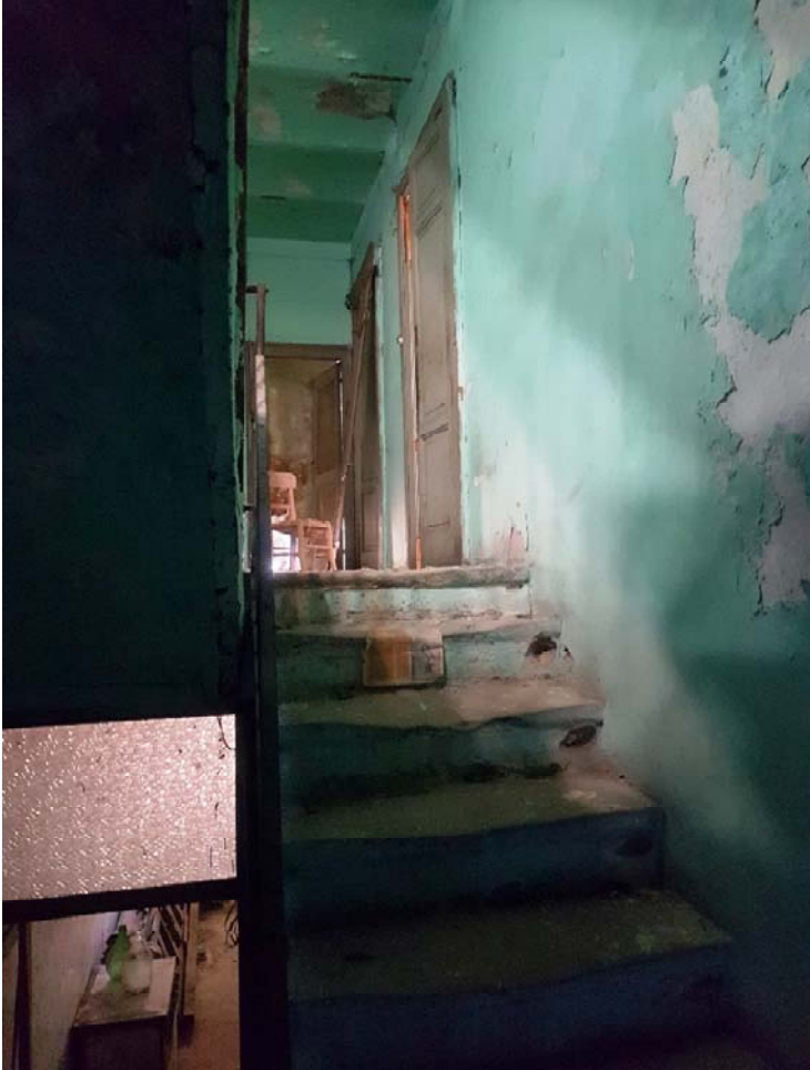
FOTO 53 interno Foglio 40 p.la 49 Sub.5
