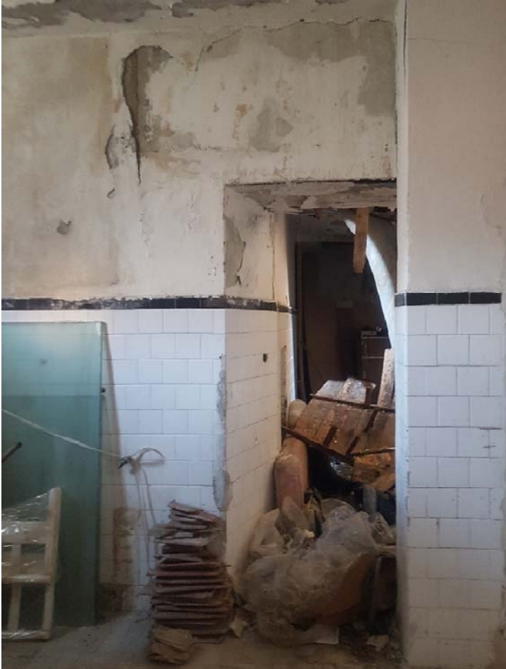
FOTO 39 interno Foglio 40 p.la 728 Sub.1 e sub.2 - Foglio 40 p.la 49 Sub.4
