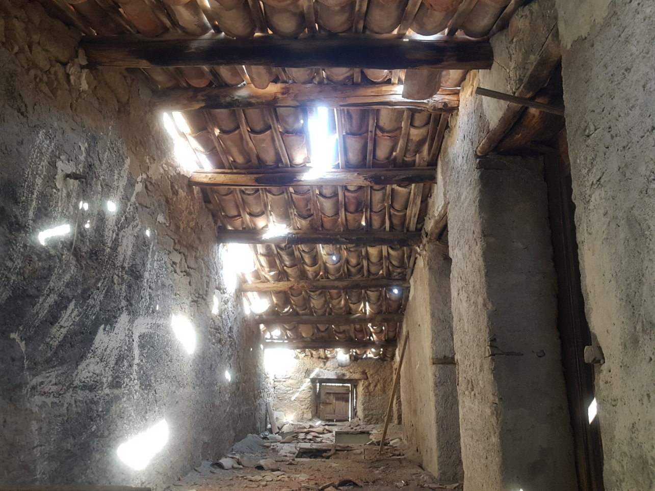
FOTO 65 interno Foglio 40 p.lla 49 Sub.5
