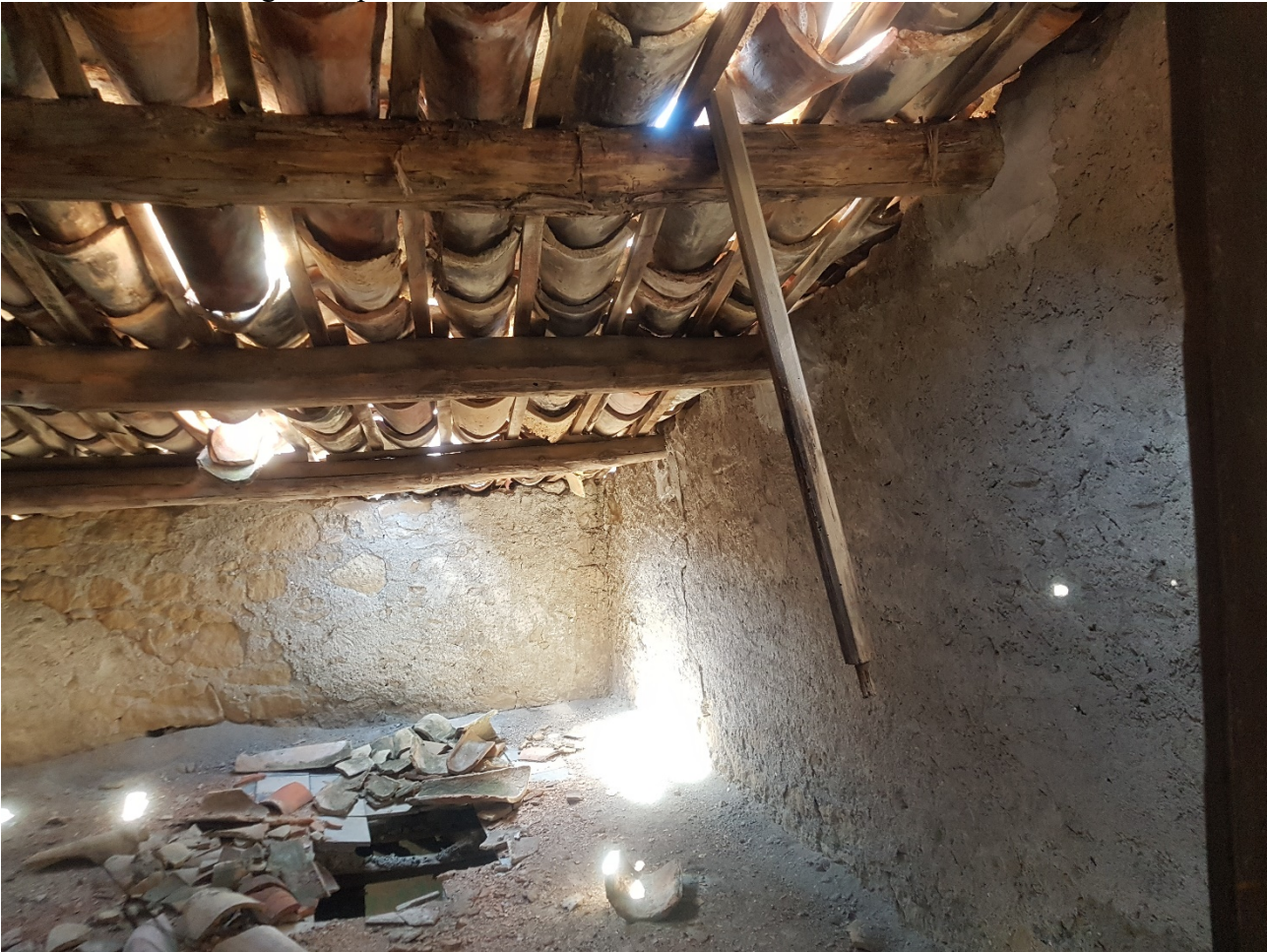
FOTO 70 interno Foglio 40 p.lla 49 Sub.5
