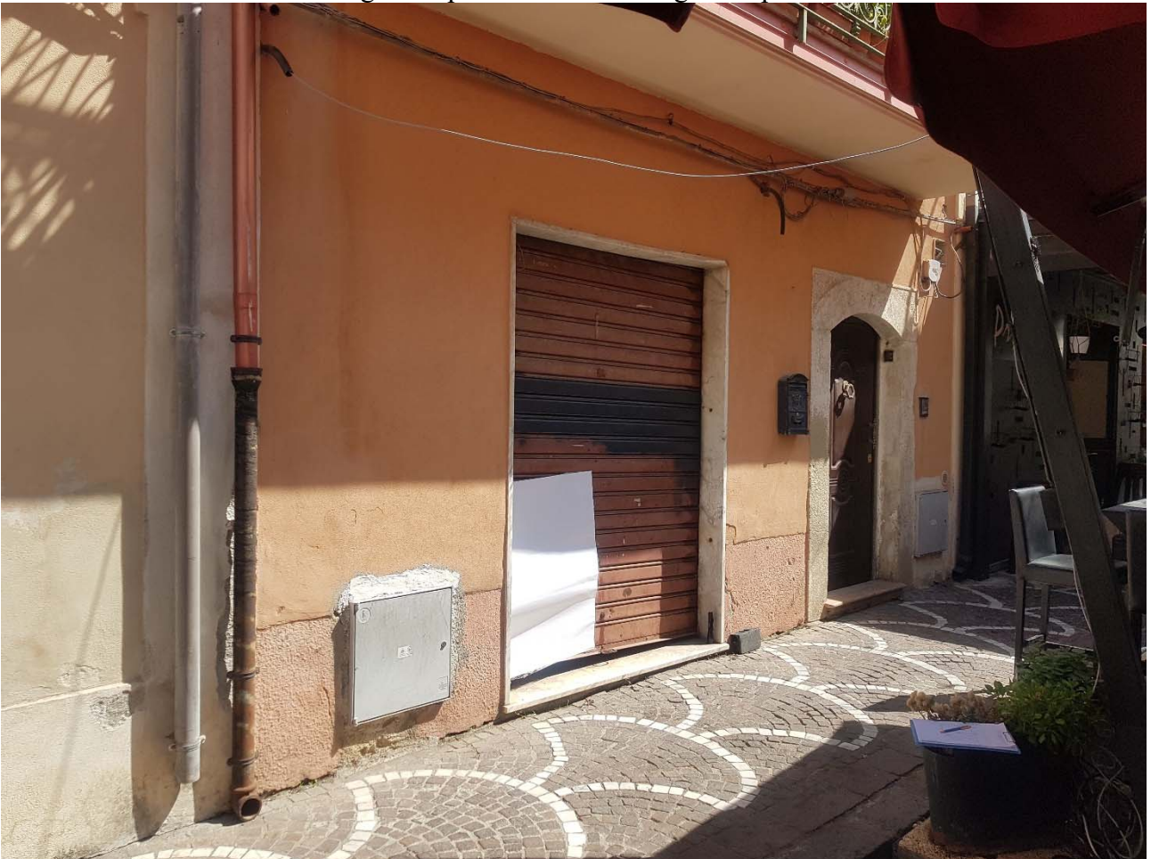
FOTO 23 esterno fabbricato Foglio 40 p.lla 727 Sub.1 - Foglio 40 p.lla 46 Sub.1
