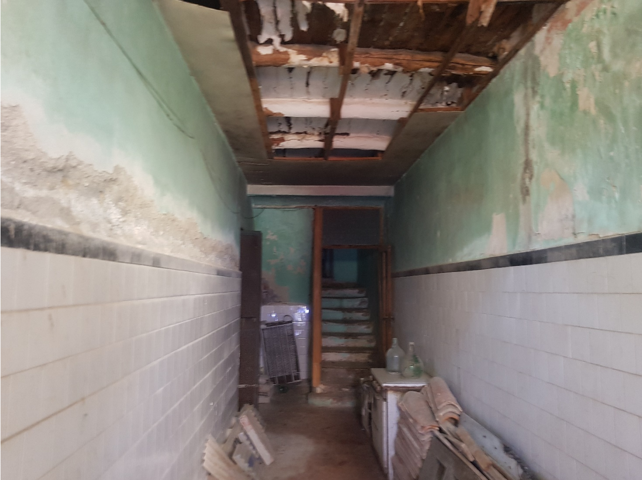
FOTO 51 interno Foglio 40 p.la 49 Sub.5
