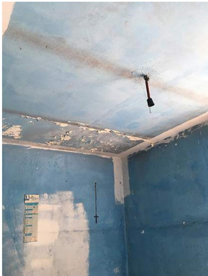
L'intonaco o altri tipi di paramento presenti nel fabbricato risultano essere gravemente deteriorati ed evidenziano lesioni diffuse, la copertura consente l'infiltrazione di acque piovane, gli infissi evidenziano difetti strutturali che ne impediscono il funzionamento ed una normale tenuta agli agenti atmosferici, la pavimentazione, in alcuni ambienti risulta mancante e/o ammalorata
