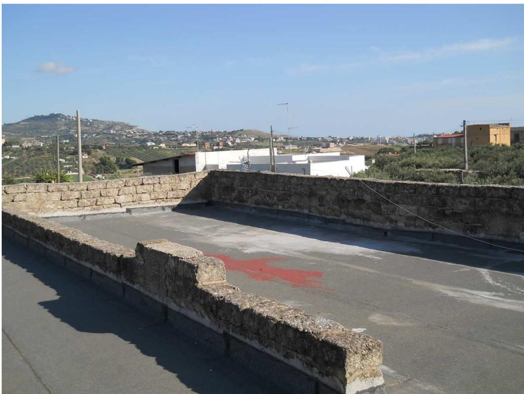
**Foto 3 – CORPO A – Porzione orientata verso Nord – Particolare del tetto a terrazza praticabile in latero-cemento**
