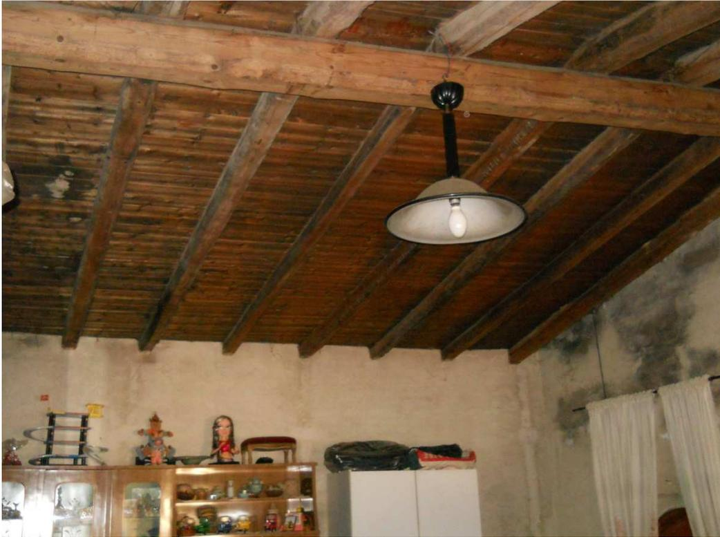
**Foto 5 – CORPO A – Porzione orientate verso Nord – Particolare del tetto a due falde inclinate caratterizzato da travi in legno ed ondulina metallica**
