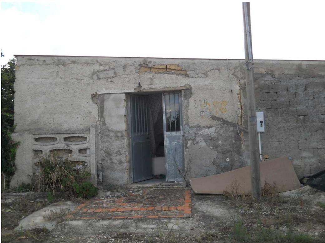
**Foto 6 – CORPO A – Porzione orientata verso Nord in muratura e tetto ad una falda inclinata in legno e pannelli coibentati tipo “Isopan**
