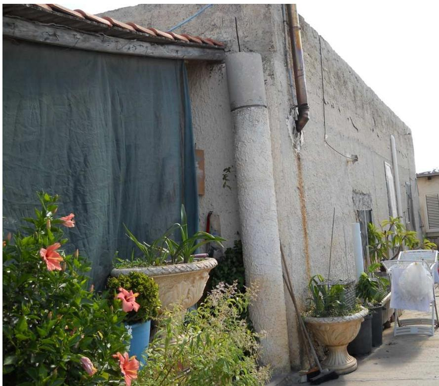
**Foto 2 – CORPO A – Porzione orientata verso Sud in c.a., tamponatura in conci di tufo e tetto a terrazza praticabile in latero-cemento**
