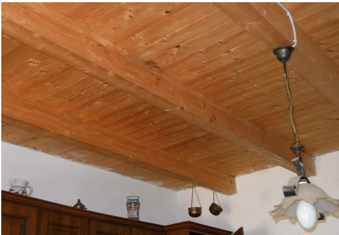
**Foto 25 – CORPO B - Particolare interno del tetto ad una falda inclinata in legno e pannelli coibentati tipo “Isopan”**
