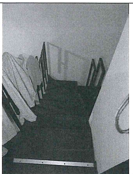
Foto n°20: Scale al P.1° verso ballatoio
