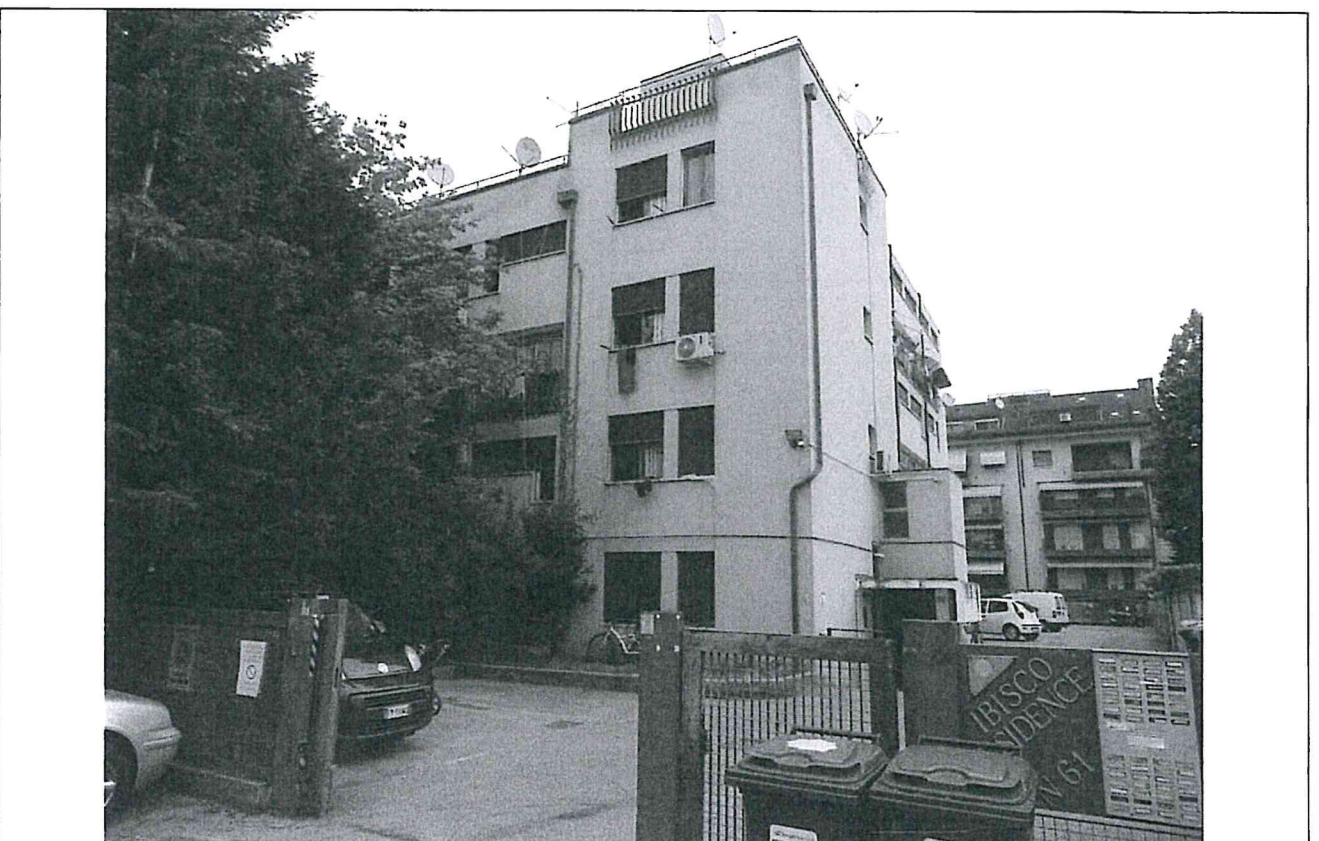
Foto n°4: Vista panoramica fronte sud
