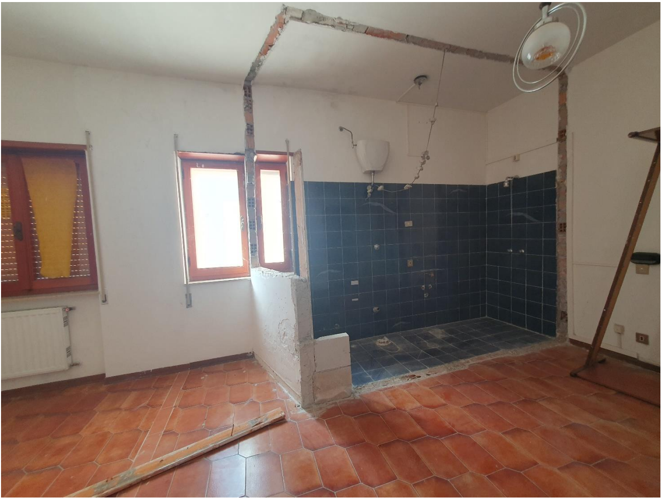
Lavori di ripristino servizio igienico all'interno di una camera
