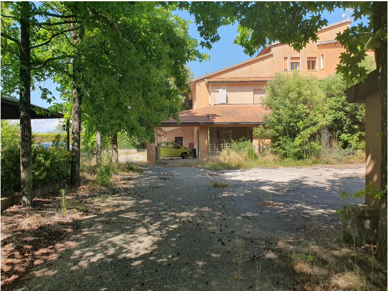
Vista laterale portico e ingresso albergo
