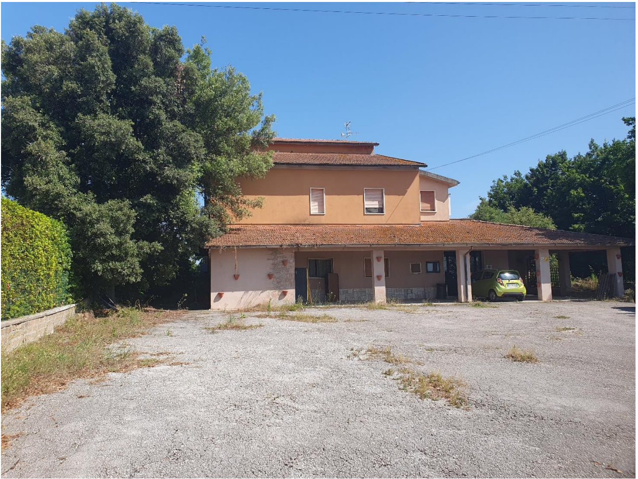
Vista facciata lato portico e parcheggio
