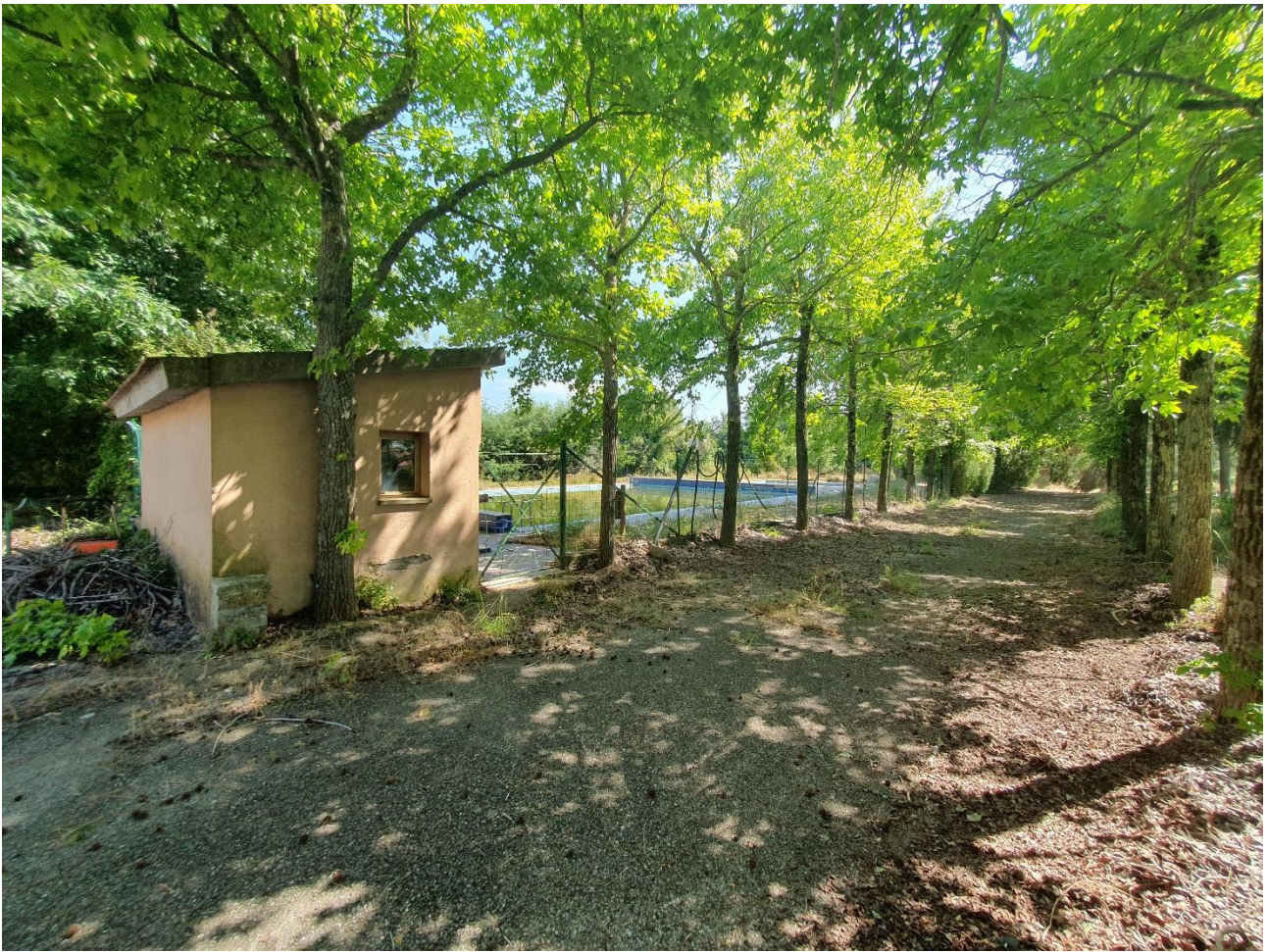
Piscine e locale spogliatoio
