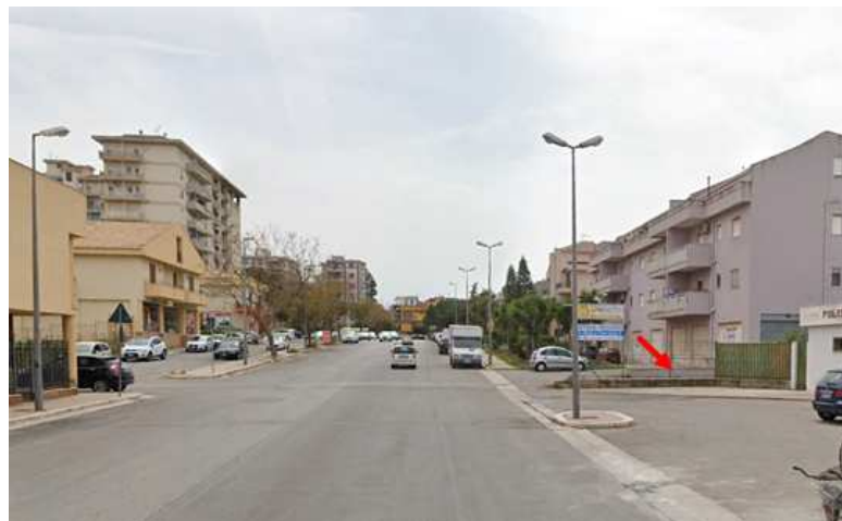
Foto 1 – Via Polo Borsellino – Indicazione ubicazione rampa d'accesso
