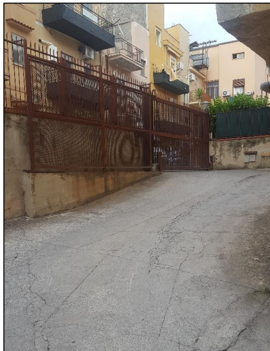
Foto 2 – Cancelli di ingresso al locale cantina da via Monte Billiemi n. 2
