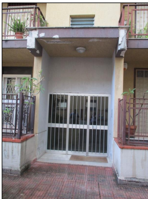
Foto 4 – Accesso alla scala B - Palazzina C
