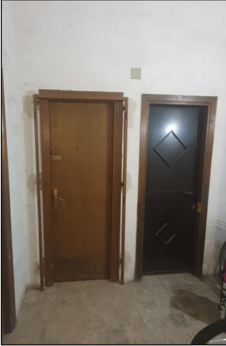
Foto 20 – a sinistra locale cantina staggito
