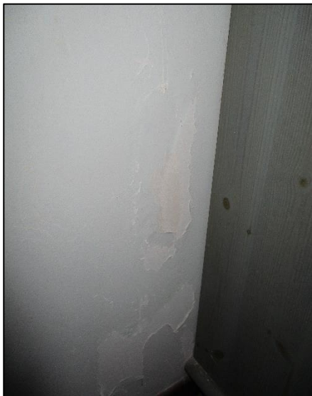
Foto 18 – Scrostamenti della tinteggiatura
