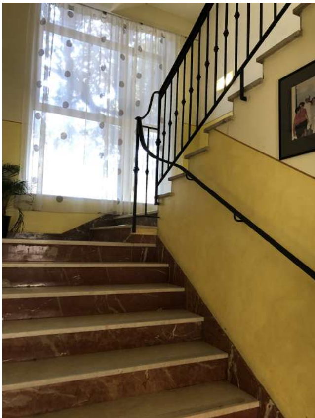
Foto 23- Vano scala al 1° piano
