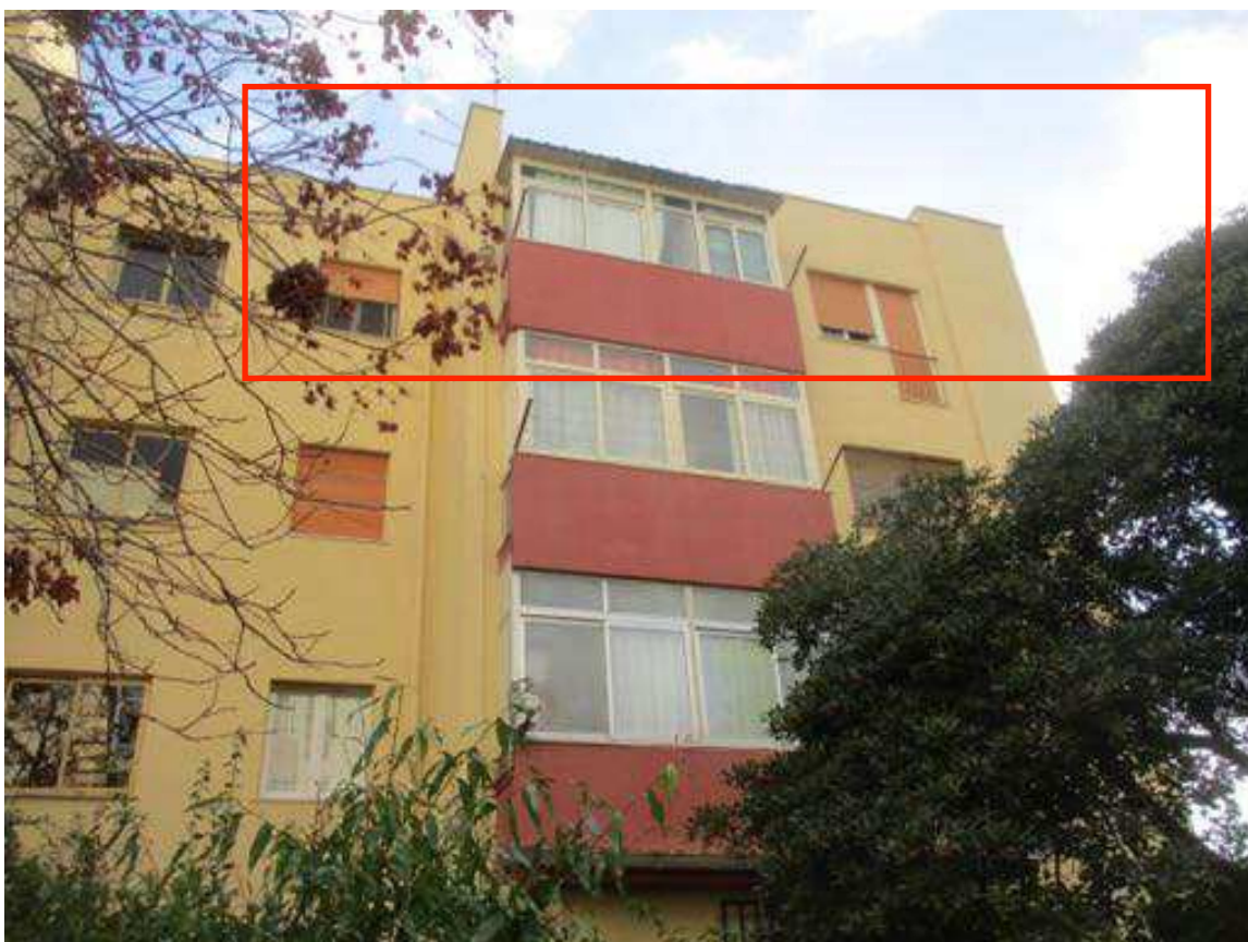
Foto 4- vista dell'appartamento pignorato a piano terzo sx
