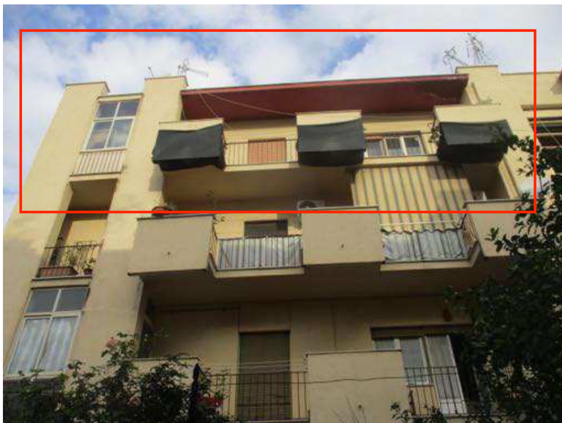
Foto 2- vista dell'appartamento pignorato a piano terzo sx
