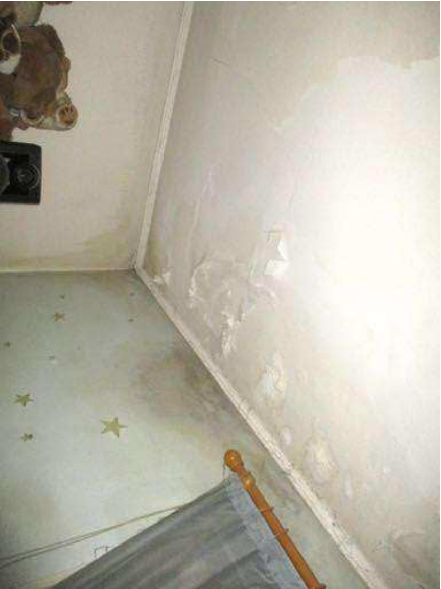
Foto 24 - particolare del soffitto di una camera dell'appartamento
