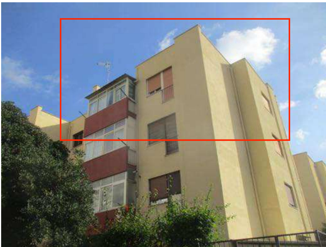
Foto 3- vista dell'appartamento pignorato a piano terzo sx
