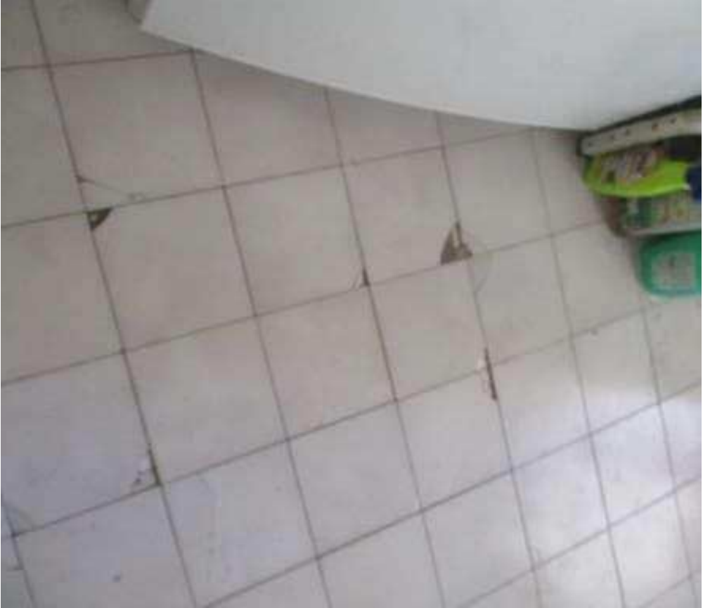
Foto 16- particolare del pavimento della cucina
