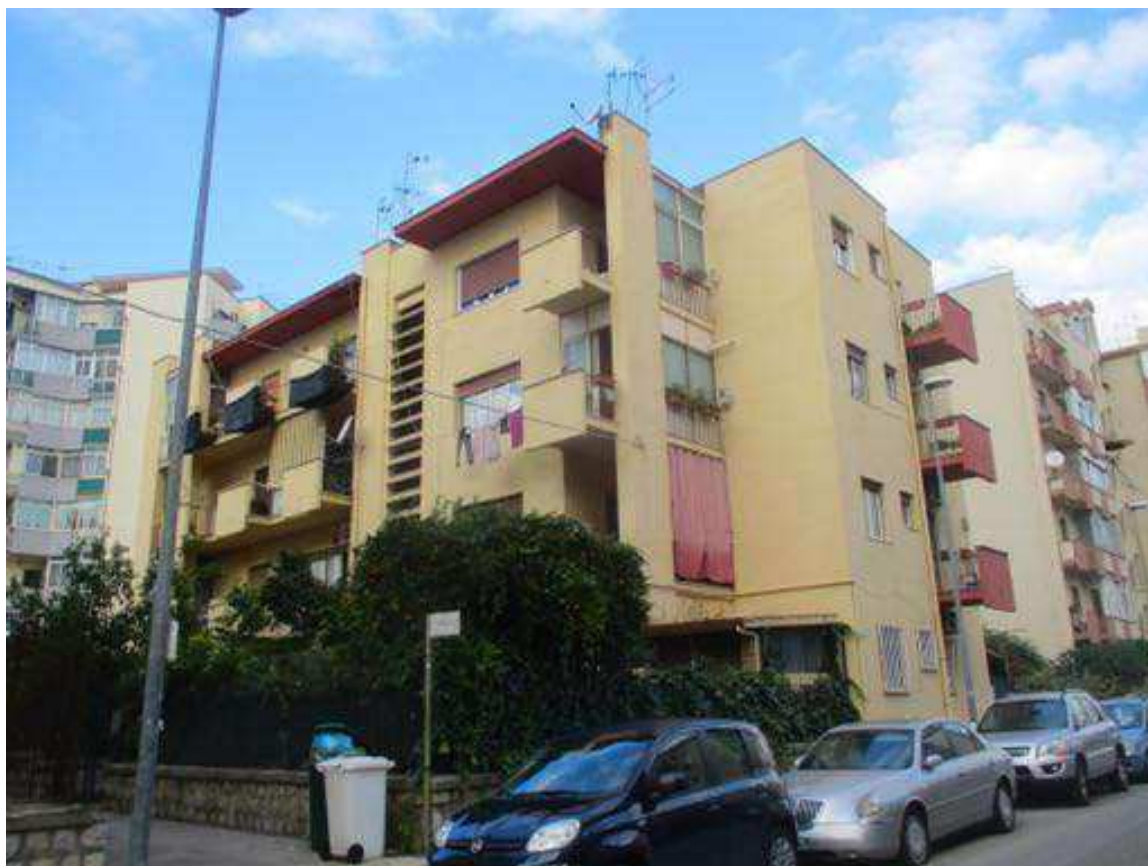
Foto 1- vista del fabbricato sito in Palermo via E.Carnevale 2
