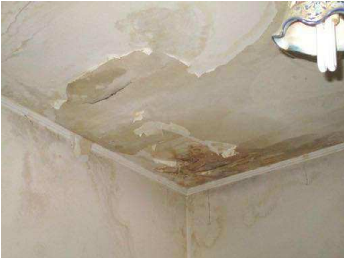
Foto 26- particolare del soffitto di una camera dell'appartamento
