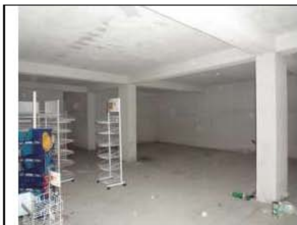
Foto 5 Vista interna locale
