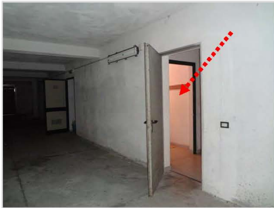
Foto 9 Particolare Accessi Lotto 3
