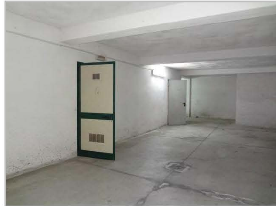
Foto 10 Particolare Accessi Lotto 3
