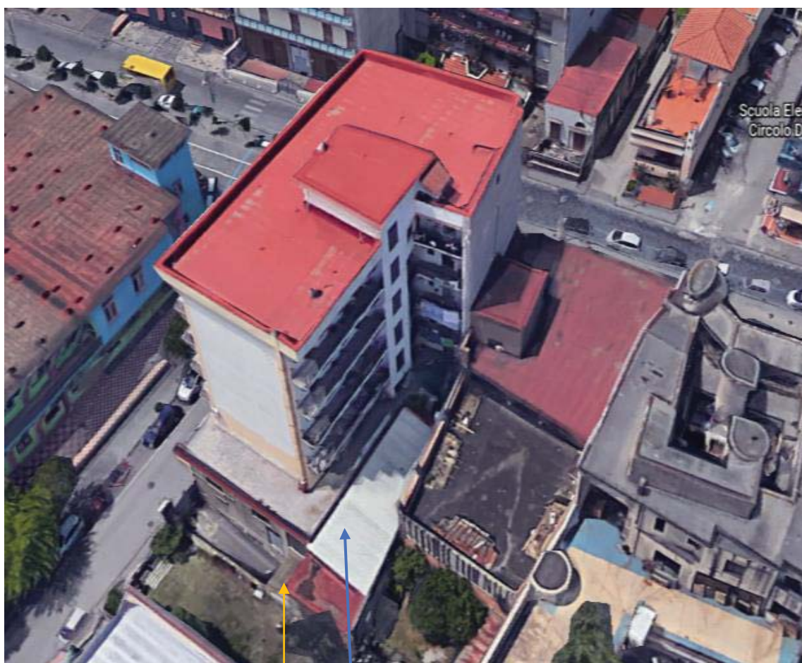
Copertura corte interna demolita in seguito all'ordinanza Comunale
