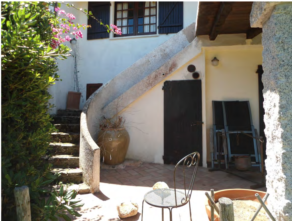
Foto n.3 – Scala di accesso al piano Primo d'ingresso
