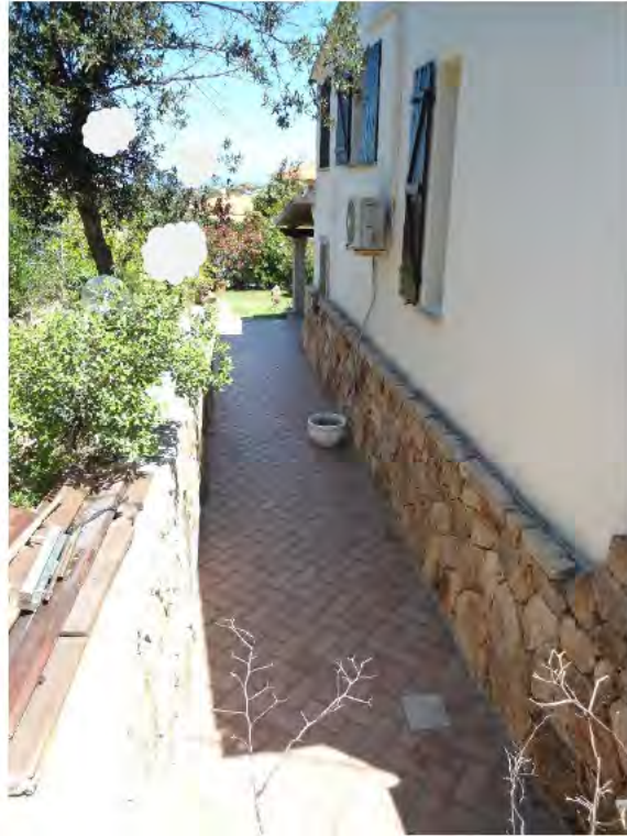
Foto n.9 – Scorcio del fronte S-E
