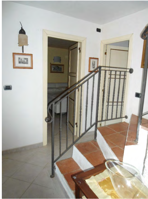
Foto n.19 – Ingressi alle camere al piano Terra
