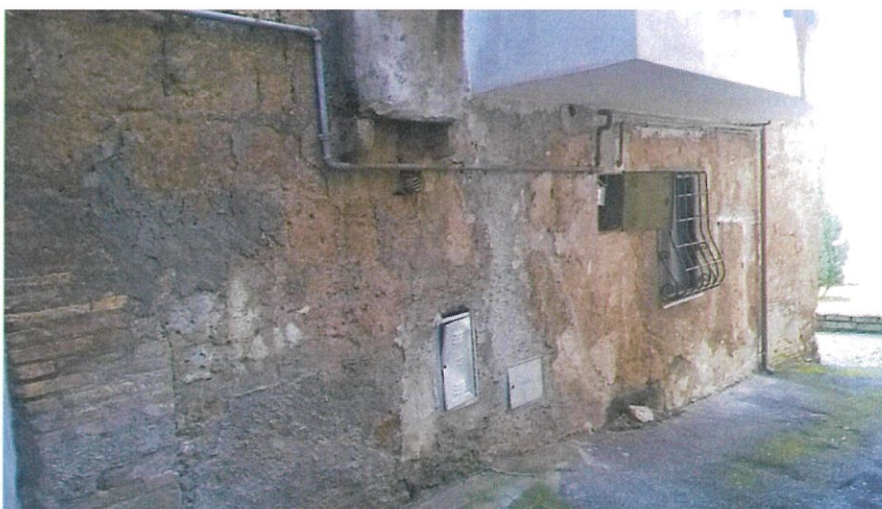
Foto n. 11 Esterno da vicolo S. Giovanni
