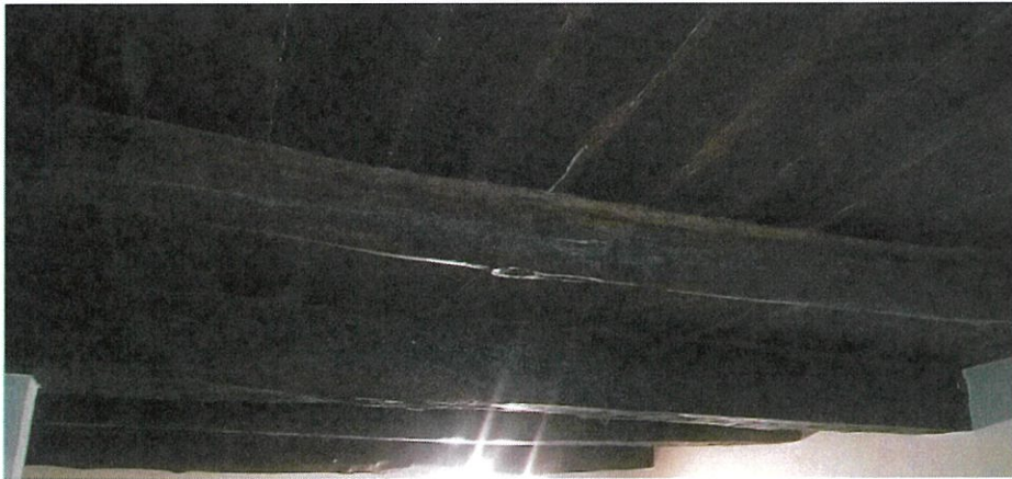
Foto n. 4 soffitto in travi di legno
