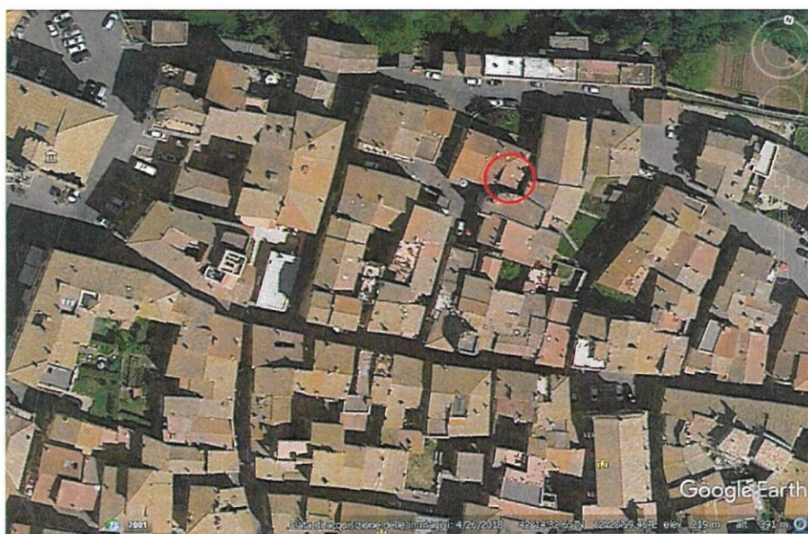
Foto n. 12 Individuazione dell'immobile nel tessuto urbano del centro storico di Nepi
