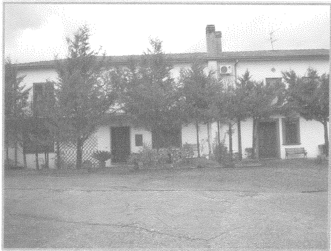
Fabbricato C (lotti V-VI)
