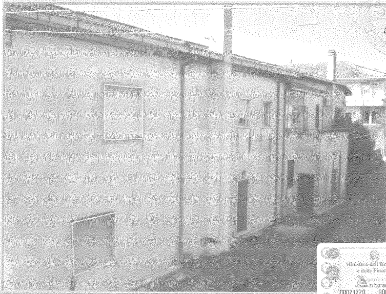
Fabbricato C (lotti V-VI)
