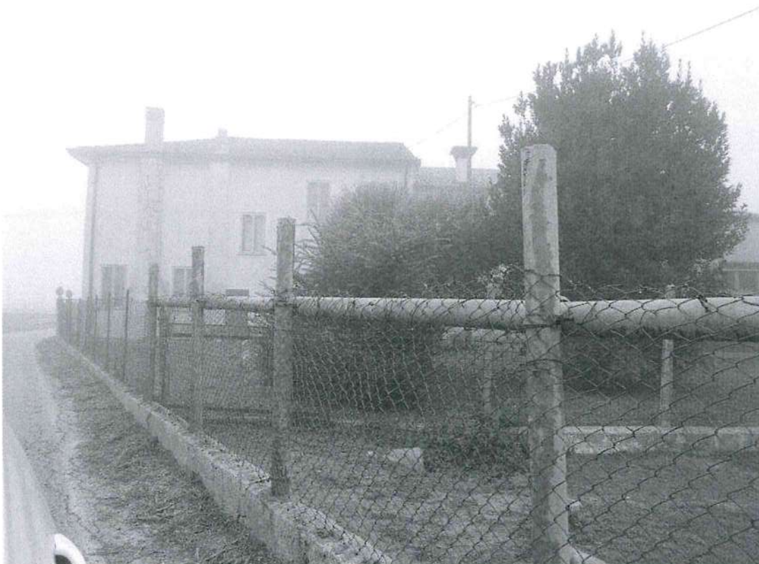
Foto 5: Abitazione (mapp. 405 sub. 2), prospetto nord, vista da via Quarrin
