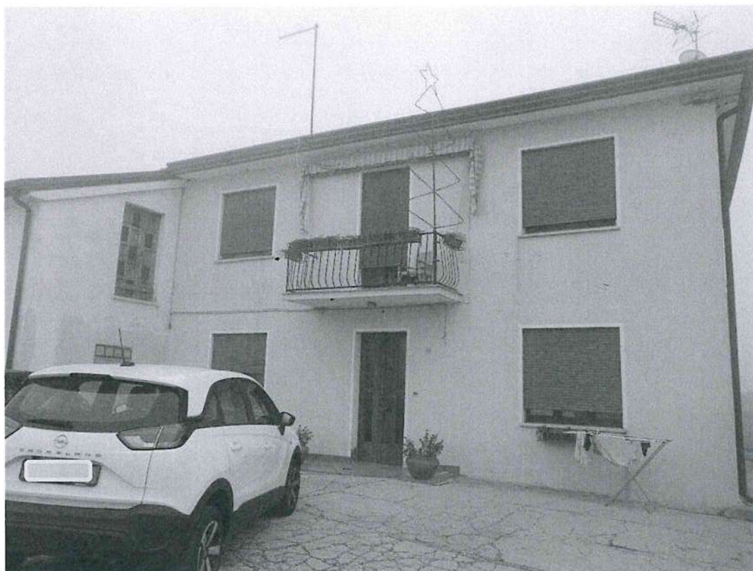
Foto 1: Abitazione (mapp. 405 sub. 2), prospetto principale sud
