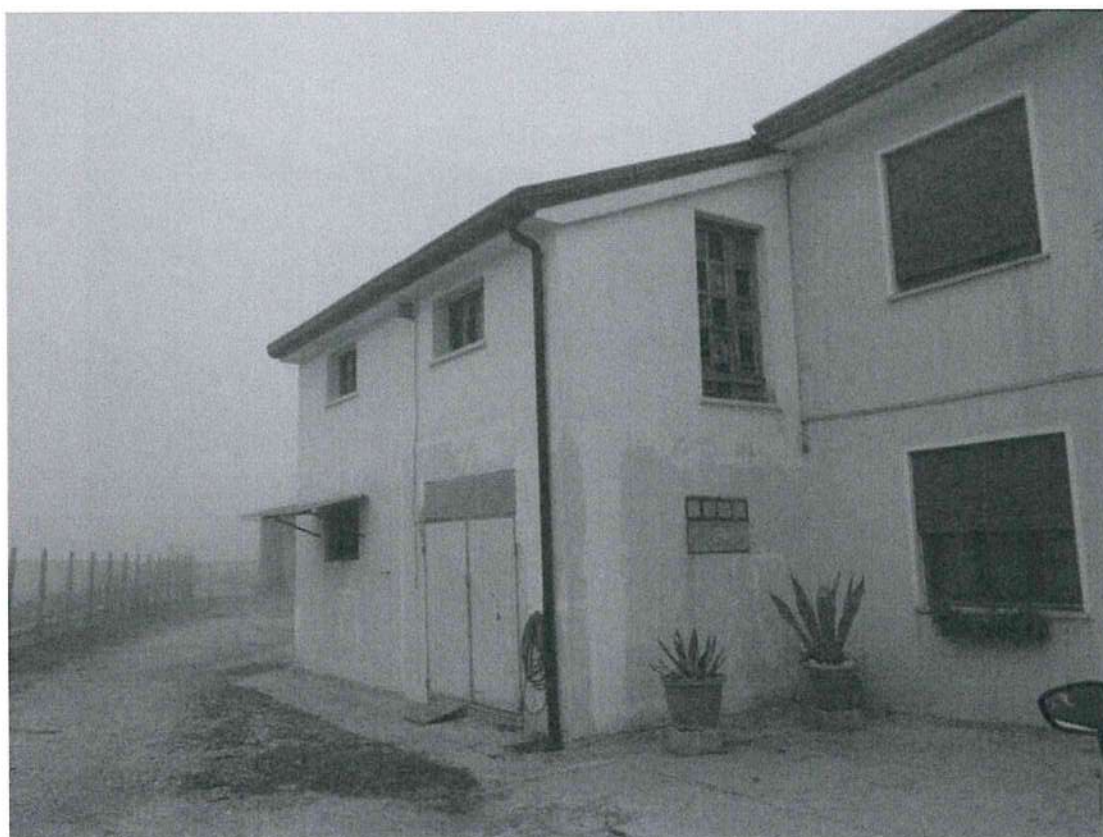
Foto 2: Abitazione (mapp. 405 sub. 2), prospetto principale sud
