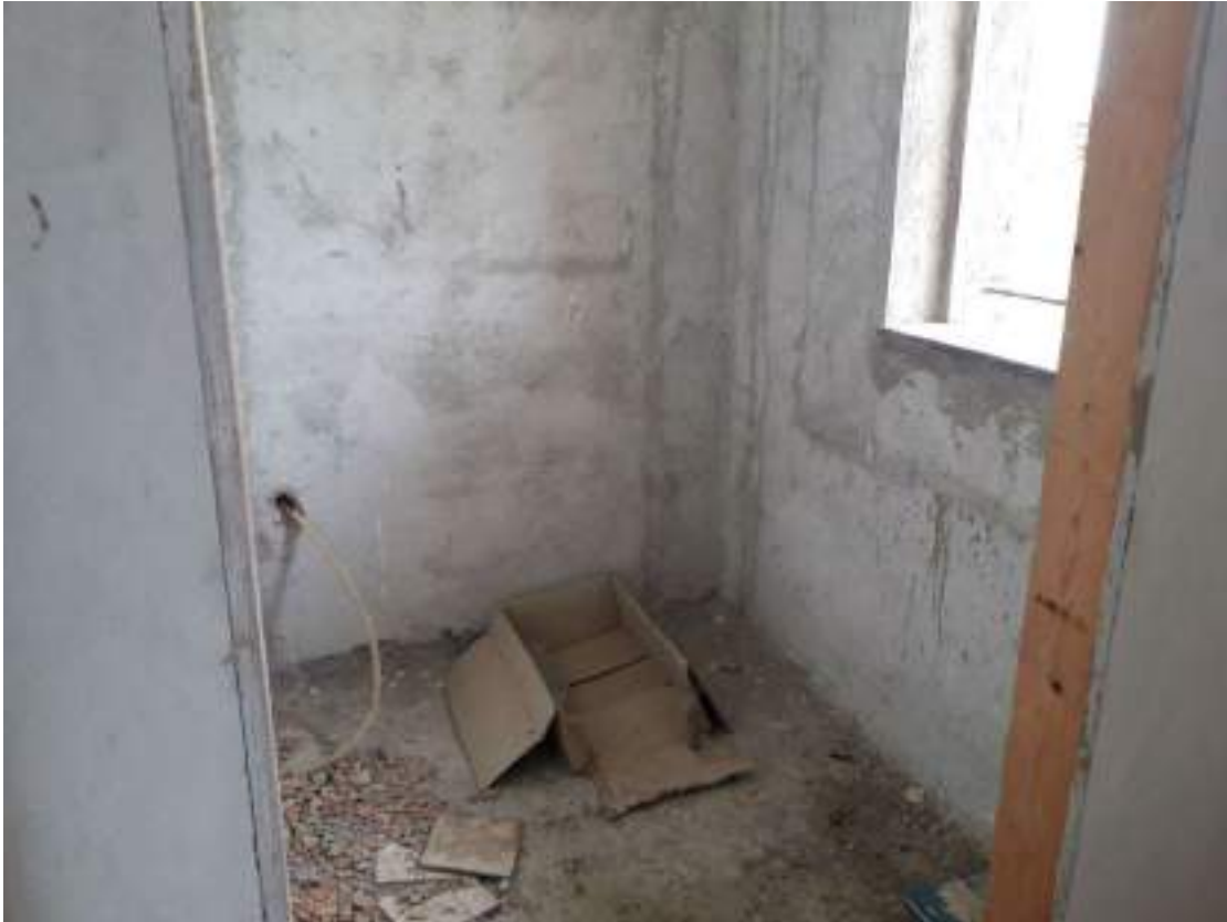
Foto N.11: immobile oggetto di stima sub 3 in corso di costruzione - bagno
