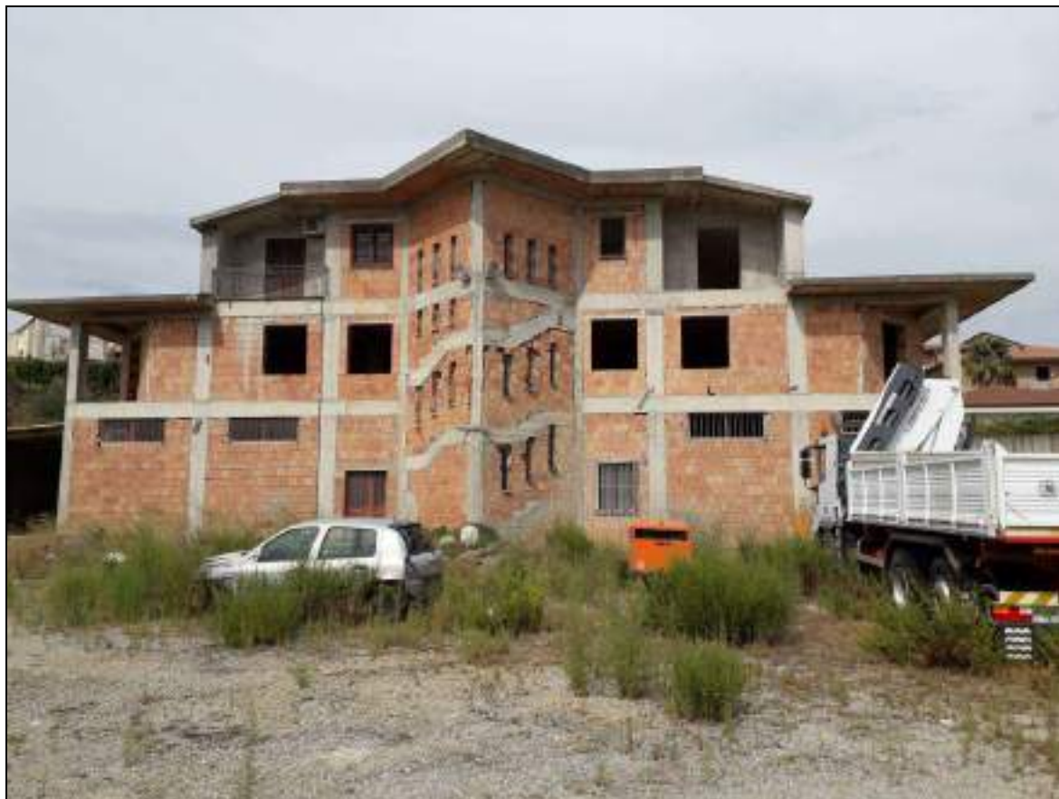
Foto N.1: Prospetto Sud dell'immobile oggetto di stima.
