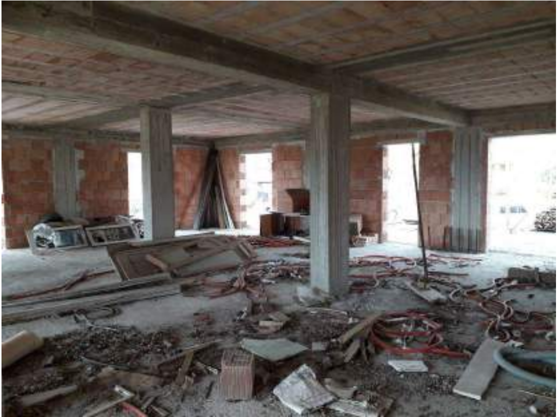
Foto N.7: immobile oggetto di stima sub 1
