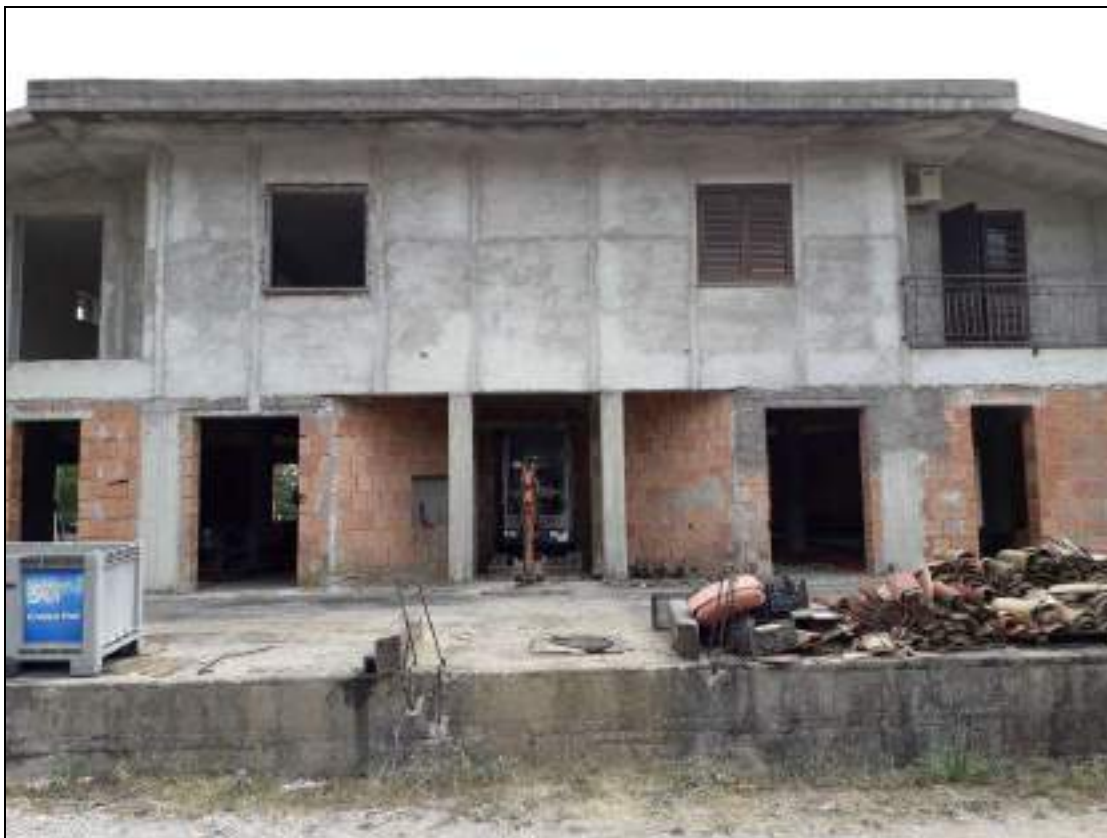
Foto N.3: Prospetto Nord dell'immobile oggetto di stima.
