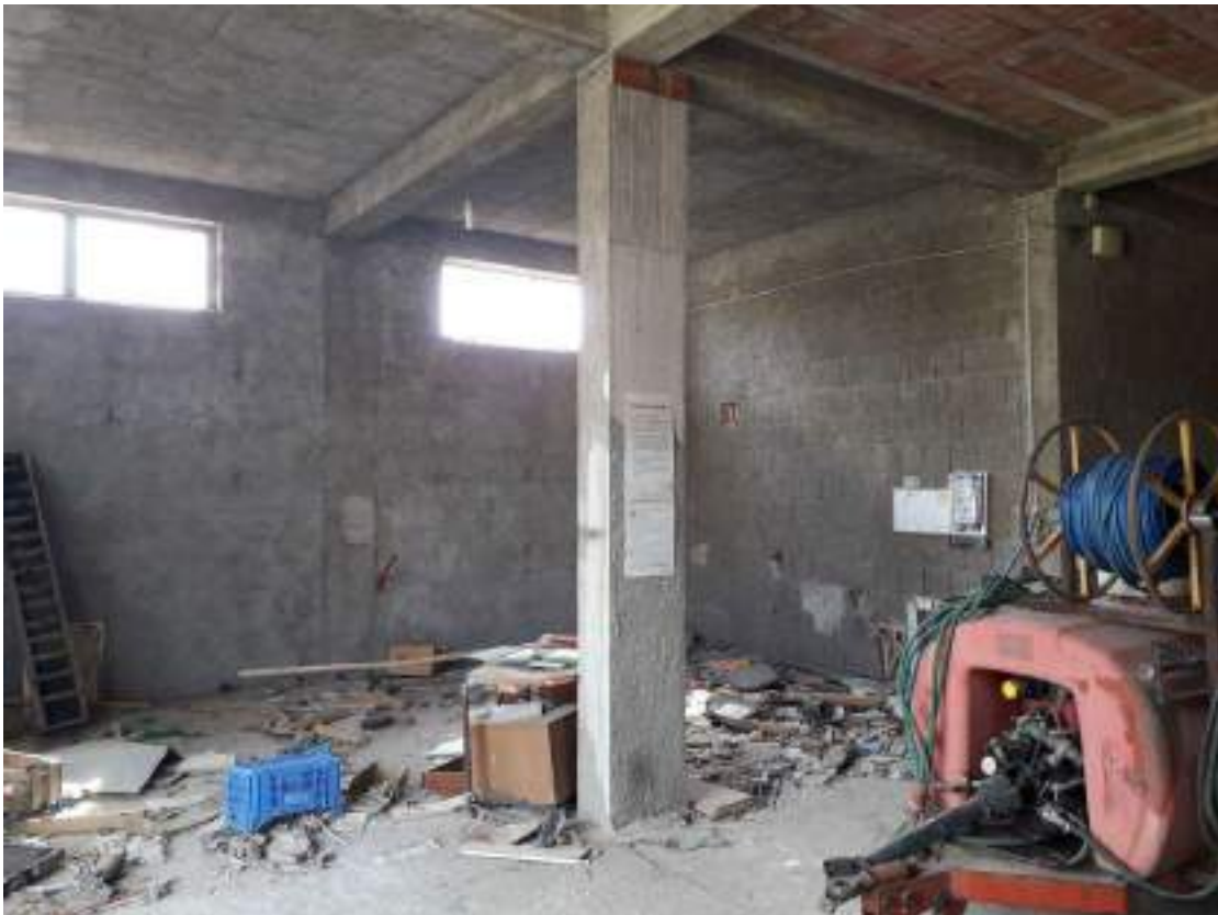
Foto N.19: Sub 5 locali magazzini in corso di costruzione
