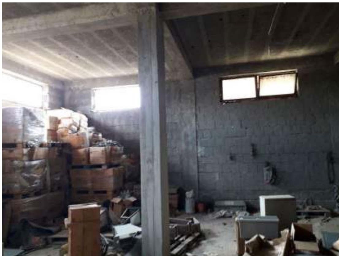
Foto N.22: Sub 5 locali magazzini in corso di costruzione
