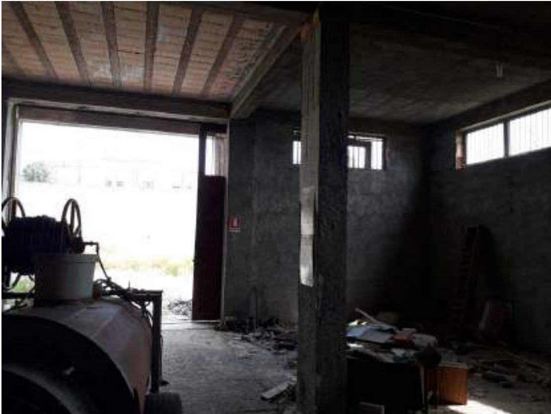
Foto N.18: Sub 5 in corso di costruzione - Ingresso
