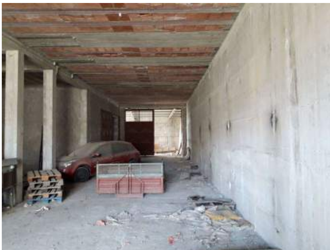
Foto N.21: Sub 5 locali magazzini in corso di costruzione
