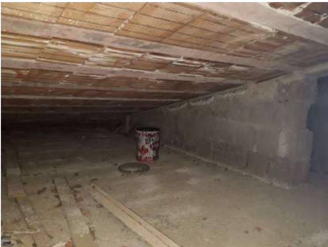
Foto N.12: immobile oggetto di stima sub 3 vano non utilizzabile sottotetto
