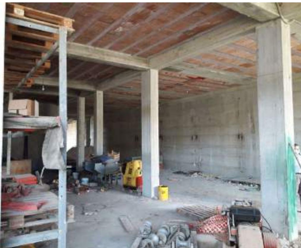
Foto N.20: Sub 5 locali magazzini in corso di costruzione
