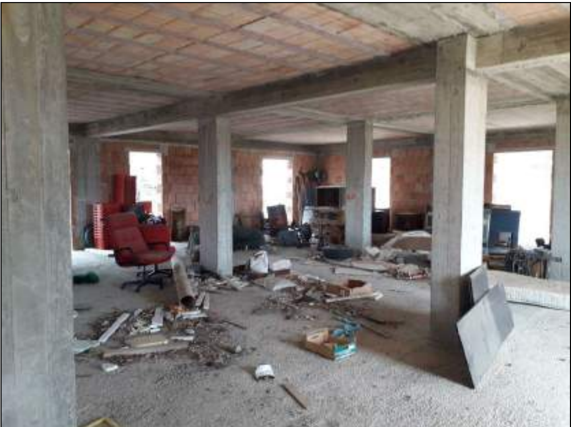
Foto N.8: immobile oggetto di stima sub 2
