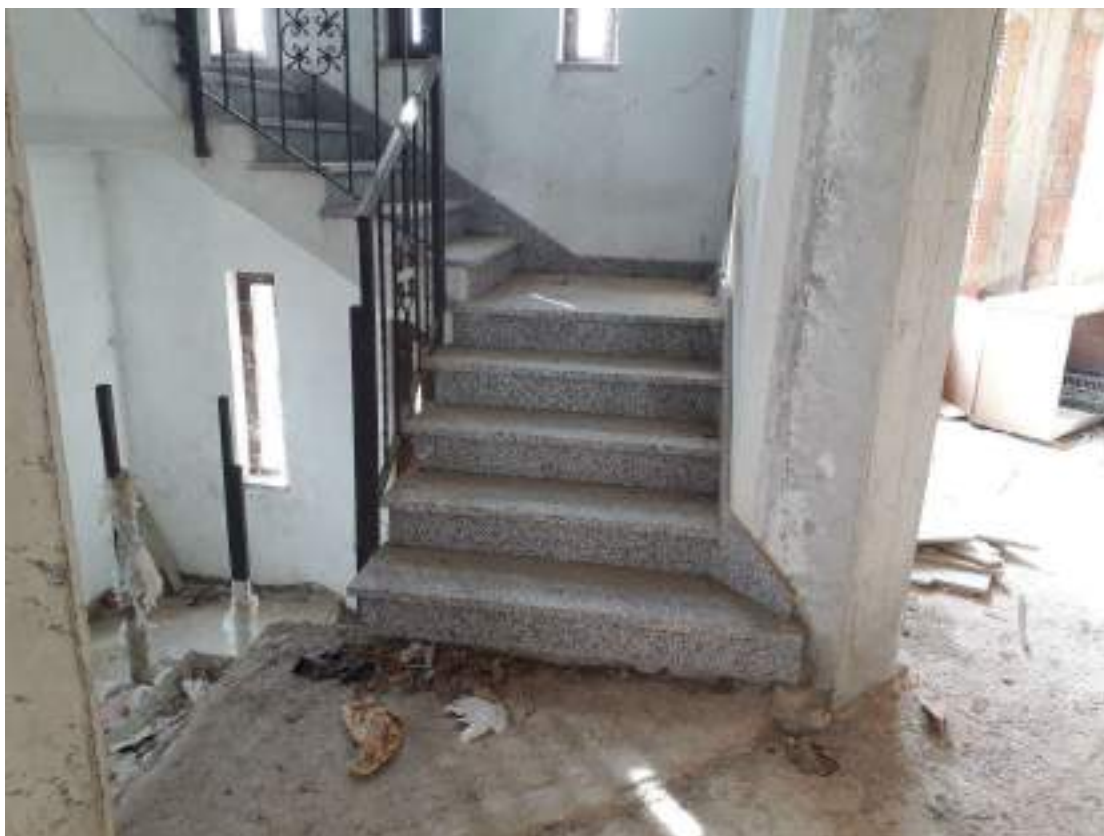
Foto N.6: Corpo scala sub 6
