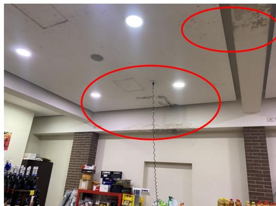
Foto 11: Magazzino 1\_Particolare infiltrazioni
