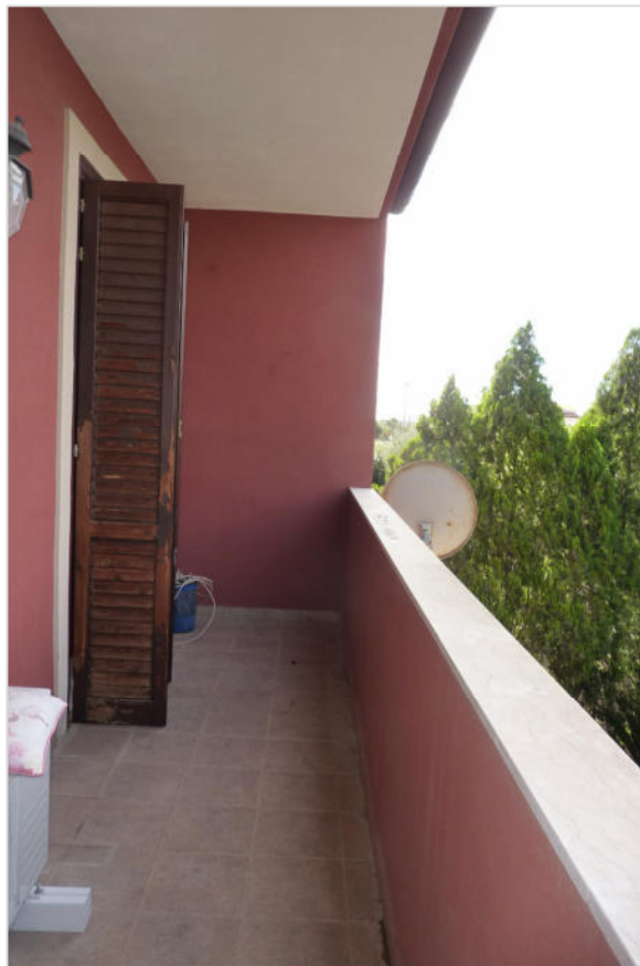
FOTO 2 PROSPETTO LATO NORD – PIANO PRIMO
