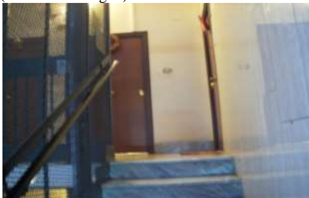
(foto 6: vista porta d'ingresso)
