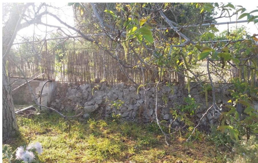
Foto 29 – Muro di recinzione perimetrale
