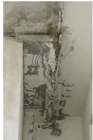
Infiltrazioni su ing esterno scala-ing interno e ripostiglio P1
