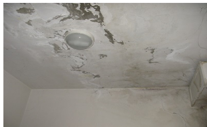
Infiltrazioni su ing esterno scala-ing interno e ripostiglio P1
