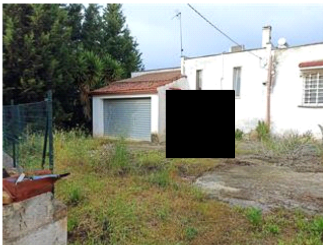
Vista fronte a ovest
