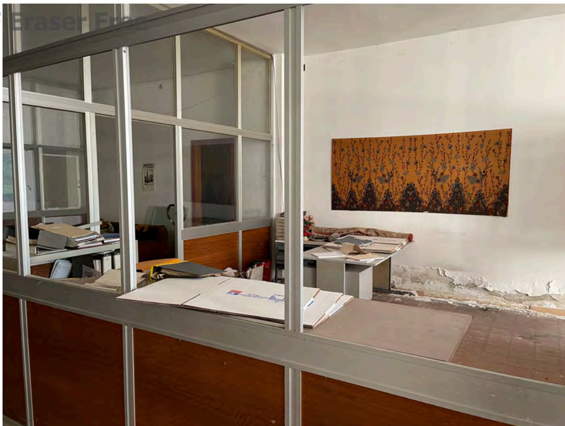
Foto 17 uffici piano terra fg. 18 - p.lla 201 NTC Fg. 7 p.lla 1121
