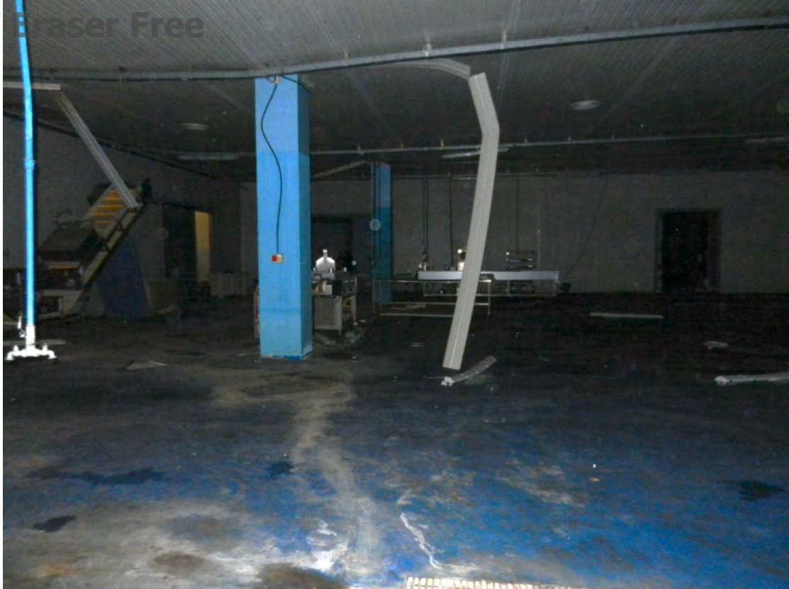
Foto 7 zona lavorazione fg. 18 - p.lla 201 NTC Fg. 7 p.lla 1121
