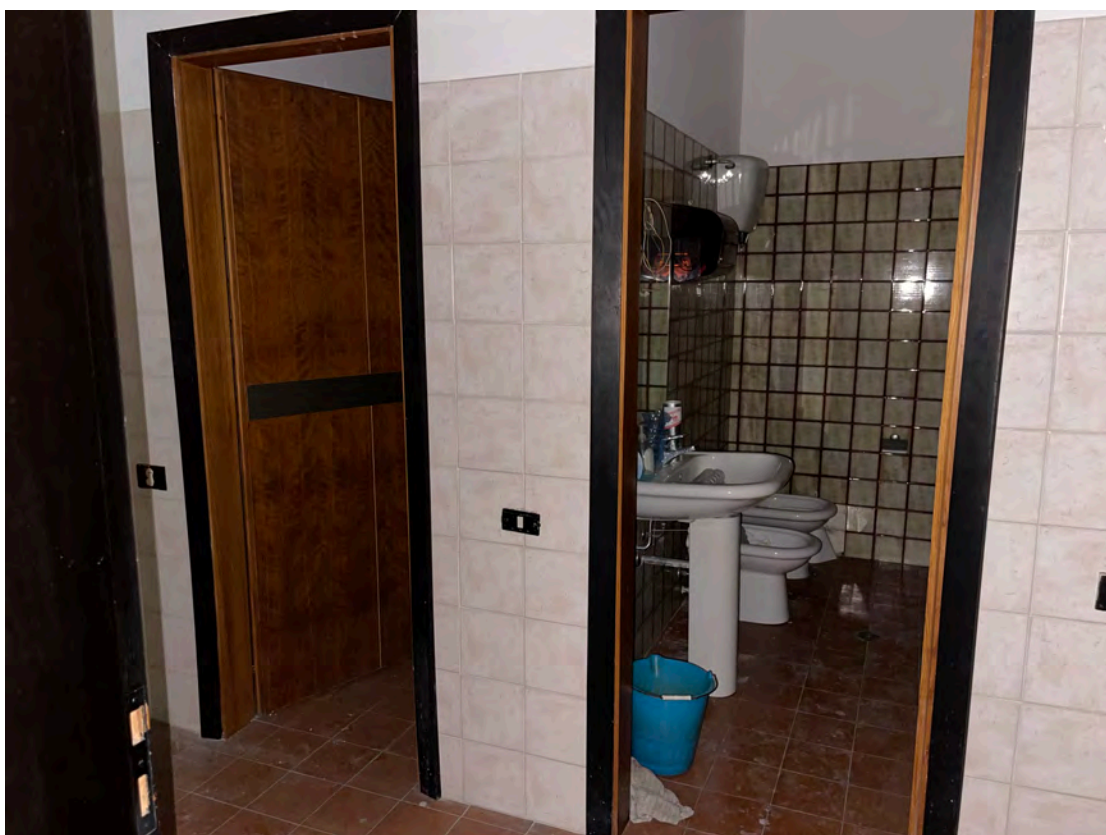
Foto 26 WC P.T.-rialzato fg. 18 - p.lla 201 NTC Fg. 7 p.lla 1121
