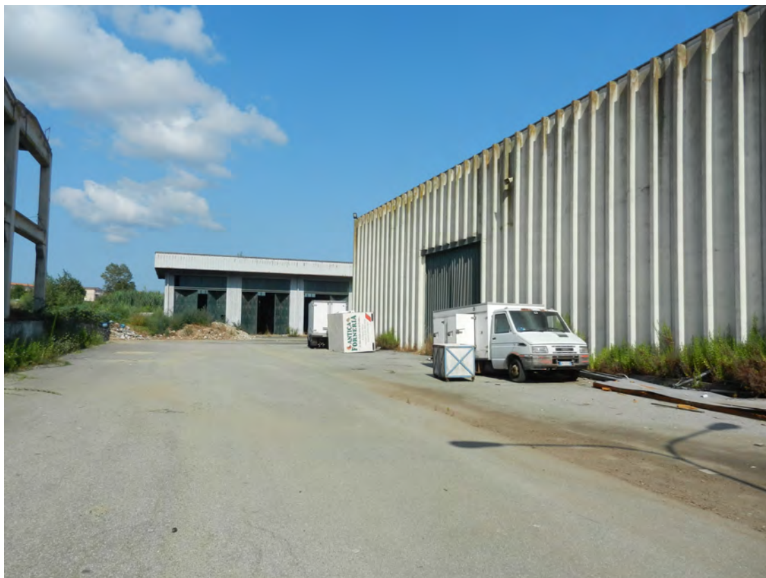
Foto 4 area interna-capannone-deposito fg. 18 p.lla 201 NCT Fg. 7 p.lla 1121
