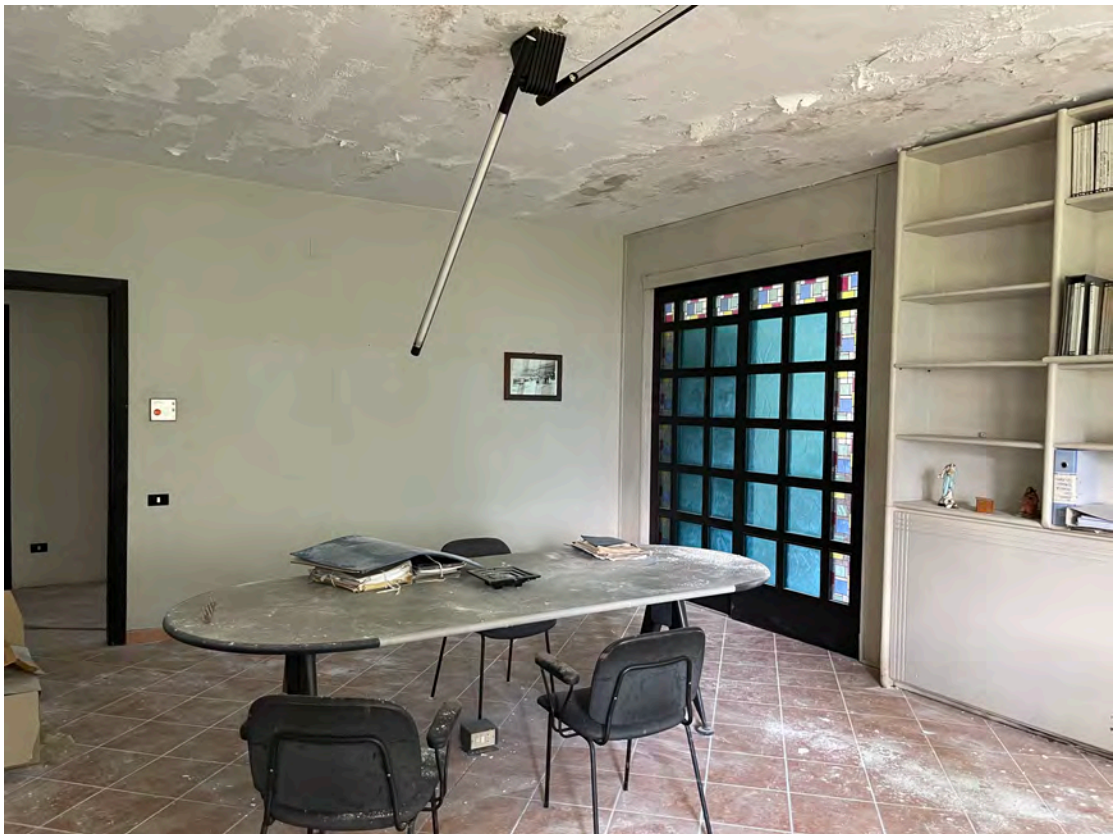
Foto 22 uffici P.T.-rialzato fg. 18 - p.lla 201 NTC Fg. 7 p.lla 1121
