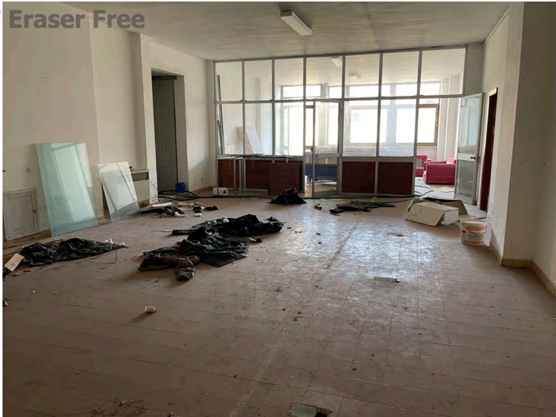
Foto 15 uffici piano terra fg. 18 - p.lla 201 NTC Fg. 7 p.lla 1121
