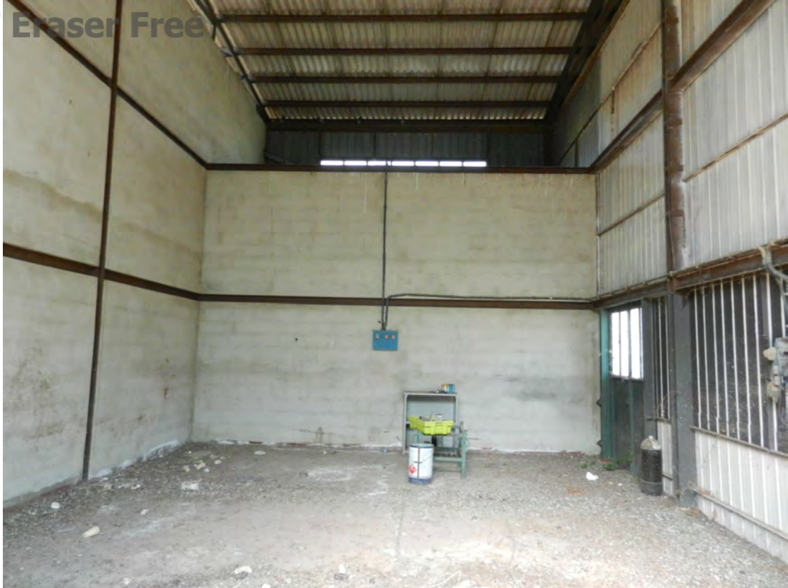
Foto 13 deposito fg. 18 - p.lla 201 NTC Fg. 7 p.lla 1121
