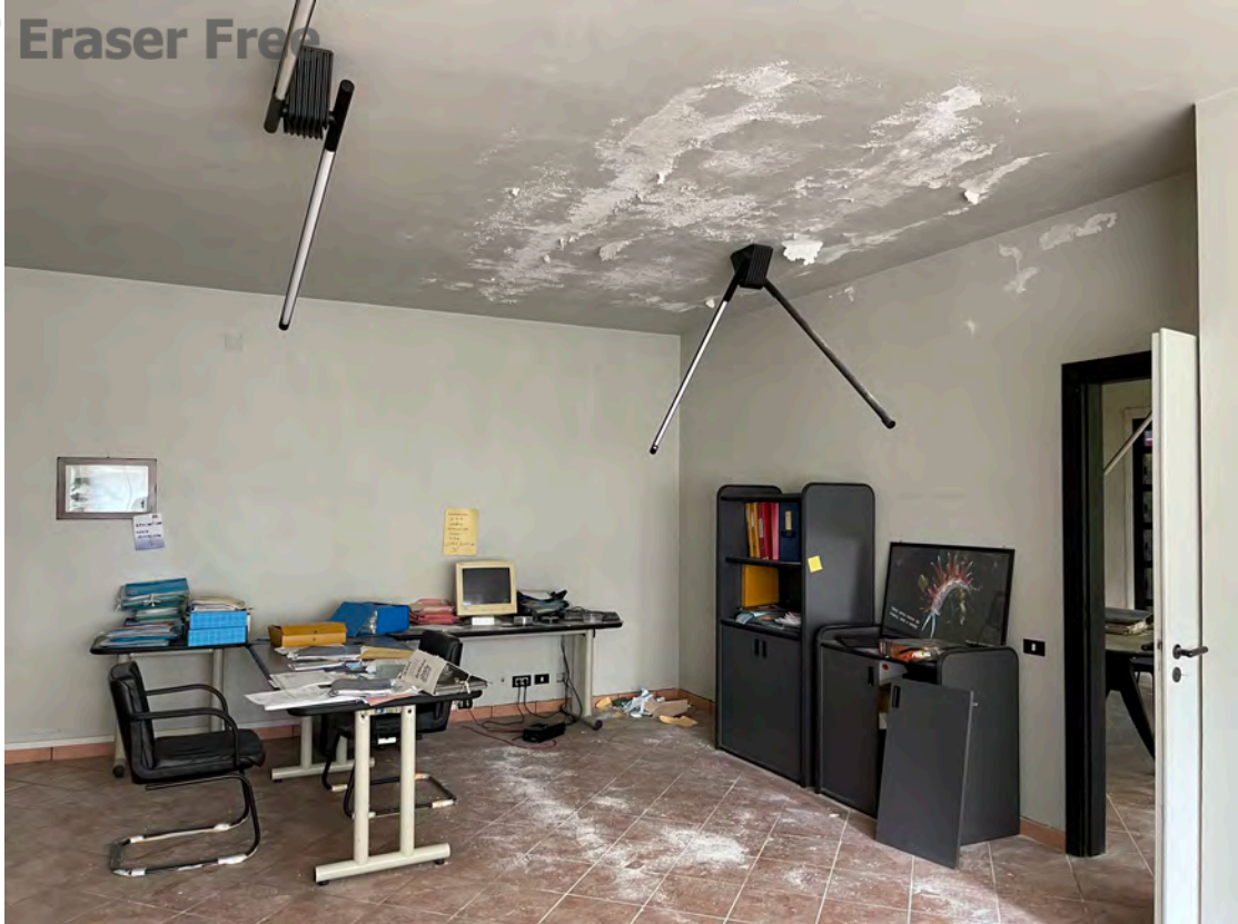
Foto 21 uffici P.T.-rialzato fg. 18 - p.lla 201 NTC Fg. 7 p.lla 1121
