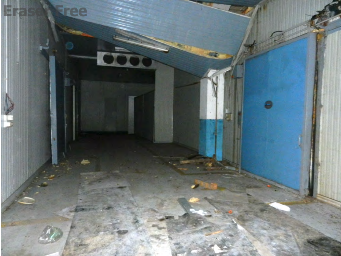
Foto 9 celle frigorifere fg. 18 - p.lla 201 NTC Fg. 7 p.lla 1121
