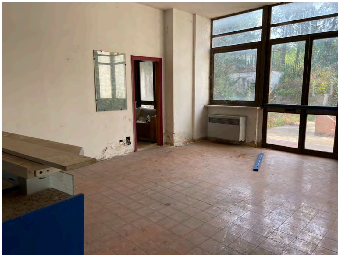
Foto 16 uffici piano terra fg. 18 - p.lla 201 NTC Fg. 7 p.lla 1121
