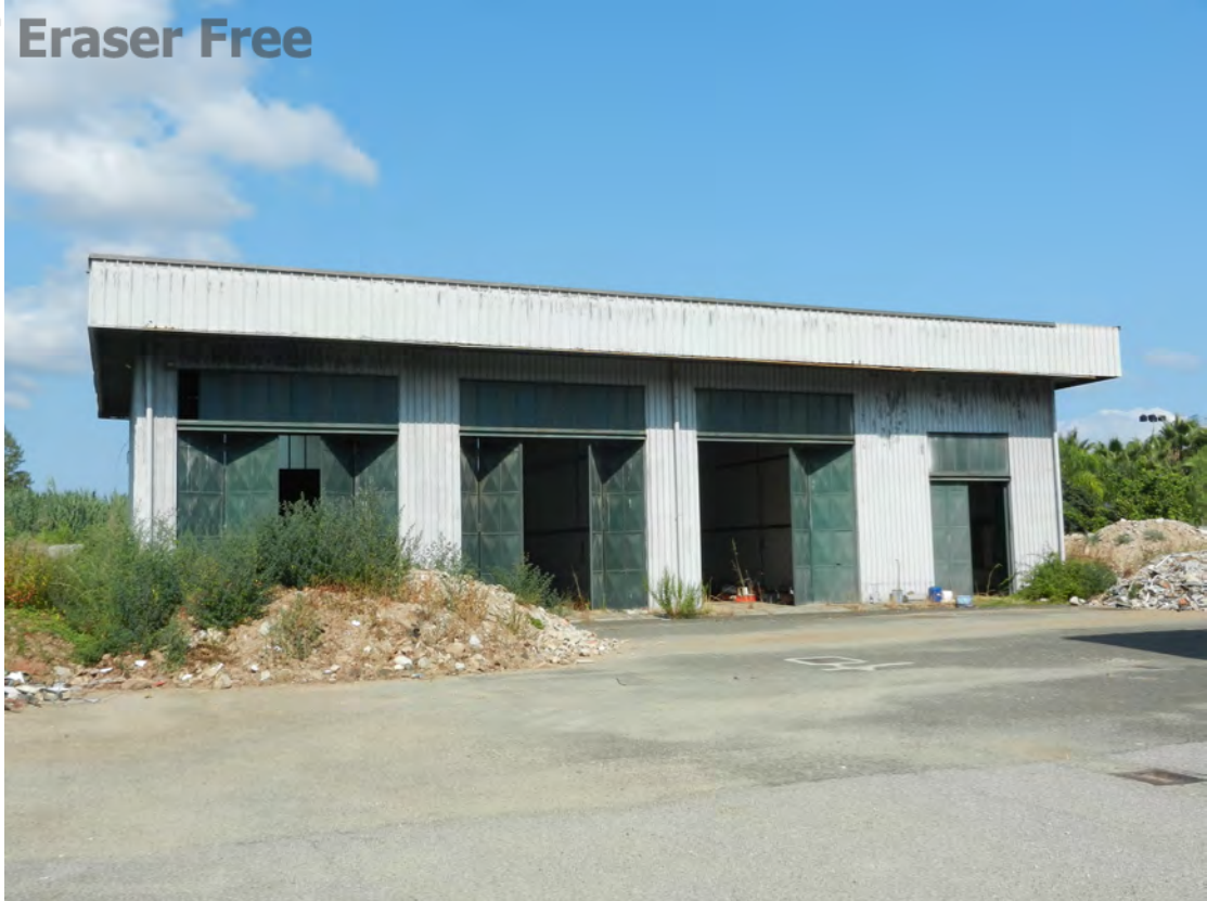
Foto 5 deposito fg. 18 - p.lla 201 NTC Fg. 7 p.lla 1121
