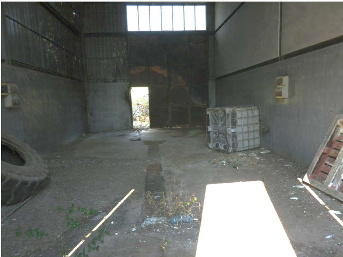
Foto 14 deposito fg. 18 - p.lla 201 NTC Fg. 7 p.lla 1121
