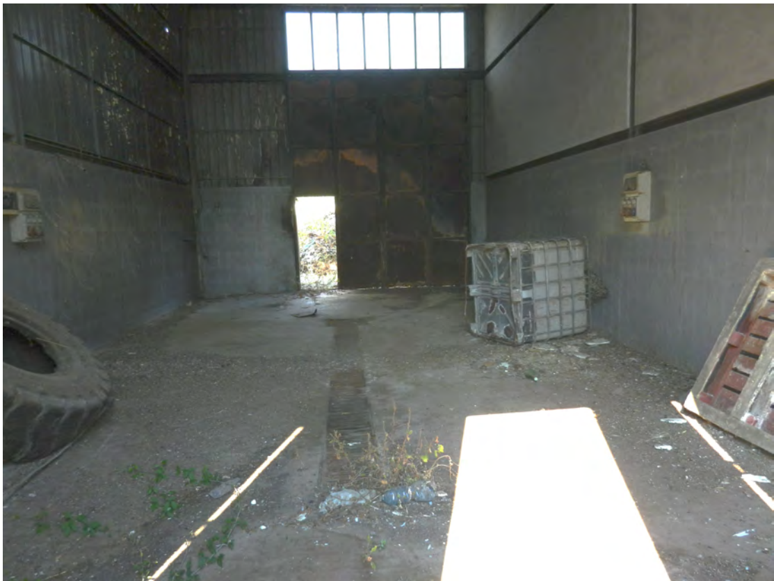
Foto 14 deposito fg. 18 - p.lla 201 NTC Fg. 7 p.lla 1121
