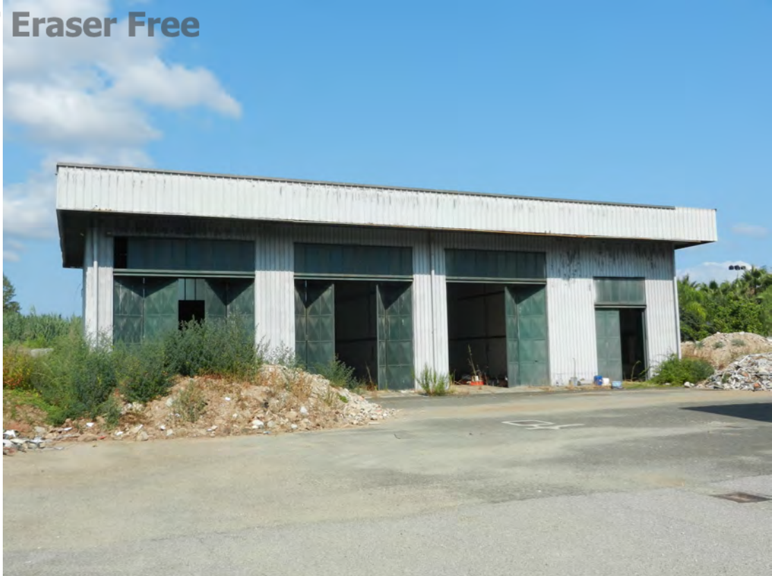
Foto 5 deposito fg. 18 - p.lla 201 NTC Fg. 7 p.lla 1121
