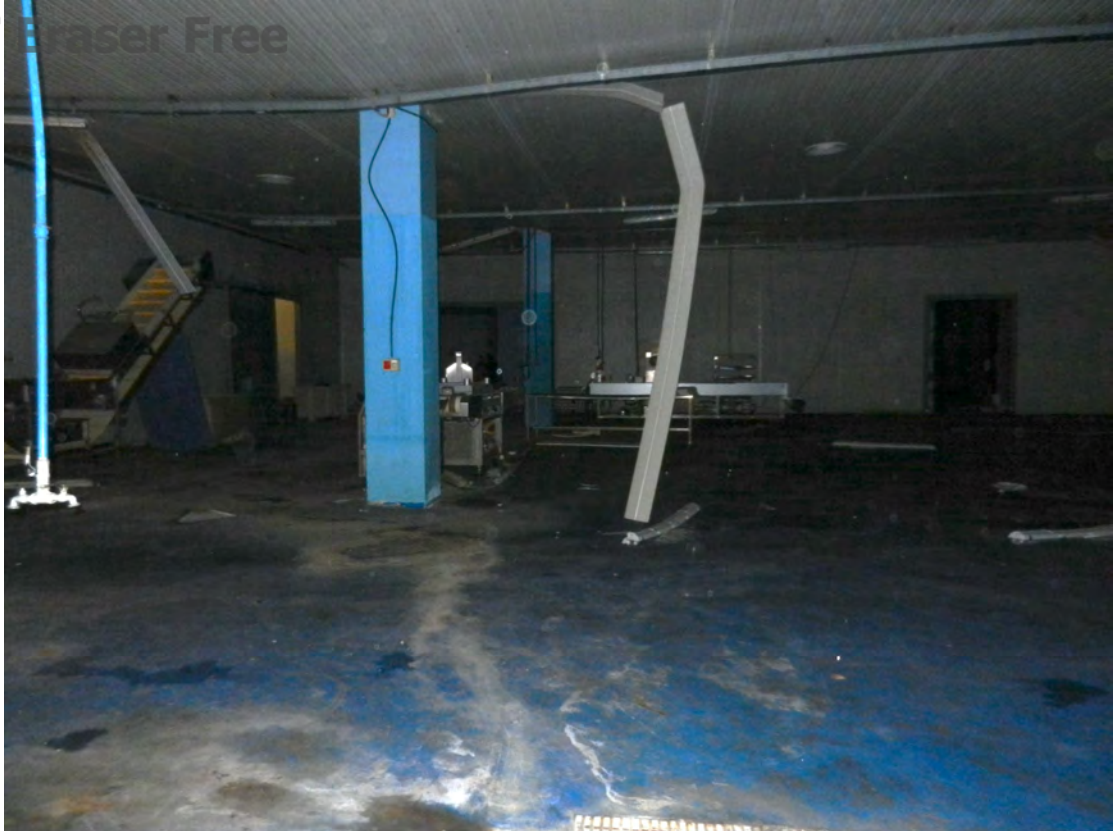
Foto 7 zona lavorazione fg. 18 - p.lla 201 NTC Fg. 7 p.lla 1121
