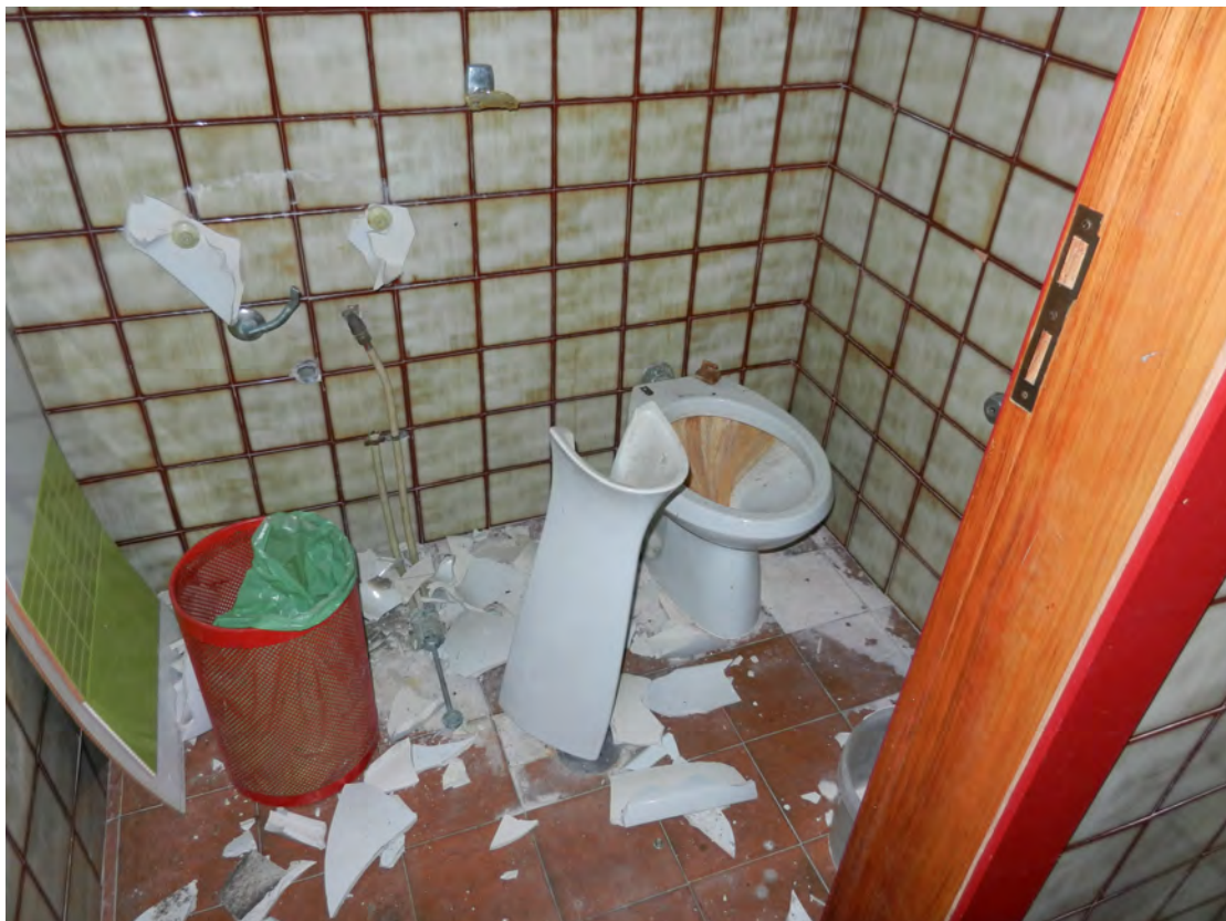
Foto 18 bagni piano terra fg. 18 - p.lla 201 NTC Fg. 7 p.lla 1121
