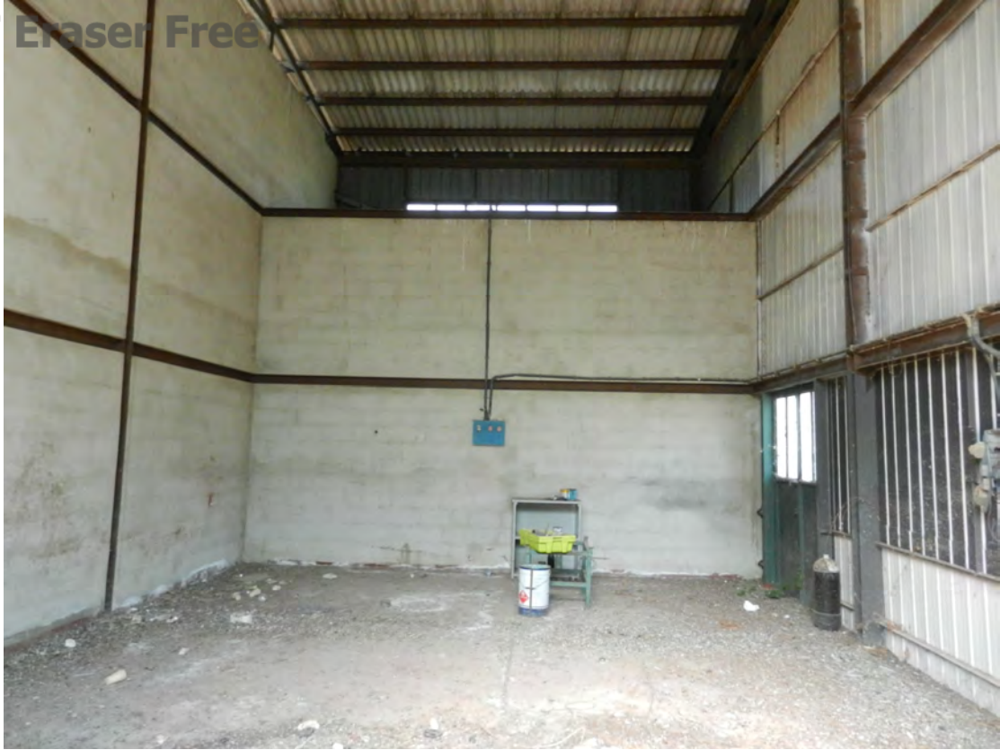
Foto 13 deposito fg. 18 - p.lla 201 NTC Fg. 7 p.lla 1121
