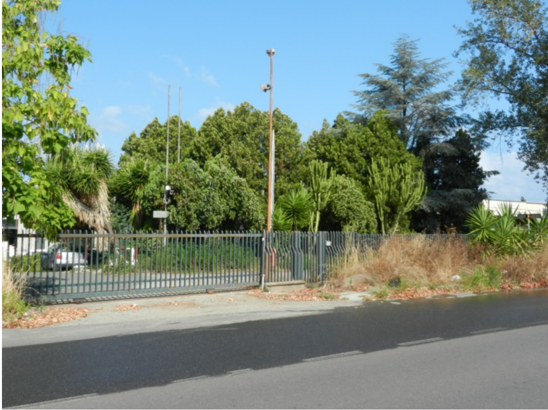
Foto 1 corte – ingresso area N.C.T. fg. 7 - p.lle 1122-1123
