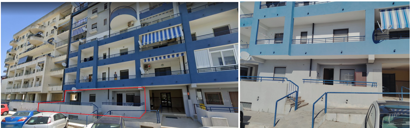
Foto 8 e 9- prospetto ovest del fabbricato ed individuazione dell'appartamento
