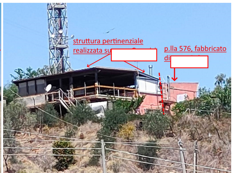
Foto 17- identificazione delle 2 porzioni di fabbricato
