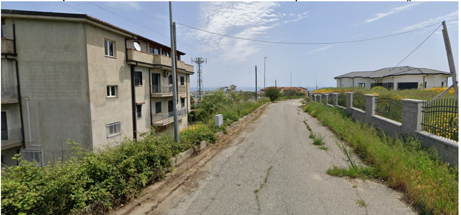
Foto 29- fabbricati lungo via degli Arbusti in prossimità del lotto
