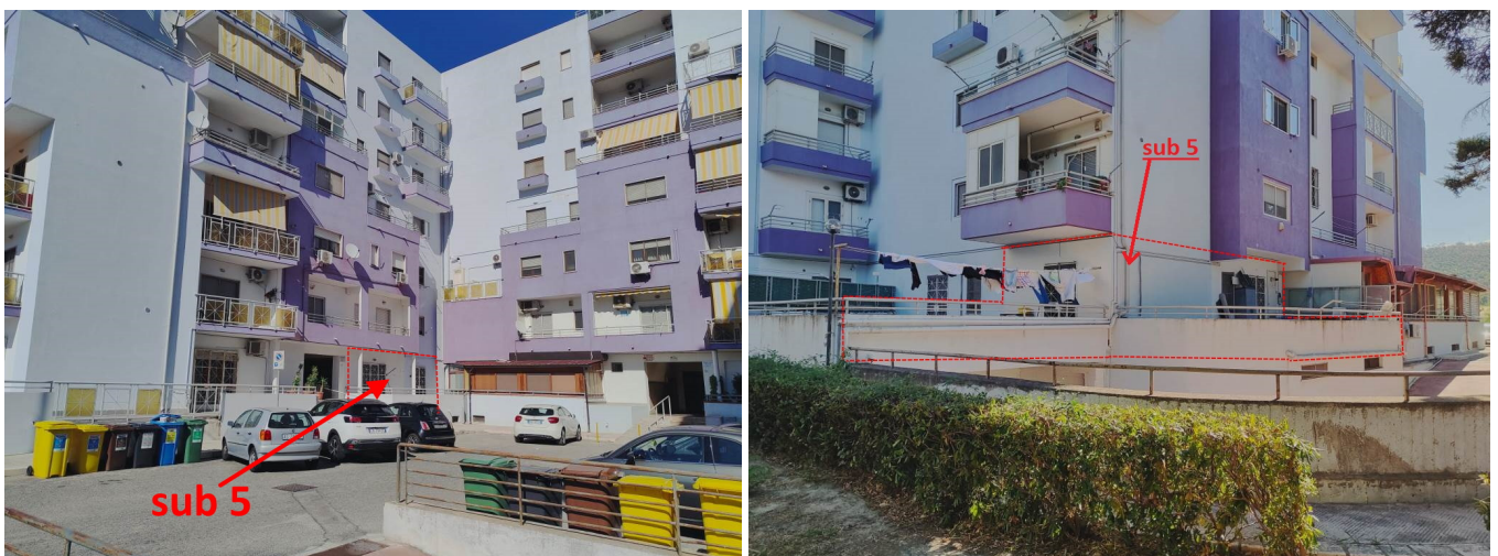
Foto 1 e 2- prospetti del fabbricato ed individuazione dell'appartamento
