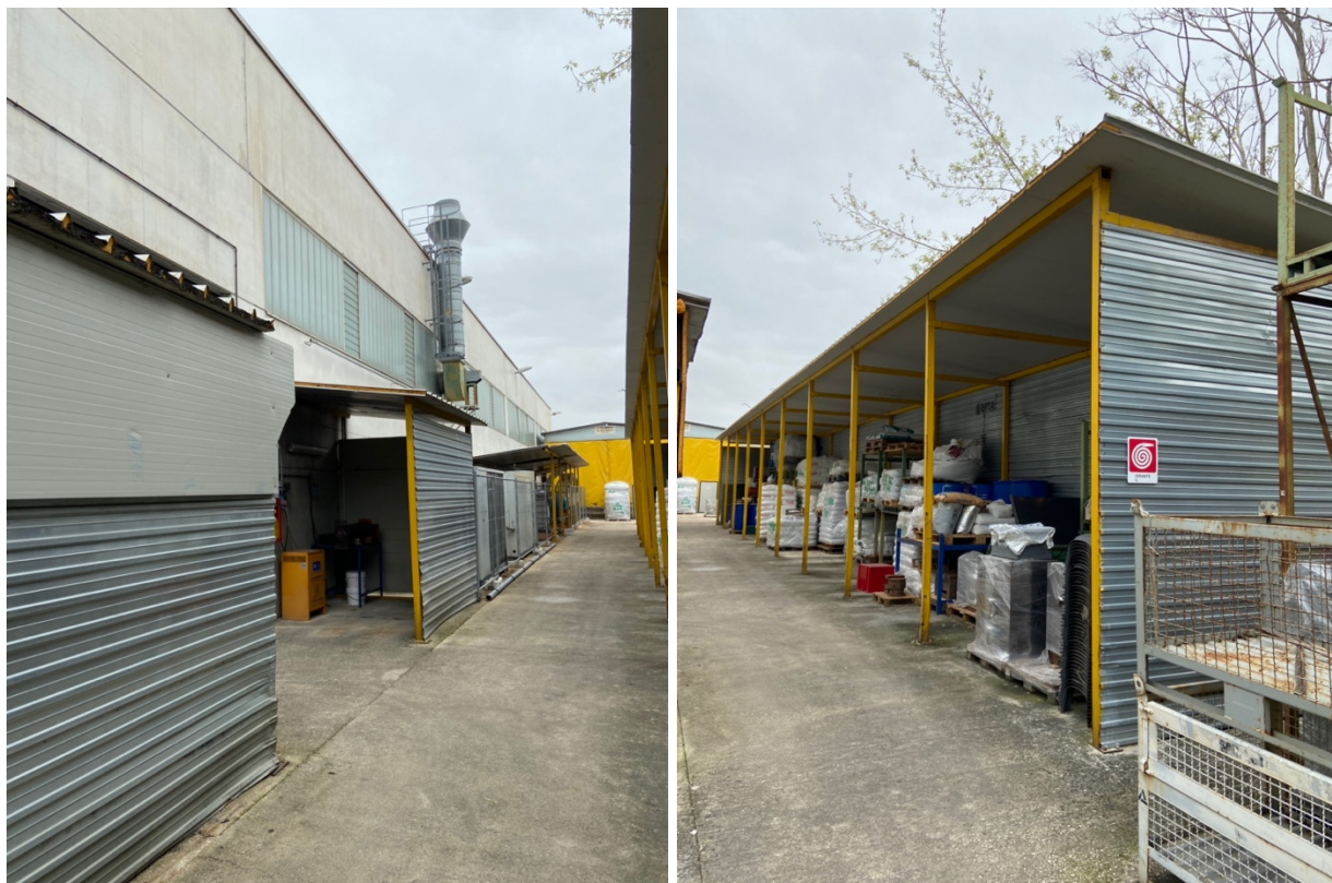
Figura 4. Foto esterna del fabbricato fg. 19, P.lla 215 – LOTTO 2 – tettoie lato opposto alla strada
