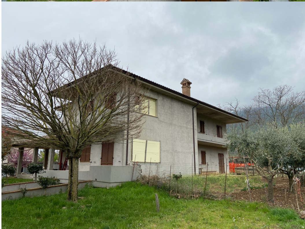
Figura 8. Foto esterne del fabbricato fg. 25, P.lla 142 – LOTTO 4
