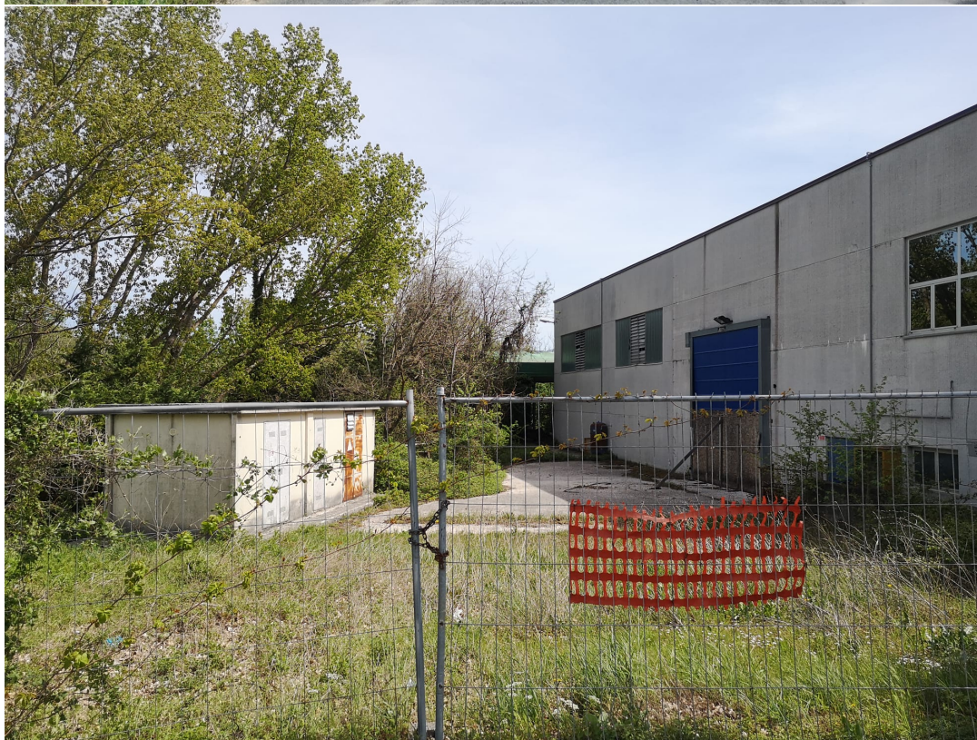
Figura 1. Foto esterna del fabbricato fg. 19 -P.Ila 178 - LOTTO 1
