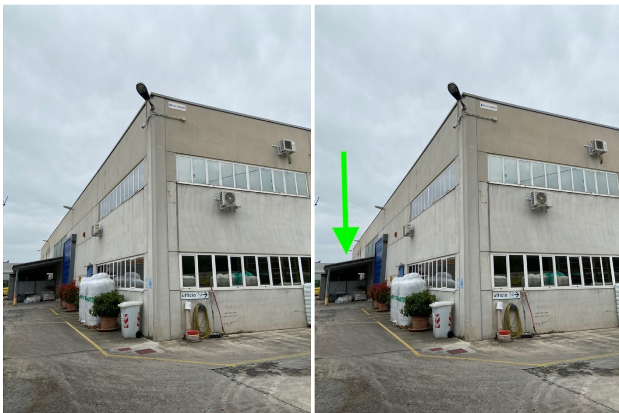
Figura 5. Foto esterna del fabbricato fg. 19, P.lla 215 – LOTTO 2 – evidenza di tettoia in acciaio lato strada e ingresso principale
