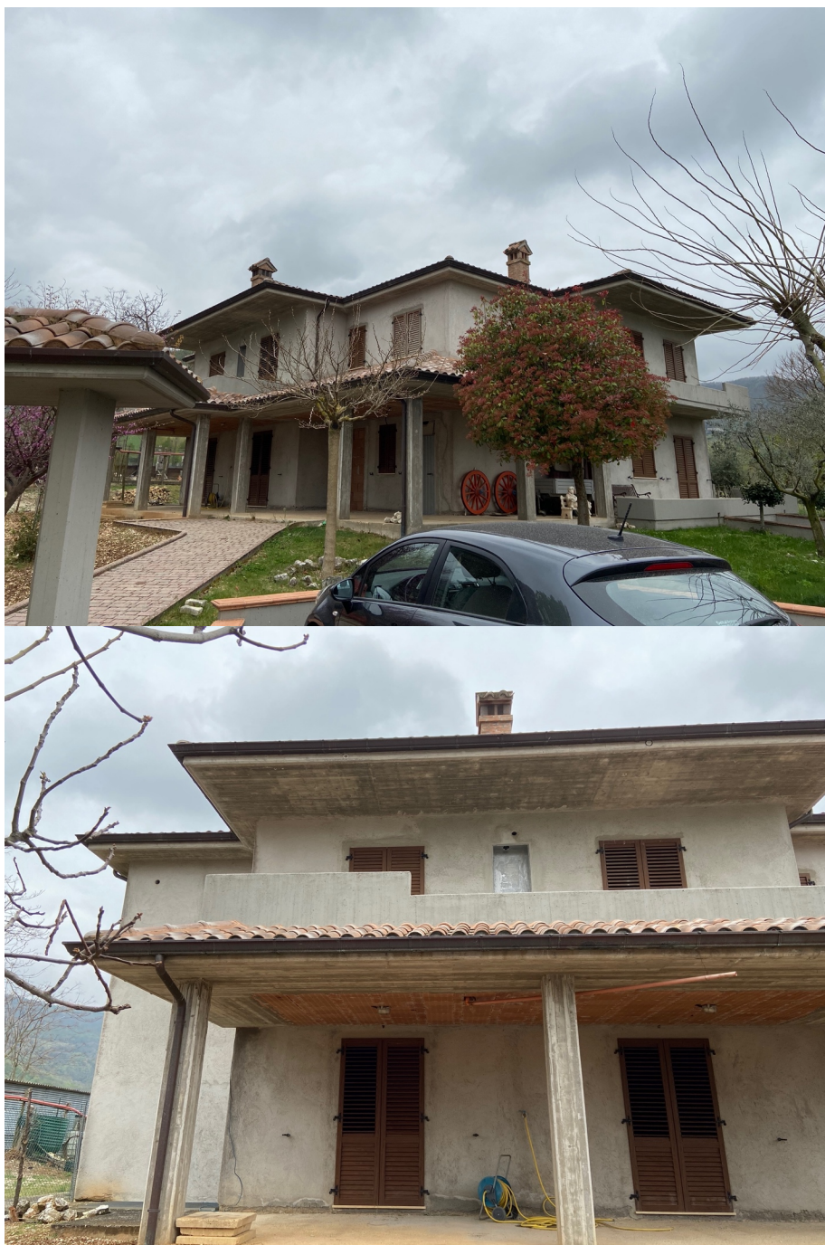
Figura 7. Foto esterne del fabbricato fg. 25, P.lla 142 – LOTTO 4
