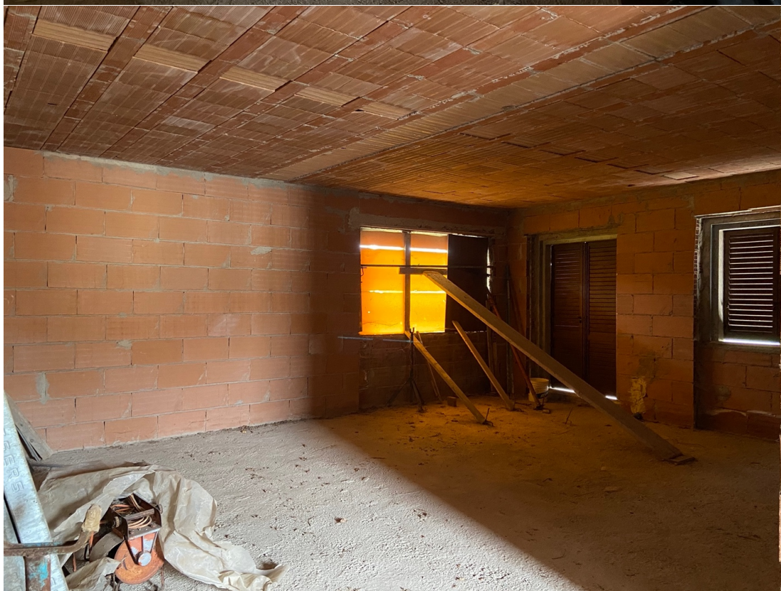
Figura 9. Foto interne del fabbricato fg. 25, P.lla 142 – LOTTO 4
